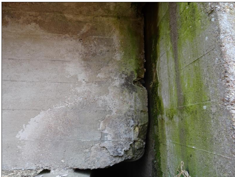
7.JPG Fasáda konce levého krajního trámu (konc. příčniku) u ZZ Op1. Lokál. odpad krycí vrstvy výztuže. Stopy zátoků dil. spárou, mapy výluh a uchycených řas.
