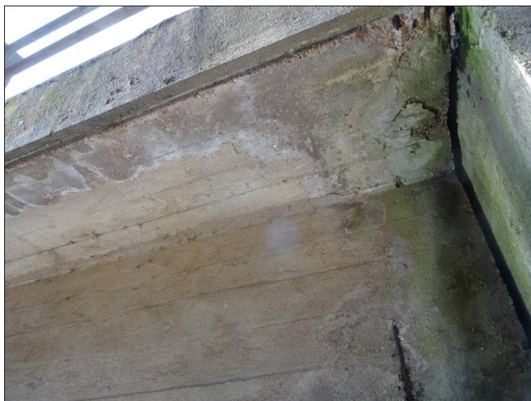
35.JPG Pravý konec NK u dil. spáry nad Op3. Stopy zátoků na podhledu konzoly mostovky a v oblasti dilatač. spáry mezi NK a ZZ, které jsou zvýrazněné mapami stoků a uchycených řas.
