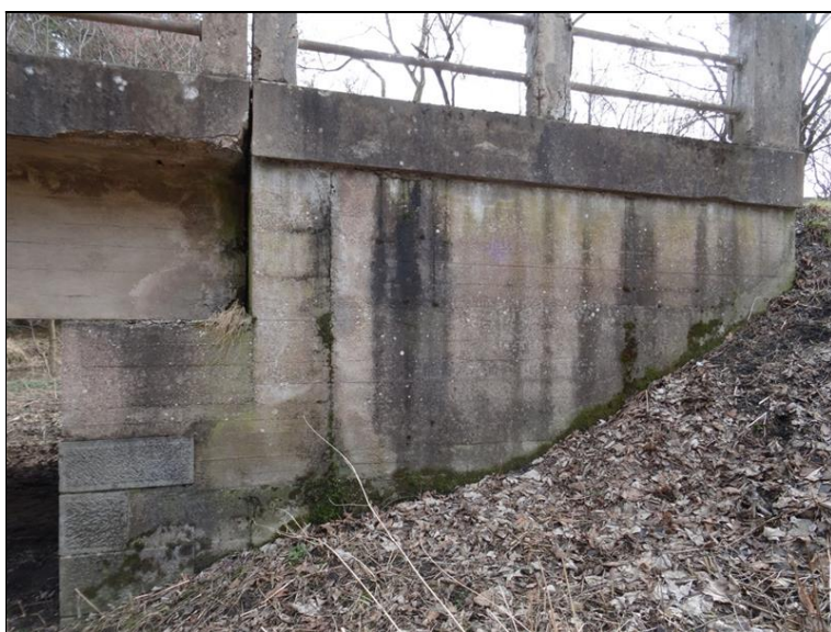
6.JPG Celkový pohled na levý bok Op1. Patrné průsaky dilat. spárou (bok NK nad Op) a svislou spárou mezi Op a křídlem. Na betonu křídla výrazné stokové mapy z pod římsy, místy uchycené lišejníky.
