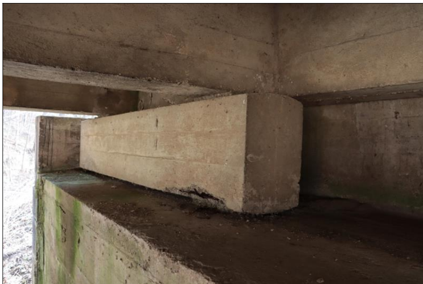
10.JPG Obnažená výztuž v místě lokálně odpadlé krycí vrstvy na dolní hraně pravé kyvné stojky na Op1.
