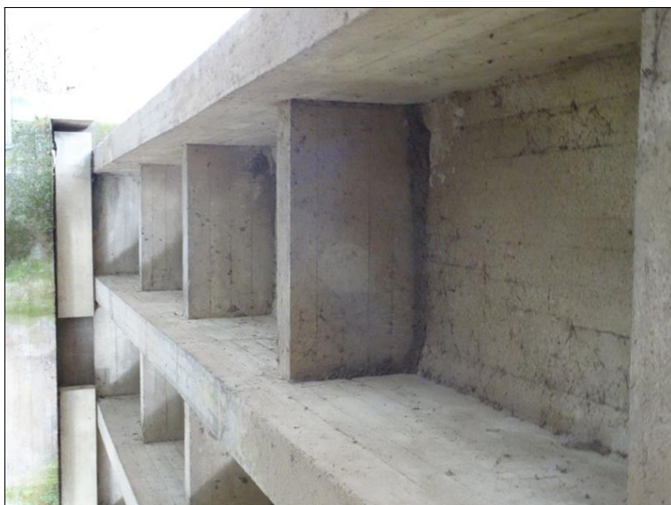
26.JPG Podhled levé strany NK (mezi 1. a 2. trámem). V koutech stopy lokálních průsaků mostovkou.
