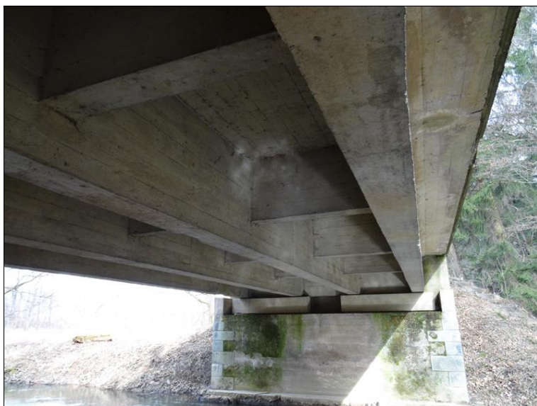
32.JPG Mapy průsaků na podhledu pravé mostovkové konzoly.
