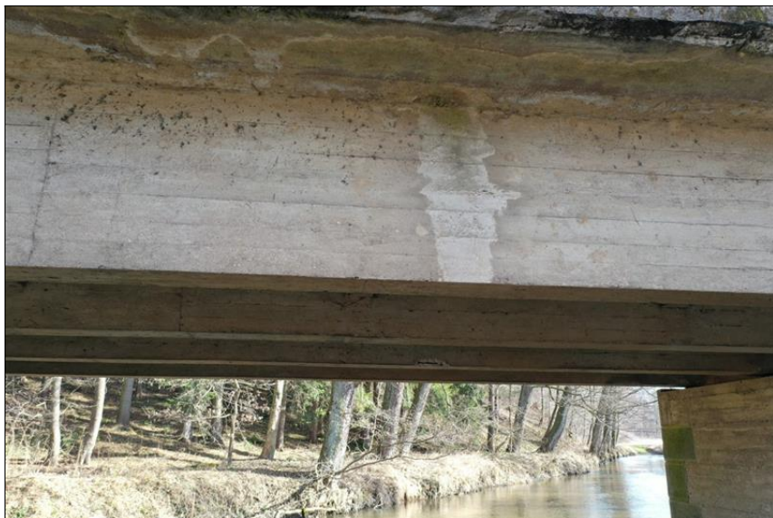
25.JPG Levá fasáda NK 2. mostního pole cca 1. třetině (od P2). Na povrchu betonu mapy od zátoků a stoků způsobených průsaky přes konzolu mostovky.
