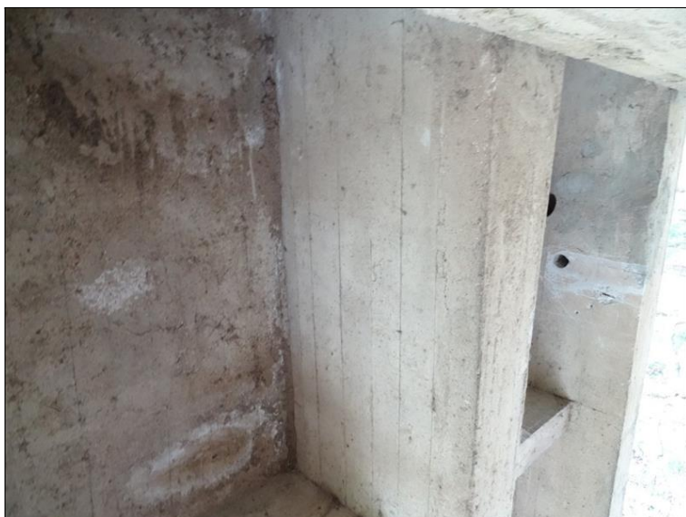
20.JPG Průsaky mostovkou ve 2. poli mezi 2. a 3. trámem před P2.
