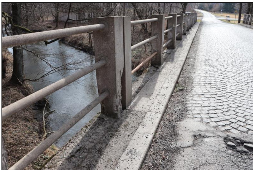
41.JPG Zábradlí na pravé straně mostu v místě nad Op3. Rozpad povrchu římsy mezi sloupky zábradlí (odpadlá omítka, obnažený beton silně degraduje).
