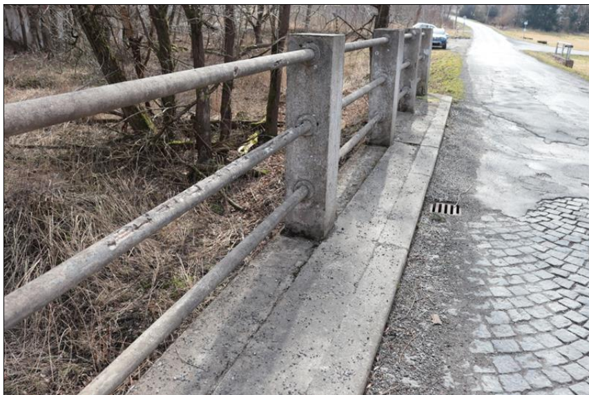
40.JPG Degradace betonu (odpad) na vodorovných madlech zábradlí. V místech odpadlého betonu koroze obnažené výztuže.
