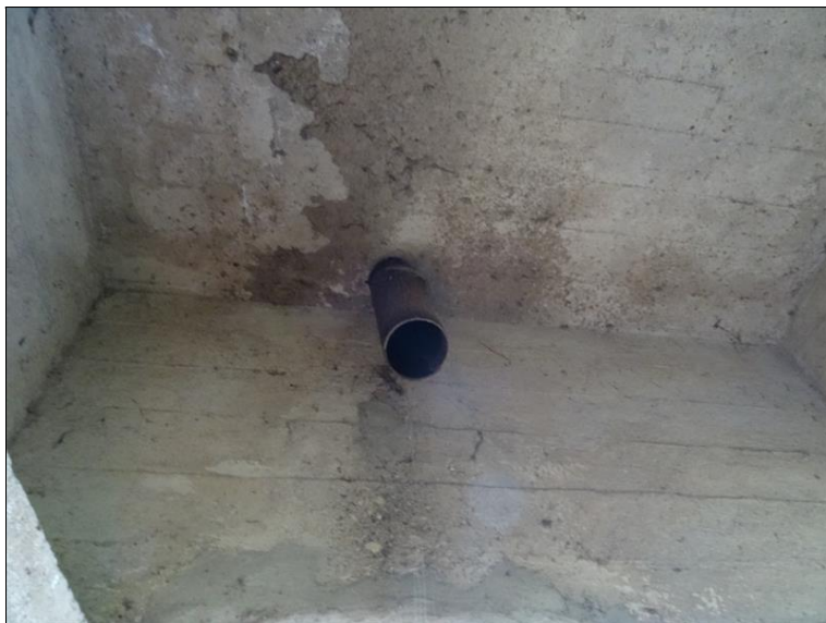
19.JPG Vyústění odvodňovače vozovky při jejím levém kraji ve 2. poli u P2.
