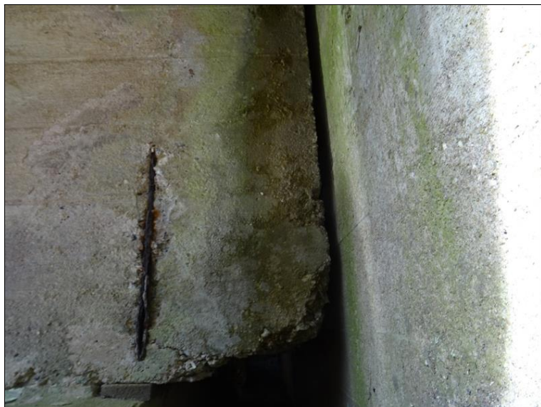
34.JPG Fasáda konce pravého krajního trámu (konc. příčniku) u ZZ Op3. Lokál. obnažený korodující třmínek. Stopy silných zátoků dilatač. spárou mezi NK a Op. Ponechaný bednicí profil horního krčku kyvné stojky.
