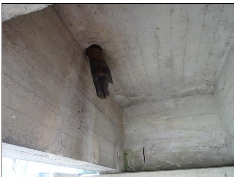
12.JPG Lokál. obnažený třmínek na čele koncového příčnicku nad pravou kyvnou stojkou na Op1, V místě napojení pravého krajního trámu NK do konc. příčnicku patrné mapy průsaků se stopami uchycených mikroorganismů. Odkorodovaná spodní část vyústění odvodňovače vozovky při pravé straně mostu.
