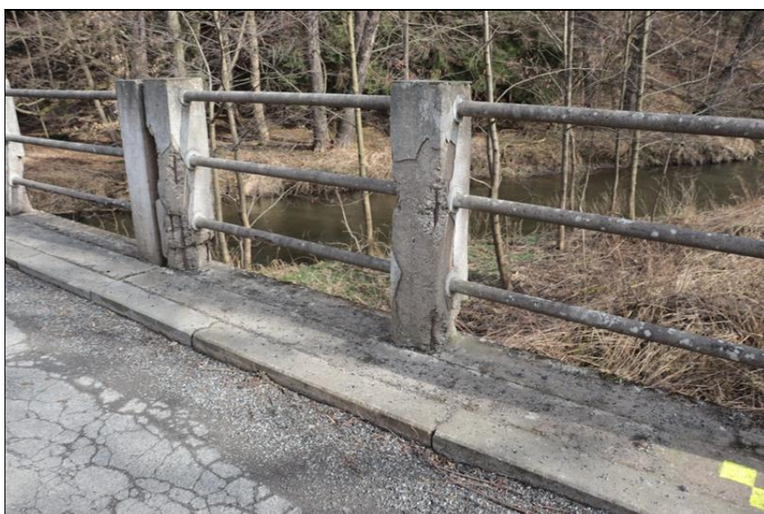
39.JPG Zábradlí mostu na jeho pravé straně v předpolí u Op1. Sloupky zábradlí s odpad. omítkou, odkrytý beton zde silně degraduje, odpadá v krytí vrstvě, obnažená výztuž koroduje.
