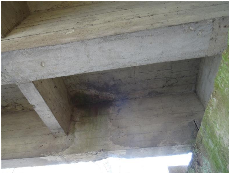
29.JPG Podhled NK v místě 1. a 2. trámu (zleva) před Op3. Silný průsak mostovkou. Před stykem 1. trámu s koncovým příčnickem lokálně obnažený třmínek.
