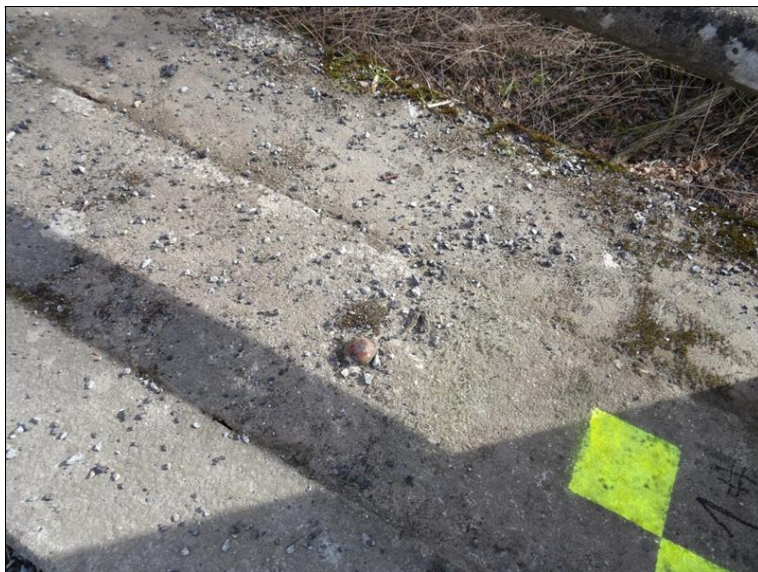
46.JPG Nivelační značka v římse pravého křídla Op1.
