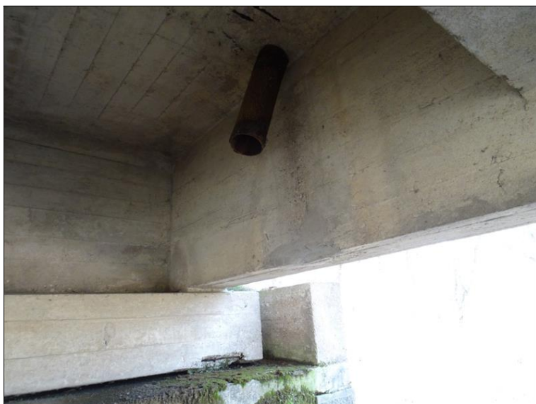
8.JPG Lokální odpad krycí vrstvy výztuže na dolní hraně levé kyvné stojky na Op1.
