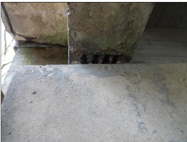
30.JPG Podhled 1. trámu (krajní levý) v místě kyvné stojky na Op3. Lokální odpad krycí vrstvy na podhledu trámu (koroze výztuže). Patrná též lokálně obnažená výztuž mostovkové konzoly u ZZ Op3. V této oblasti stopy zátoků a častého smáčení způsobené netěsnou dilatační spárou.
