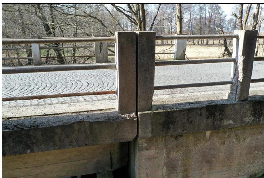
42.JPG Pohled na zábradlí v totožném místě z vnější strany mostu. Odpad omítky a degradace betonu s obnaženou výztuží na sloupcích zábradlí a povrchu římsy.
