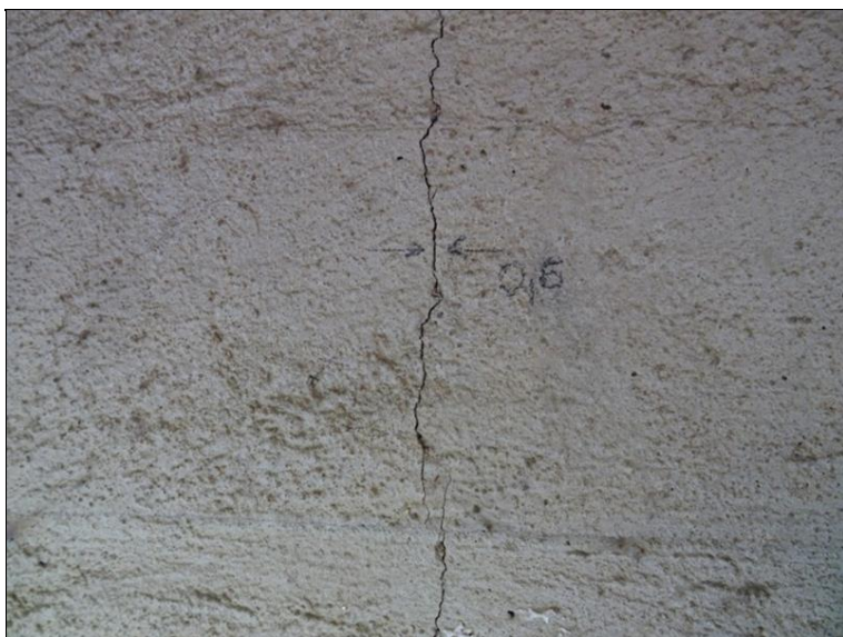
47.JPG Levá strana (povodní) trámu T2-1. Změřená tl. trhliny nad odpadlým sádrovým terčíkem. Pod terčíkem se trhlina zužuje směrem ke spodní hraně trámu do vlasové.
