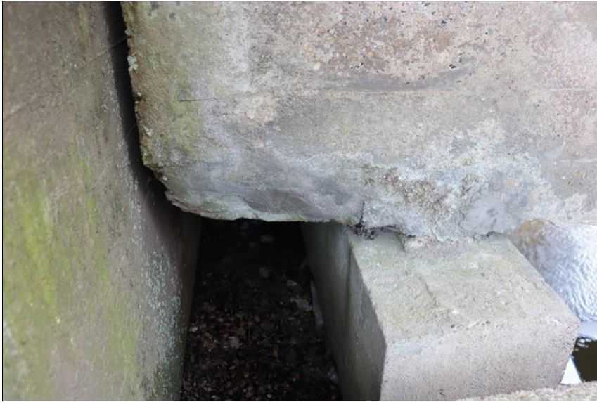
28.JPG Op3 zleva v místě uložení krajního trámu na kyvnou stojku. Sanace spodní části trámu, stopy zátoků dilatační spárou mezi NK a opěrou (mokrá a znečištěný úložný práh, na povrchu betonu mapy a uchycené řasy).
