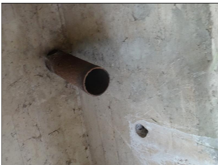
21.JPG Vyústění odvodňovače vozovky při jejím pravém kraji ve 2. poli před P2.
