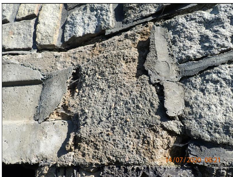
15.Degradace betonu na čele vpravo.JPG
