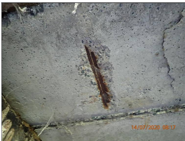
09.Prorýsovaná výztuž nosné konstrukce.JPG
