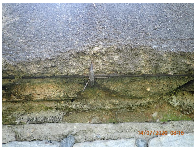
05.Degradace betonu římsy vlevo.JPG
