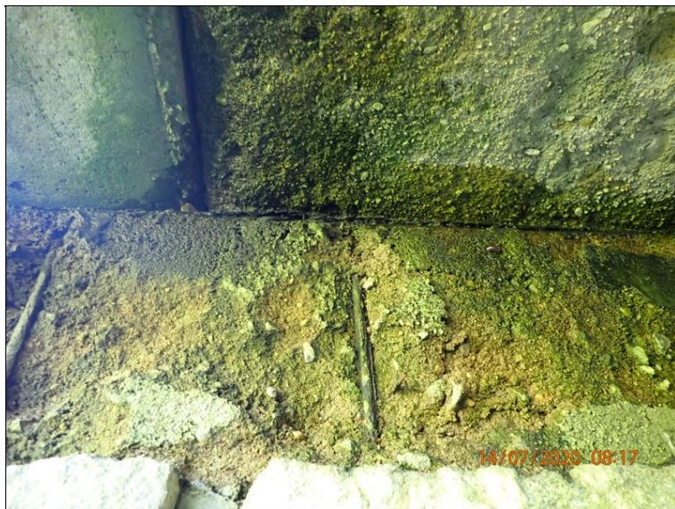
10.Průsak na uložení nosné konstrukce a podpěry.JPG
