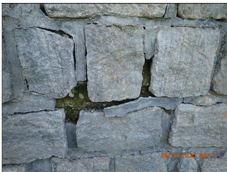
06.Poškozené spárování na čele vlevo.JPG
