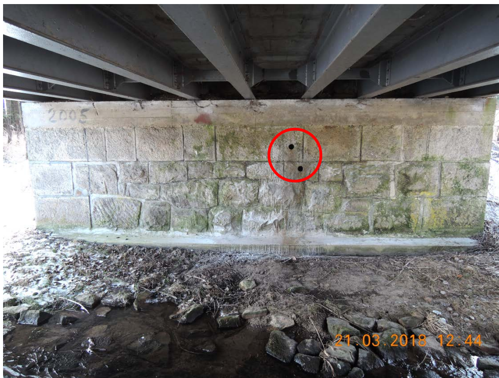
Obrázek č. 1: Umístění vodorovných vrtů na opěře.
