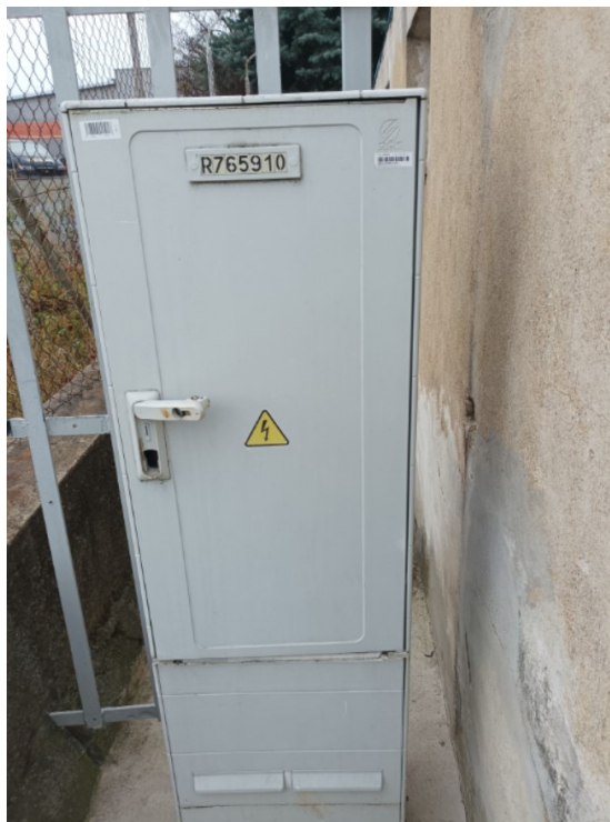
Foto hlavní pojistkové skříně
