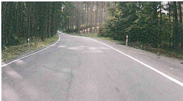
Pohled na úsek (podélné trhliny, pokles okraje)
