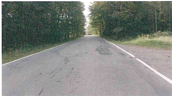
Pohled na úsek (výtluky, podélné trhliny, vysprávkky)
