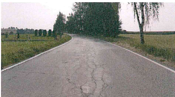
Pohled na úsek (mozaikové trhliny, trhliny na okraji)
