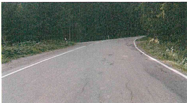
Pohled na úsek (trhliny, výtluky, pokles okraje)
