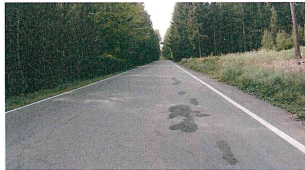
Pohled na úsek (podélné trhliny, vysprávký)
