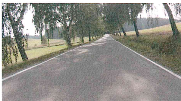
Pohled na úsek (pokles okraje vozovky, trhliny)
