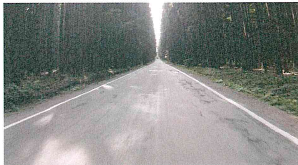
Pohled na úsek (trhliny, výtluky)
