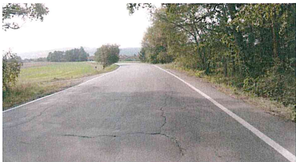
Pohled na úsek (podélné trhliny, příčná trhlina)
