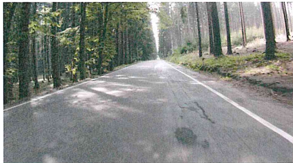
Pohled na úsek (výtluky, mozaikové trhliny, vysprávký)
