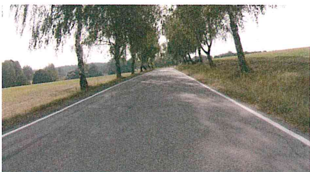
Pohled na úsek (poklesy okrajů vozovky, trhliny)
