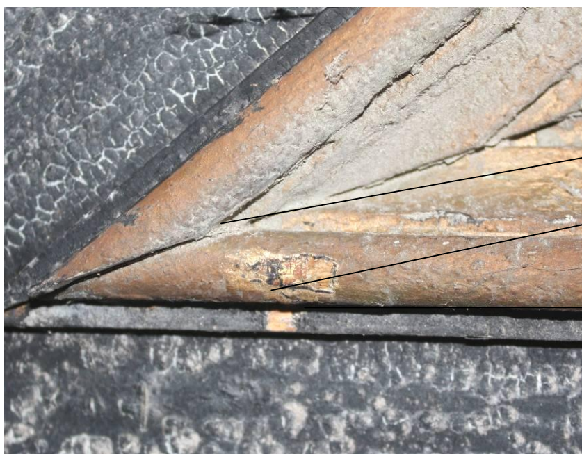
Sondy 16 a 17 provedené na zlacených detailech architektury koše a zábradlí schůdků S16
