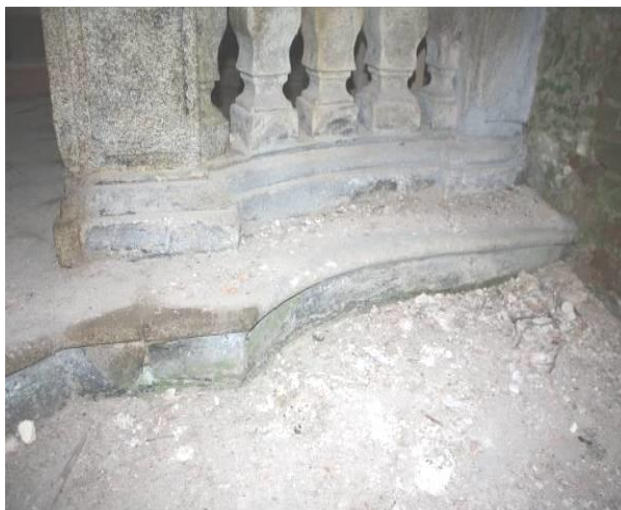
Obr. Kamenný stupeň mezi lodí a kněžištěm
