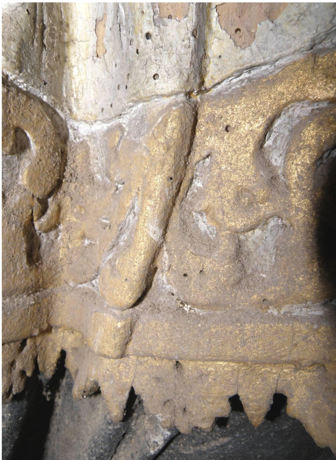
Pod současným souvrstvím hrubých nátěrů byly nalezeny jen fragmenty starších úprav
