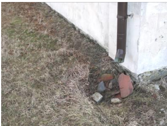
Obr. Současné nevhodné vyústění svodů
