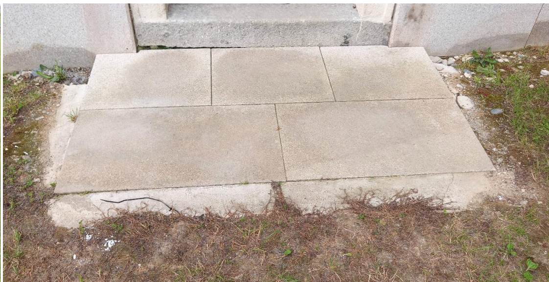
Dosypání a dorovnání terénu u ohradní zídky. Odstranění mazaniny okolo podesty, její zajištění hutněným kamenivem s humusem, s následným zatravněním
