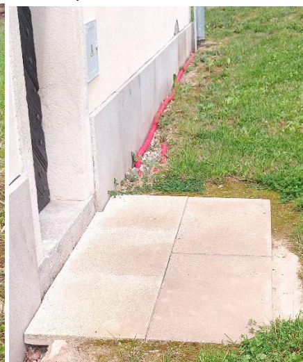
Snížení terénu u větracího okénka krypty 10 cm pod spodní okraj. Terén bude navazovat na stávající úroveň geigeru. Veškeré kabely a jejich chráničky budou uloženy min. 25 cm pod terénem a kryté červenou ochrannou fólií.
