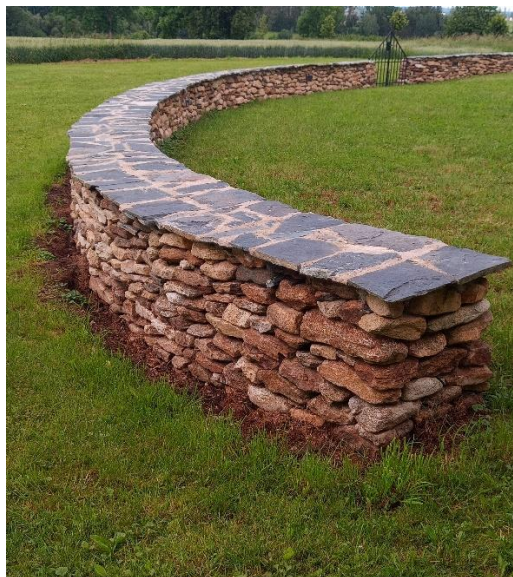
Dosypání a dorovnání terénu u ohradní zídky. Odstranění mazaniny okolo podesty, její zajištění hutněným kamenivem s humusem, s následným zatravněním
