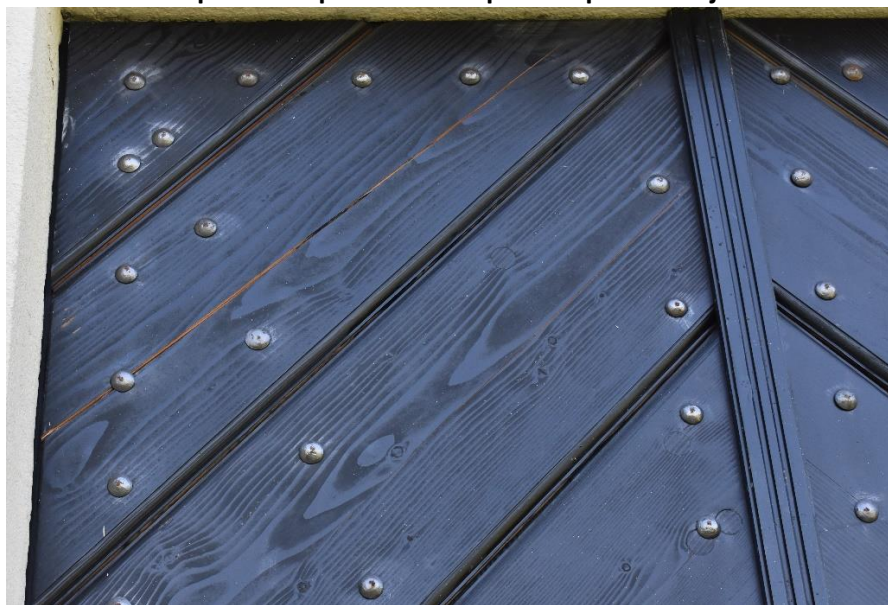
Hlavní vady dveří k odstranění: vystupující smůla, popraskané a seschlé fošny, korodující kovové prvky dveří
