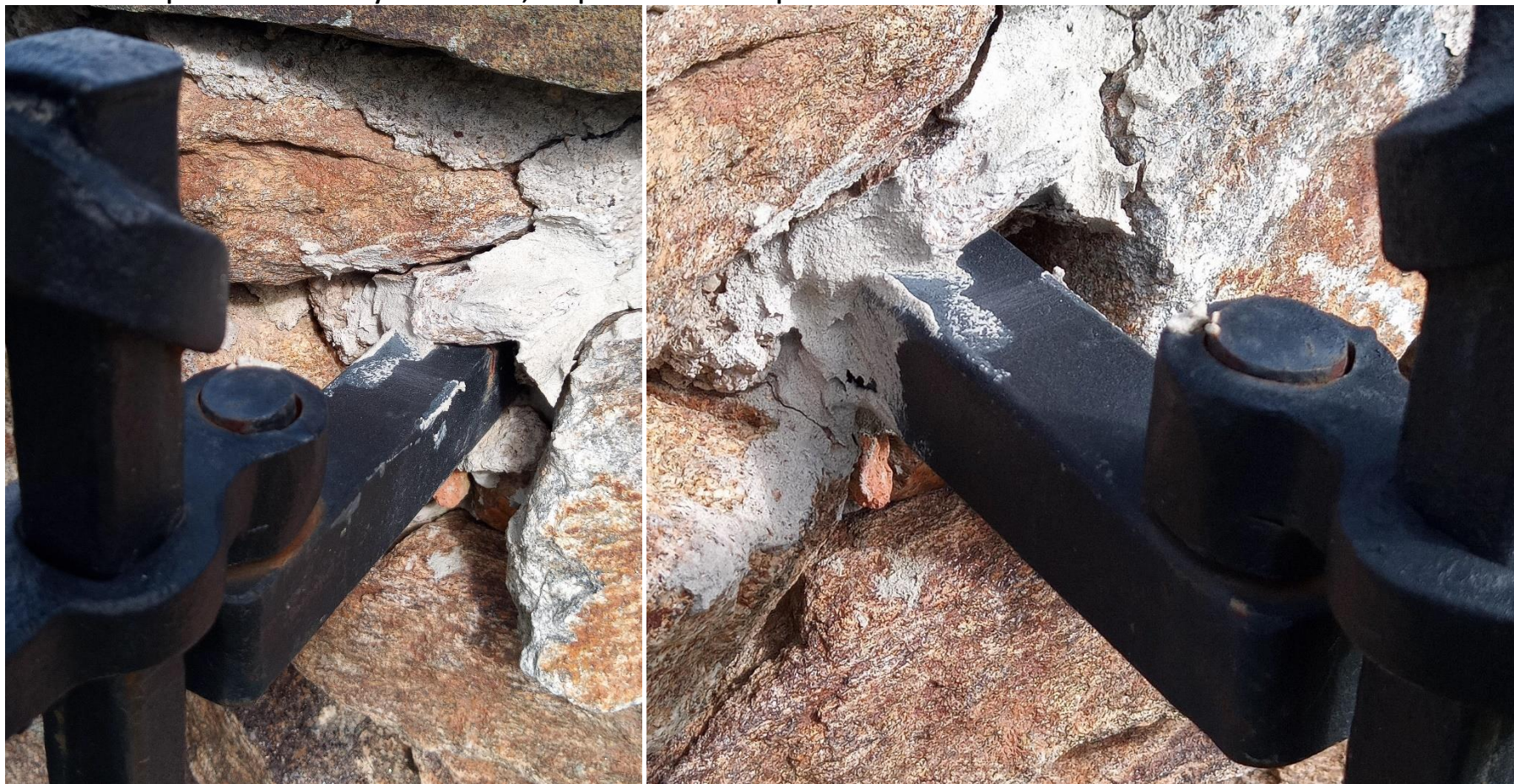
Příloha č.11 – Oprava kotvení branky v ohradní zdi, a doplnění kamenného prahu – fotodokumentace
