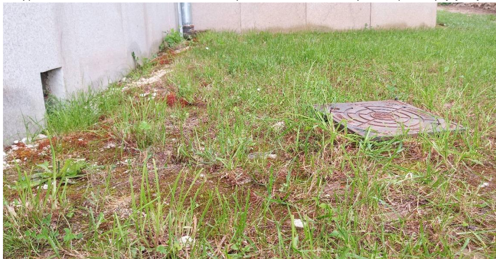
Snížení terénu u větracího okénka krypty 10 cm pod spodní okraj. Terén bude navazovat na stávající úroveň geigeru. Veškeré kabely a jejich chráničky budou uloženy min. 25 cm pod terénem a kryté červenou ochrannou fólií.
