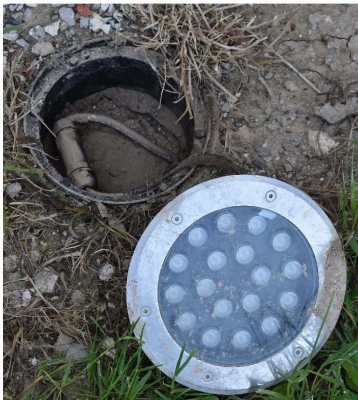
Příloha č.13 – Odstranění nevhodných zemních svítidel a osazení nových vodotěsných v pozicích dle světelné zkoušky – fotodokumentace
