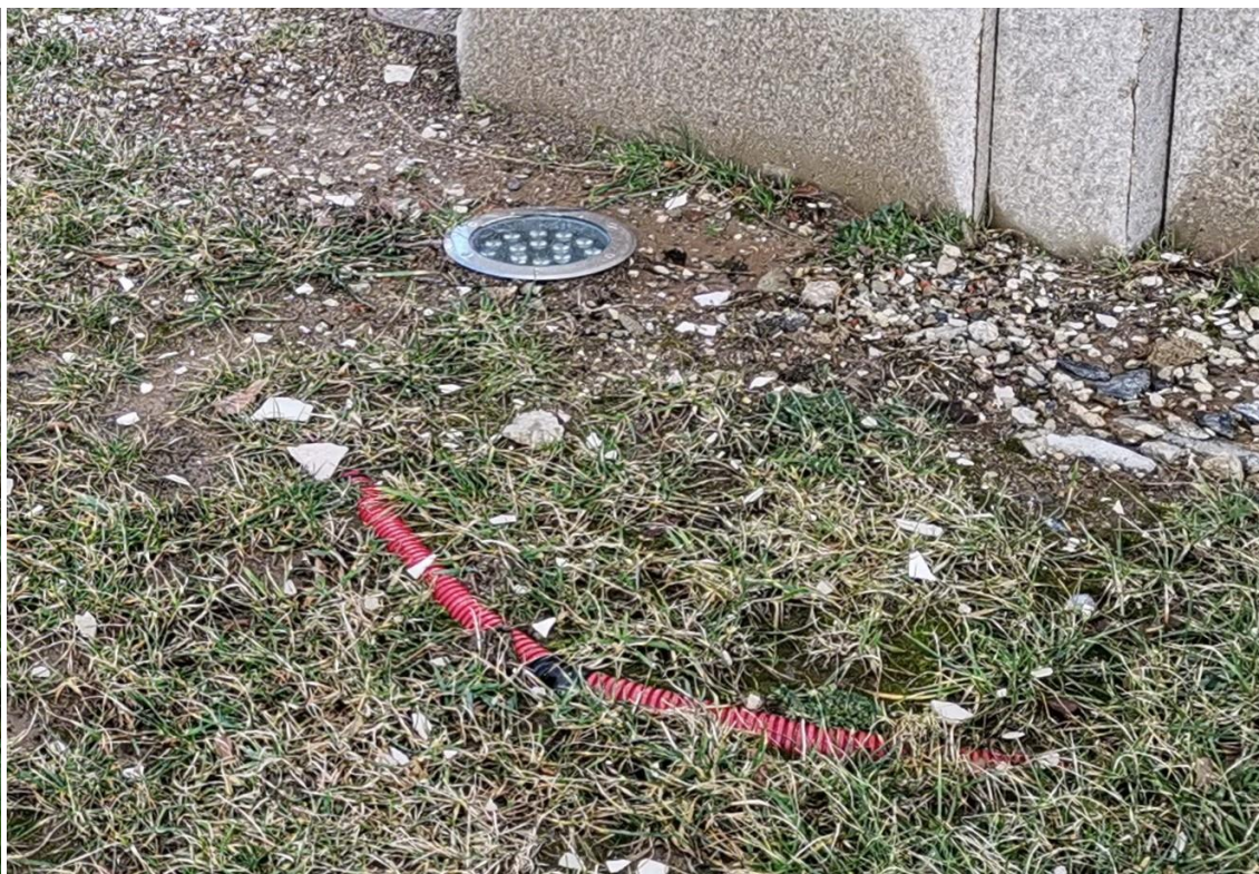
Příloha č.13 – Odstranění nevhodných zemních svítidel a osazení nových vodotěsných v pozicích dle světelné zkoušky – fotodokumentace
