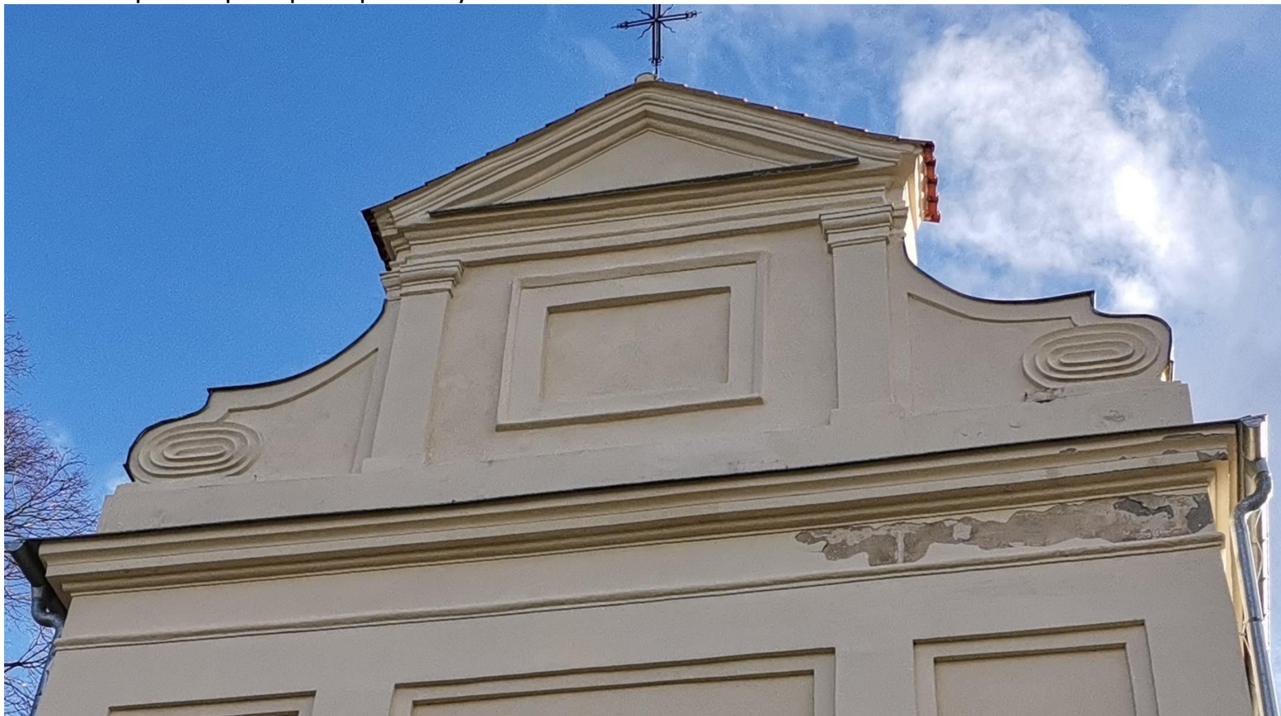
Příloha č.12 – Oprava Kompletní oprava západní fasády – fotodokumentace
