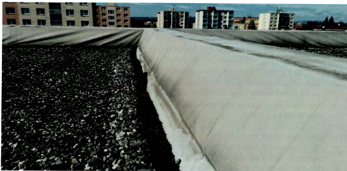
Obr. 2 Pohled smrštěnou fólii a odtržení pomocných poplastovaných lišt u atik
