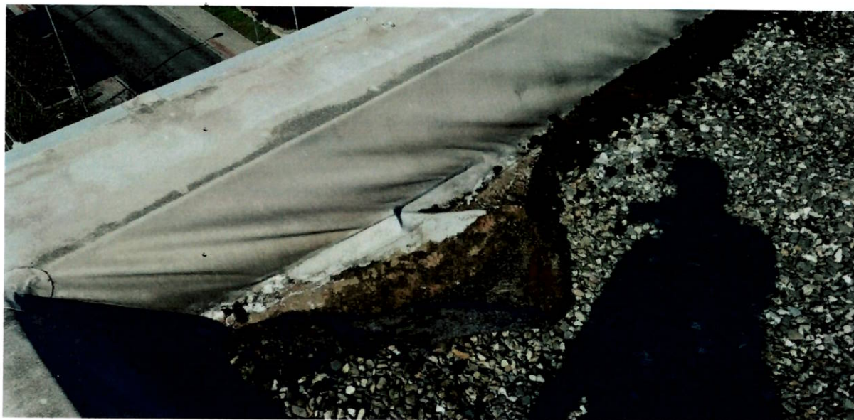
Obr. 1 Pohled smrštěnou fólii a odtržení pomocných poplastovaných lišt u atik
