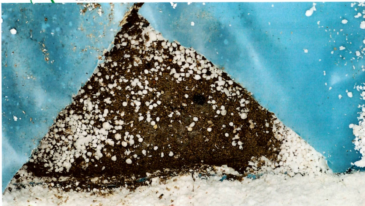
Obr. Pohled na stropní panel, vyrovnávací vrstvu a parotěsnou zábranu
