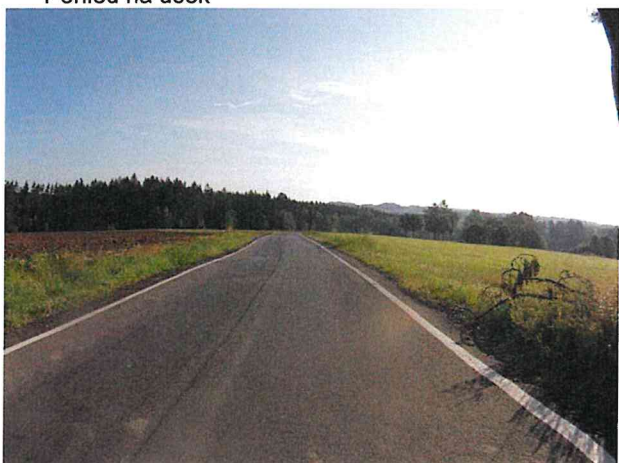
Podélné trhliny, ztráta makrotextury
