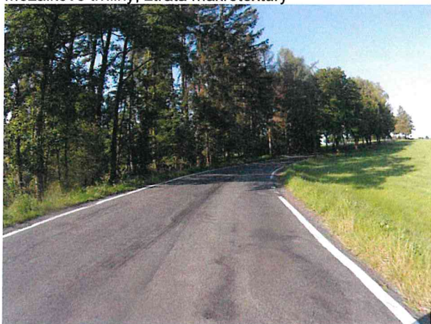
Podélné trhliny, vysprávký
