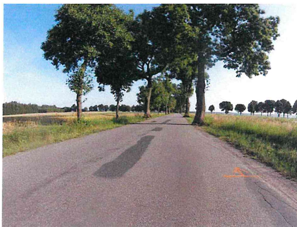
Podélné trhliny, vysprávký
