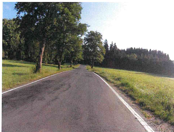
Podélné trhliny, ztráta makrotextury
