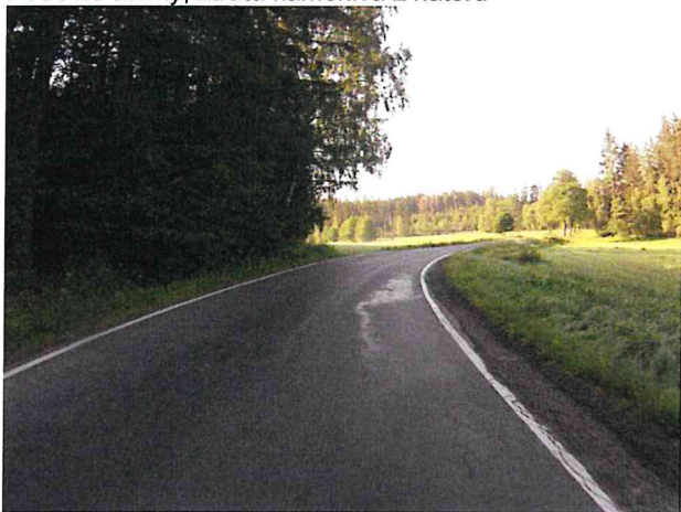
Mozaikové trhliny, ztráta makrotextury
