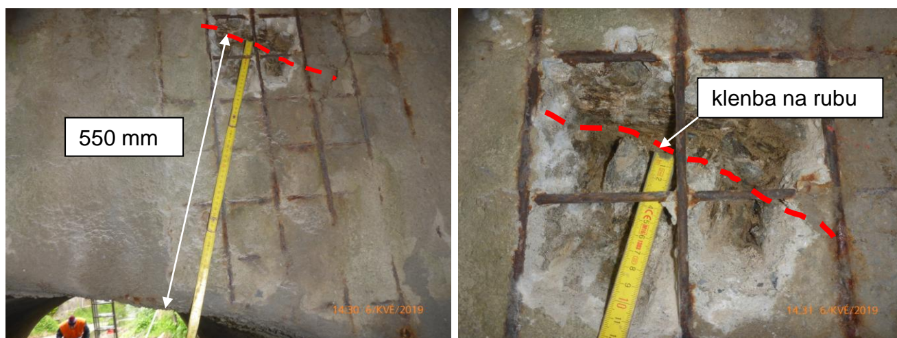
SCHÉMA č.5: Sonda přes torkret ve vrcholu klenby
