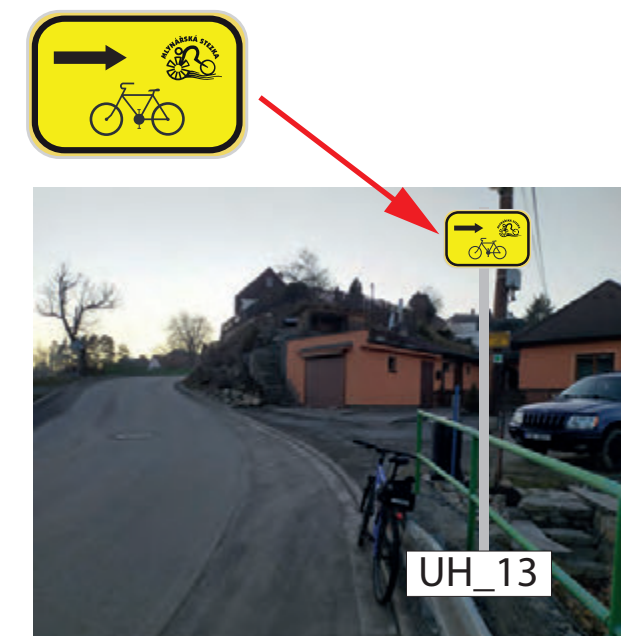
INSTALACE IS21c (MLYNÁŘSKÁ) NA NOVÉM SLOUPKU (UCHYCENÝ K ZÁBRADLÍ OCELOVOU PÁSKOU) POZEMEK: PARC. Č. 3747, K.Ú. UHRŘÍNOV, (OBEC UHRŘÍNOV)
