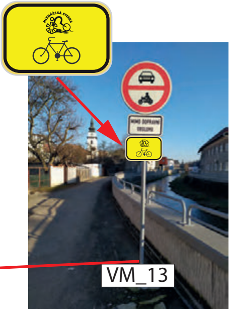
INSTALACE IS21a (MLYNÁŘSKÁ) NA SLOUPKU DZ POD STÁVAJÍCÍ ZNAČENÍ E12
