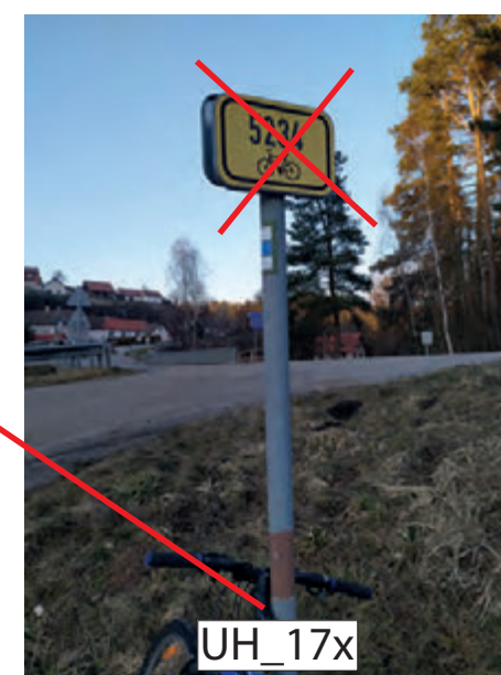
DEMONTÁŽ STÁVAJÍCÍ IS21a (5234) NA UVOLNĚNÉ MÍSTO INSTALACE IS20 (UH_17)
