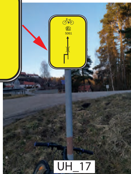
INSTALACE IS20 (MLYNÁŘSKÁ, 5234) NA STÁVAJÍCÍM SLOUPKU CYKLOTRASY MÍSTO DEMONTÁŽE UH_17X INSTALACE POD STÁVAJÍCÍ IS21a (5234) NA RUBU NÁVĚSTÍ IS21a (MLYNÁŘSKÁ) JAKO POTVRZENÍ SMĚRU
