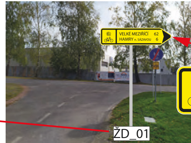
INSTALACE IS19c (MLYNÁŘSKÁ) NA NOVÉM SLOUPKU V KOTEVNÍ PATCE UMÍSTĚNÍ MIN. 10 m PŘED ZNAČKOU DZ C9b KONEC CYKLOSTEZKY POZEMEK: PARC. Č. 650/1 K. Ú. ZÁMEK ŽDÁR, (MĚSTO ŽDÁR NAD SÁZAVOU)
