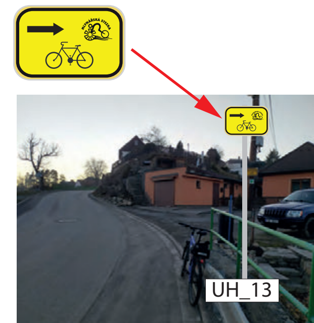
INSTALACE IS21c (MLYNÁŘSKÁ) NA NOVÉM SLOUPKU (UCHYCENÝ K ZÁBRADLÍ OCELOVOU PÁSKOU) POZEMEK: PARC. Č. 3747, K.Ú. UHŘÍNŮV, (OBEC UHŘÍNŮV)
