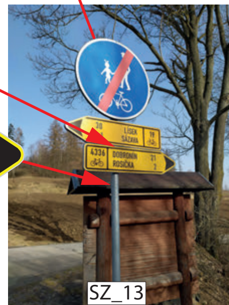
INSTALACE IS19b (MLYNÁŘSKÁ) - UMÍSTĚNÍ MEZI IS19b (19) A IS19c (4336) INSTALACE IS19c (MLYNÁŘSKÁ) - UMÍSTĚNÍ POD IS19C (4336) NA STÁVAJÍCÍM SLOUPKU DZ C9b
