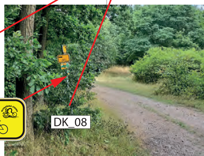
INSTALACE IS21b (MLYNÁŘSKÁ) A IS21c (MLYNÁŘSKÁ) NA STÁVAJÍCÍ SLOUPEK CYKLOTRASY PIVOVARSKÁ UMÍSTĚNÍ POD STÁVAJÍCÍ ZNAČENÍ, OŘEZ VĚTVÍ
