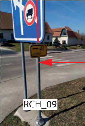
INSTALACE IS21c (MLYNÁŘSKÁ) NA SLOUPEK DZ UMÍSTĚNÍ Z BOKU, POD STÁVAJÍCÍ IS21c (401)
