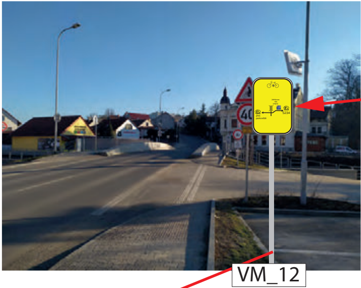
INSTALACE NOVÉ IS20 (MLYNÁŘSKÁ + 5234) NA NOVÉM SLOUPKU V KOTEVNÍ PATCE POZEMEK: PARC. Č. 2851/9 K. Ú. VELKÉ MEZIŘÍČÍ (MĚSTO VELKÉ MEZIŘÍČÍ)
