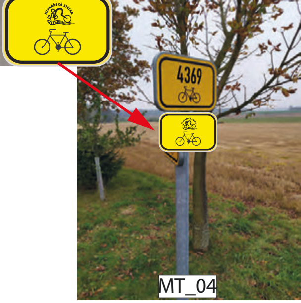
INSTALACE IS21a (MLYNÁŘSKÁ) A IS21b (MLYNÁŘSKÁ) NA STÁVAJÍCÍ SPOLEČNÝ SLOUPEK PRO OBA SMĚRY, POD STÁVAJÍCÍ IS 21 (4369) STEJNÉHO SMĚRU
