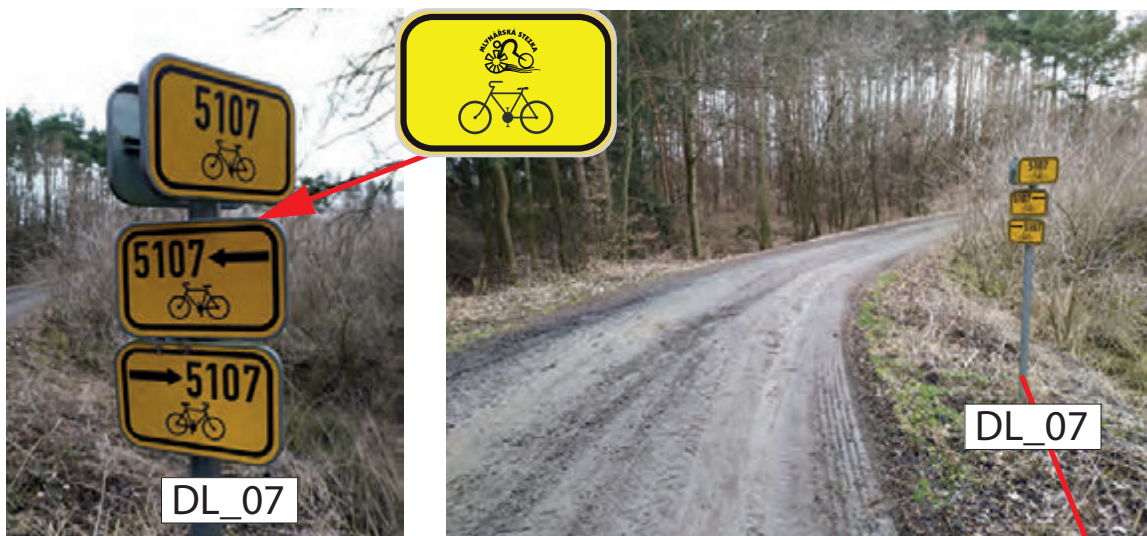
INSTALACE 2x IS21a (MLYNÁŘSKÁ), NA STÁVAJÍCÍ SLOUPEK CYKLOTRAS UMÍSTĚNÍ MEZI STÁVAJÍCÍ ZNAČENÍ, IS21b (5107) A IS21c (5107) POSUNOUT DOLŮ
