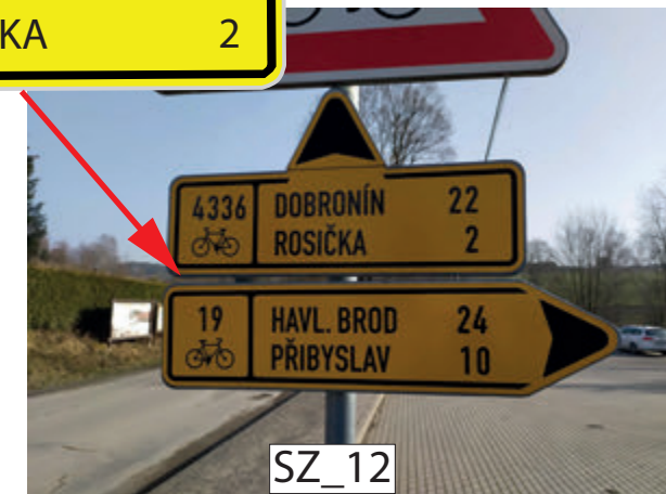
INSTALACE IS19a (MLYNÁŘSKÁ) BEZ HROTU NA STÁVAJÍCÍM SLOUPKU DZ A19 MEZI STÁVAJÍCÍ IS19a (4336) A IS19c (19)
