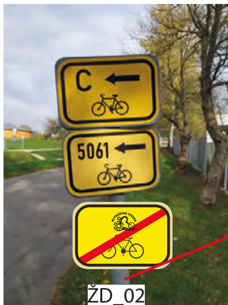
INSTALACE IS21d (KONEC MLYNÁŘSKÉ) NA STÁVAJÍCÍM SLOUPKU DZ IS21 (5061, C)
