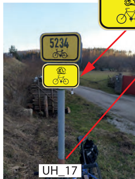
INSTALACE IS20 (MLYNÁŘSKÁ, 5234) NA STÁVAJÍCÍM SLOUPKU CYKLOTRASY MÍSTO DEMONTÁŽE UH_17X INSTALACE POD STÁVAJÍCÍ IS21a (5234) NA RUBU NÁVĚSTÍ IS21a (MLYNÁŘSKÁ) JAKO POTVRZENÍ SMĚRU
