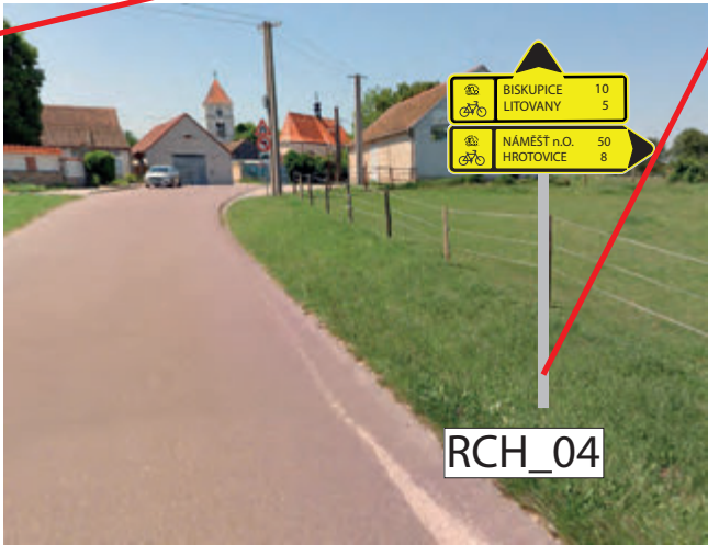
INSTALACE IS21b (MLYNÁŘSKÁ) NA NOVÝ SPOLEČNÝ SLOUPEK PRO OBA SMĚRY V KOTEVNÍ PATCE POZEMEK: PARC. Č. 1116/9, K. Ú. ROUCHOVANY (KRAJ VYSOČINA)
