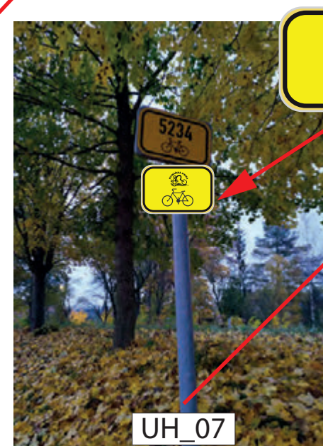
INSTALACE IS21a (MLYNÁŘSKÁ) V JEDNOM SMĚRU NA STÁVAJÍCÍM SLOUPKU CYKLOTRASY (5234), UMÍSTĚNÍ POD STÁVAJÍCÍ ZNAČENÍ IS21a (5234)
