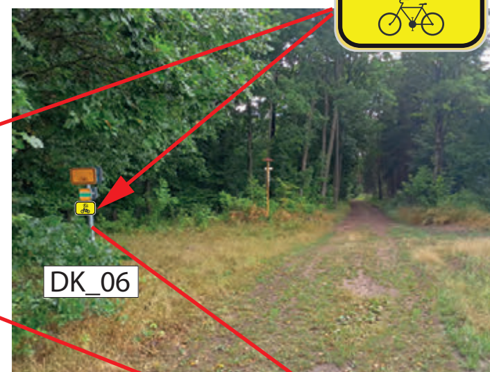
INSTALACE 2x IS21a (MLYNÁŘSKÁ) NA STÁVAJÍCÍ SLOUPEK CYKLOTRASY PIVOVARSKÁ UMÍSTĚNÍ POD STÁVAJÍCÍ ZNAČENÍ OŘEZ VĚTVÍ
