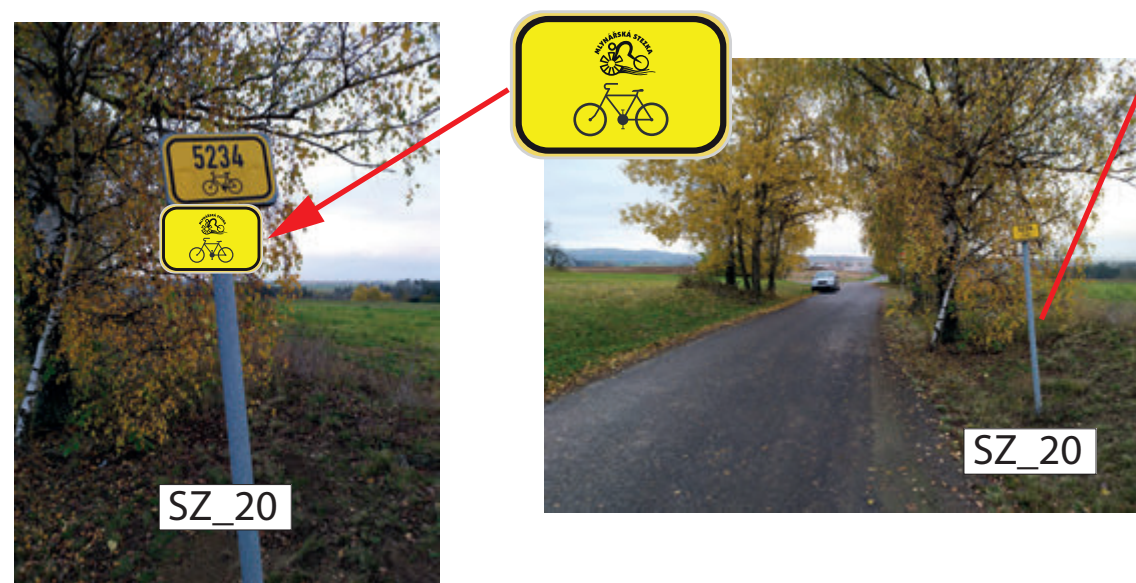
INSTALACE IS21a (MLYNÁŘSKÁ) V JEDNOM SMĚRU NA STÁVAJÍCÍM SLOUPKU CYKLOTRASY č. 5234, POD STÁVAJÍCÍ ZNAČENÍ IS21a (5234)
