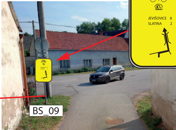
INSTALACE IS21a (MLYNÁŘSKÁ) POD STÁVAJÍCÍ DOPRAVNÍ ZNAČKY INSTALACE IS20a (MLYNÁŘSKÁ) NA SLOUPEK DOPRAVNÍHO ZNAČENÍ, NA RUBU POD DZ
