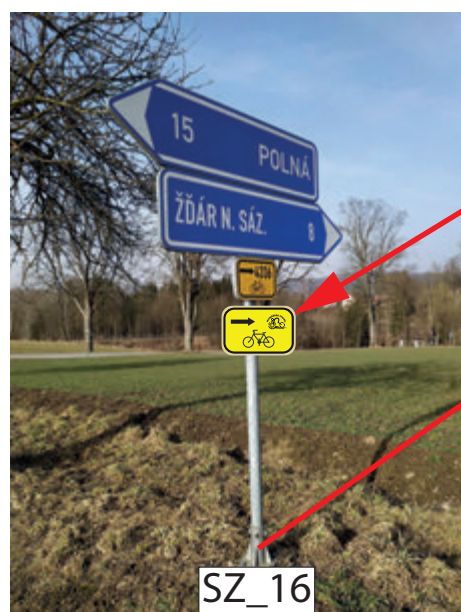
INSTALACE IS21b (MLYNÁŘSKÁ) NA STÁVAJÍCÍ SLOUPEK DZ IS 3 POD STÁVAJÍCÍ IS21b (4336)
