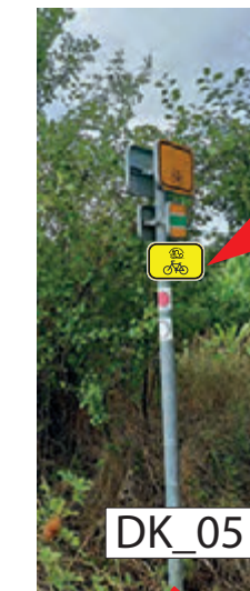
INSTALACE 2x IS21a (MLYNÁŘSKÁ) NA STÁVAJÍCÍ SLOUPEK CYKLOTRASY PIVOVARSKÁ UMÍSTĚNÍ POD STÁVAJÍCÍ ZNAČENÍ OŘEZ VĚTVÍ
