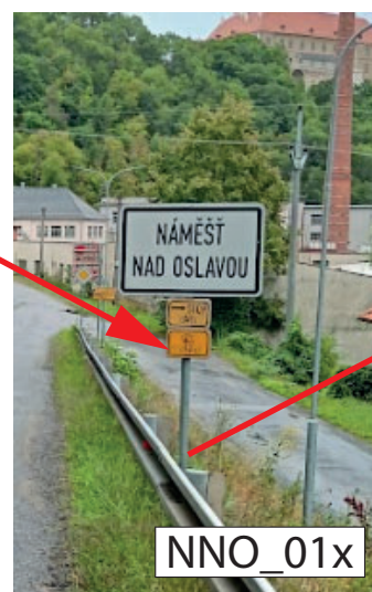
DEMONTÁŽ IS21a (MLYNÁŘSKÁ) NA SLOUPKU DZ
