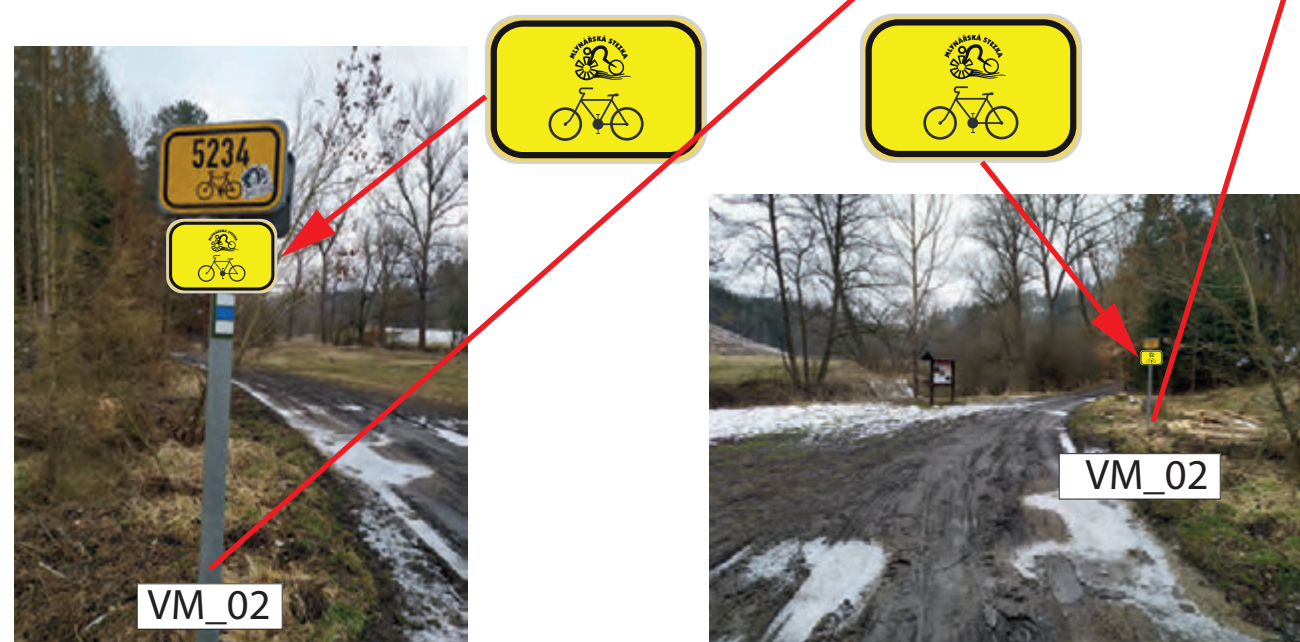
INSTALACE 2x IS21a (MLYNÁŘSKÁ) NA STÁVAJÍCÍM SPOLEČNÉM SLOUPKU CYKLOTRASY 5234 PRO OBA SMĚRY POD STÁVAJÍCÍ ZNAČENÍ
