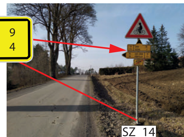
INSTALACE IS19a (MLYNÁŘSKÁ) BEZ HROTU NA STÁVAJÍCÍM SLOUPKU DZ A19 MEZI IS19a (19) A IS19b (19)
