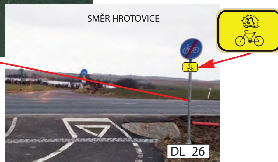
INSTALACE IS21a (MLYNÁŘSKÁ) NA STÁVAJÍCÍ SLOUPEK DZ C8b POD STÁVAJÍCÍ ZNAČENÍ
