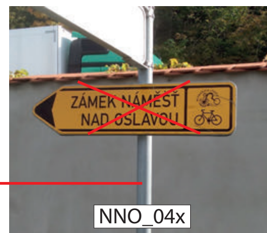
DEMONTÁŽ IS19b (MLYNÁŘSKÁ) NA SLOUPU INFORMAČNÍHO SYSTÉMU
