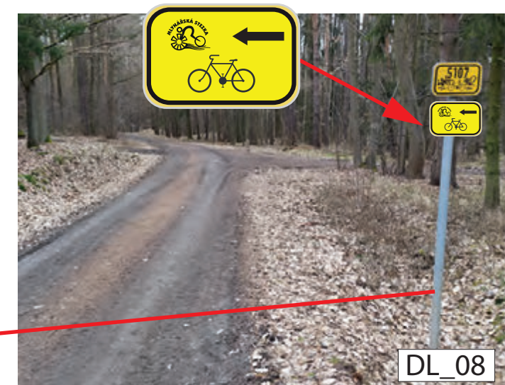
INSTALACE IS21b (MLYNÁŘSKÁ) NA STÁVAJÍCÍ SLOUPEK CYKLOTRAS UMÍSTĚNÍ POD STÁVAJÍCÍ ZNAČENÍ
