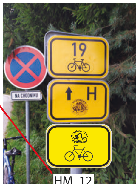
INSTALACE IS21a (MLYNÁŘSKÁ) NA STÁVAJÍCÍ SLOUPEK DZ IS 21 JAKO POTRZENÍ PŘÍMÉHO SMĚRU, UMÍSTĚNÍ POD STÁVAJÍCÍ ZNAČENÍ
