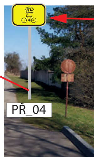
INSTALACE IS21a (MLYNÁŘSKÁ) NA NOVÝ SLOUPEK, V KOTEVNÍ PATCE POZEMEK: PARC. Č. 210/1, K. Ú. PŘEŠOVICE (OBEC PŘEŠOVICE)
