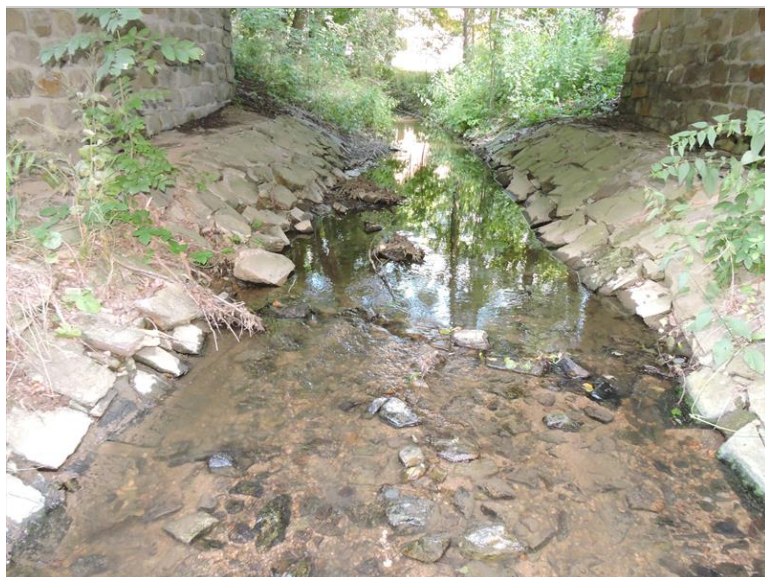
DSCN5430-resize.JPG Detail - území pod mostem
