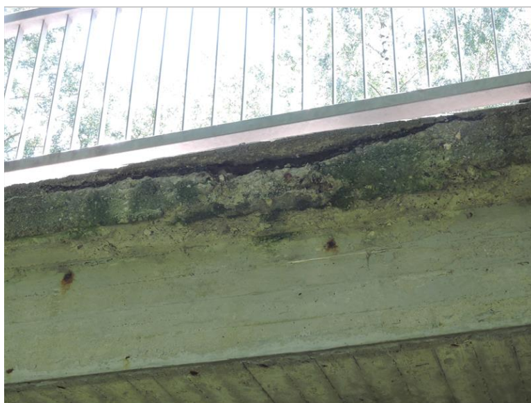
DSCN5441-resize.JPG Detail - L římsa
