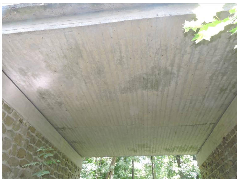
DSCN5428-resize.JPG Podhled na NK
