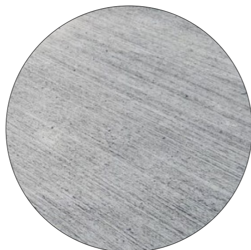
BETONOVÝ POVRCH RAMPY S DRÁSANOU STRUKTUROU
