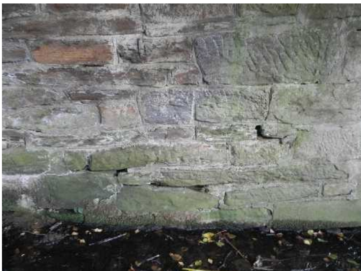
OP1, detail – vypadaná spárová hmota
