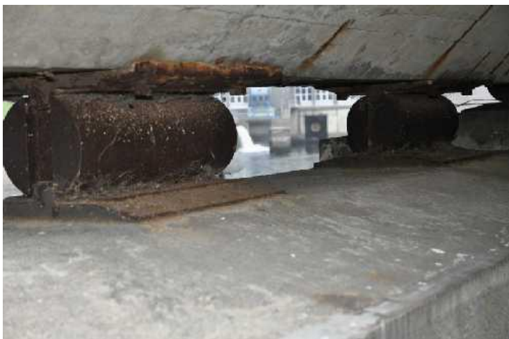
Detailně ložiska na pilíři 2.
