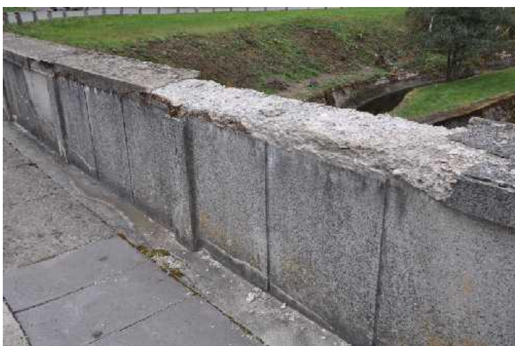
Kusy zábradlí vlevo padají dolů do Svratky.
