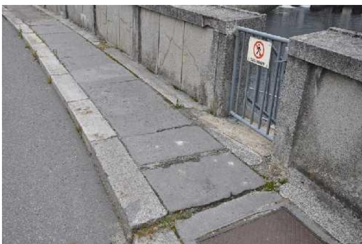
Chodník s kamennými obrubníky a s litým asfaltem. Vpředu kontrolní šachta vedení v chráničkách.
