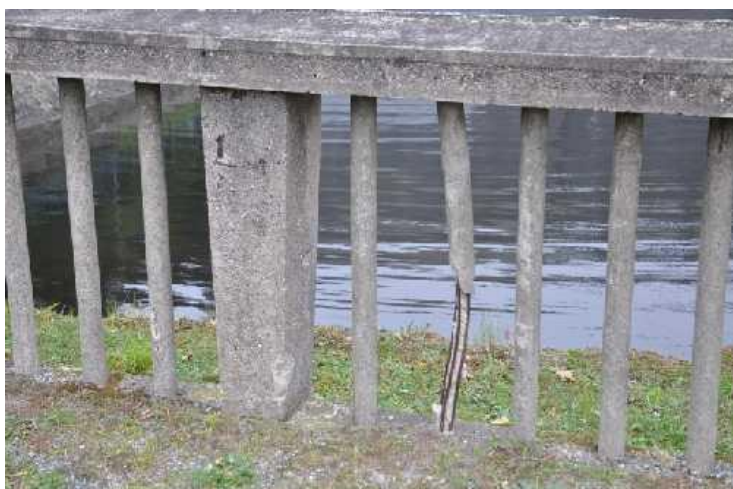
Poškozená výplň zábradlí vpravo.
