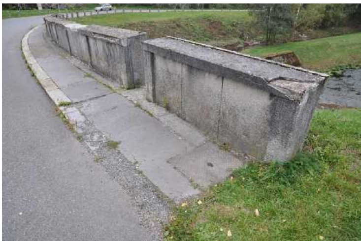
Zábradlí vlevo s kontrilní šachtou pro vedení v chráničkách.
