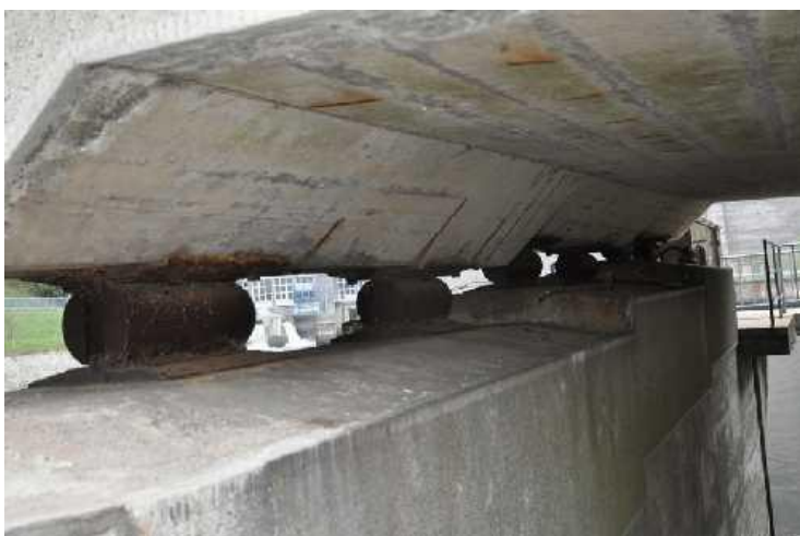
Pilíř 2 s válečkovými ložisky.
