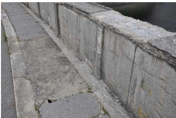
Dutina v chodníku. Ze zábradlí padají kusy cementové omítky.
