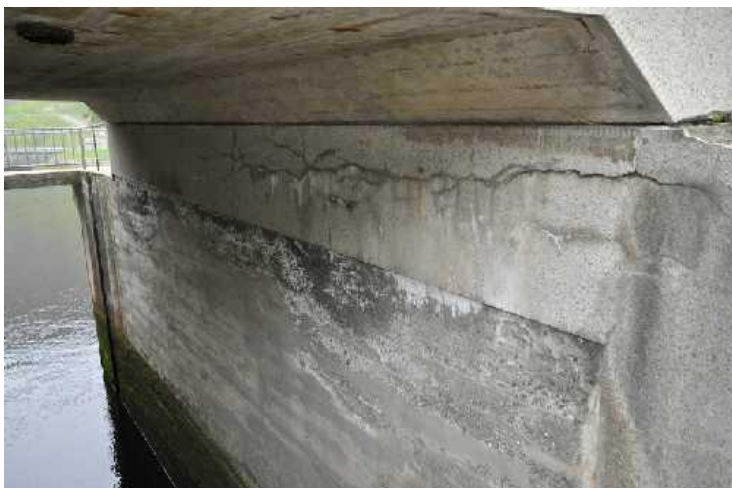
Opěra 1 s uložením nosné konstrukce prostřednictvím vrubového kloubu.
