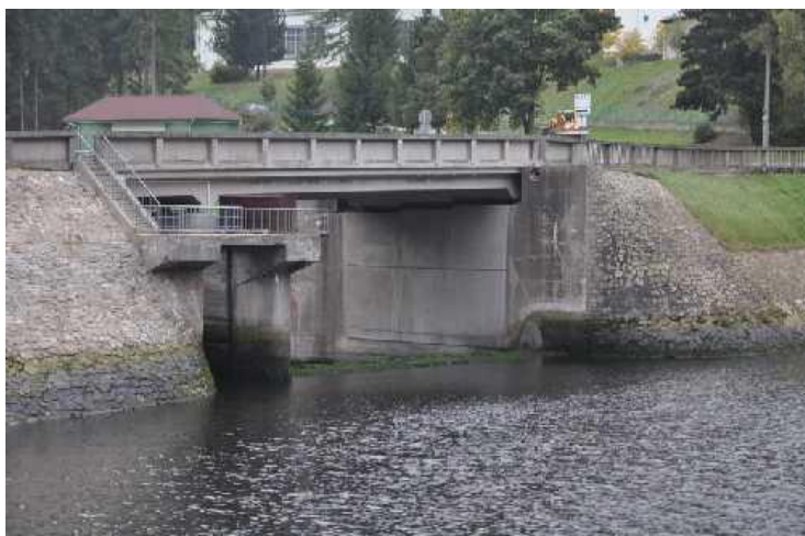
Návodní strana mostu vpravo - první otvor je pro náhon do továrny ve Víru a druhý otvor je pro řeku.
