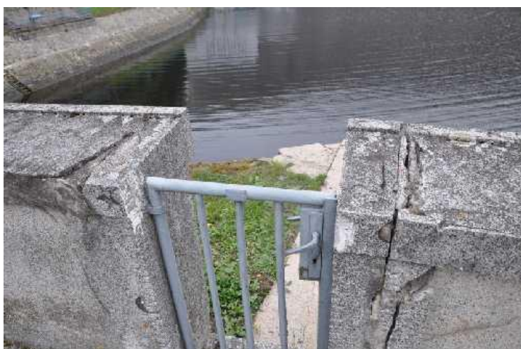
Beton u branky vpravo se úplně rozpadá.
