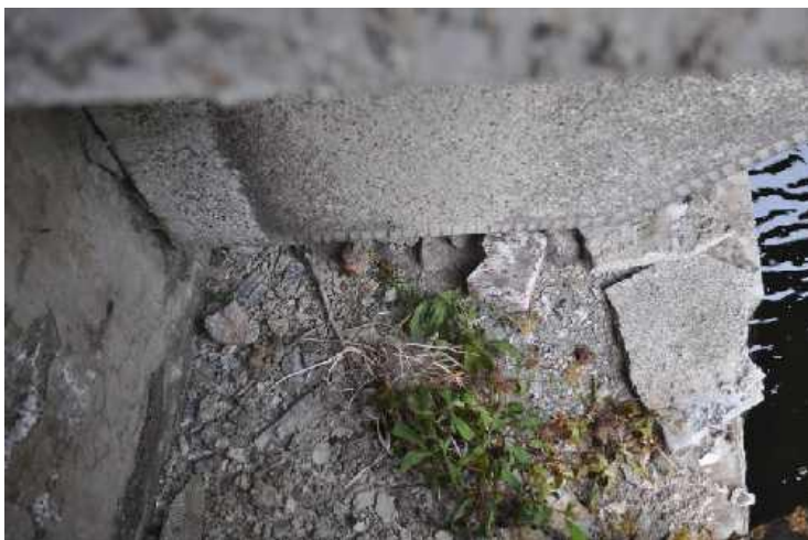
Úložný práh na opěře 3 je plný odpadlých kusů betonu.
