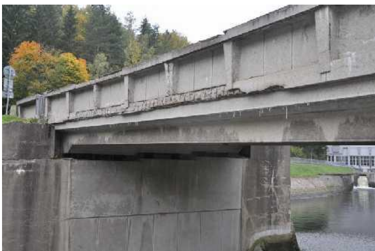
Uložení nosné konstrukce na válečkových ložiskách na opěře 3.
