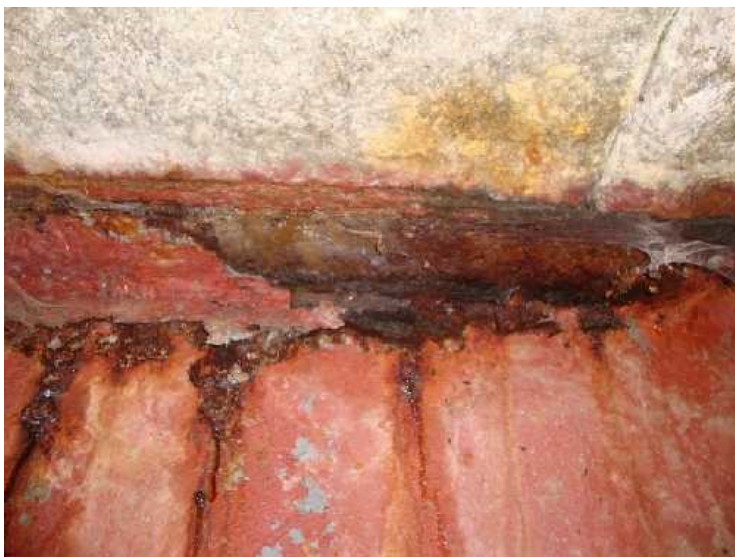
Obr. 18: Koroze nosné konstrukce, stopy po zatékání.
