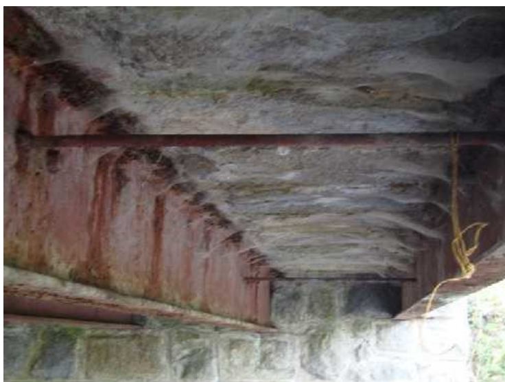
Obr. 15: Detail koroze nosné konstrukce.
