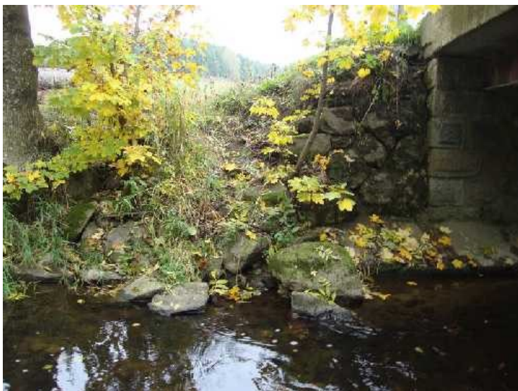
Obr. 7: Degradované povodní křídlo pravobřežní opěry.
