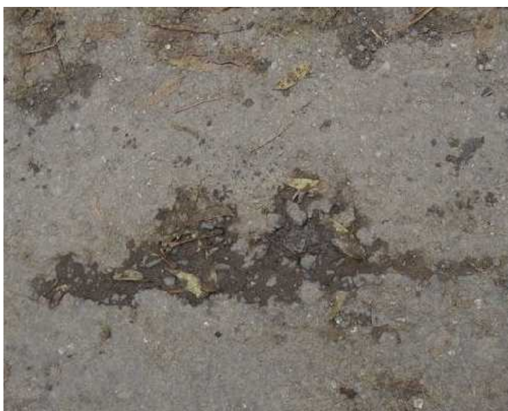
Obr. 5: Výtluk ve vozovce.
