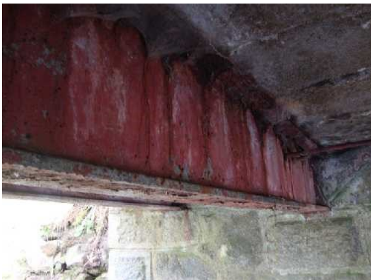
Obr. 17: Koroze nosné konstrukce, stopy po zatékání.
