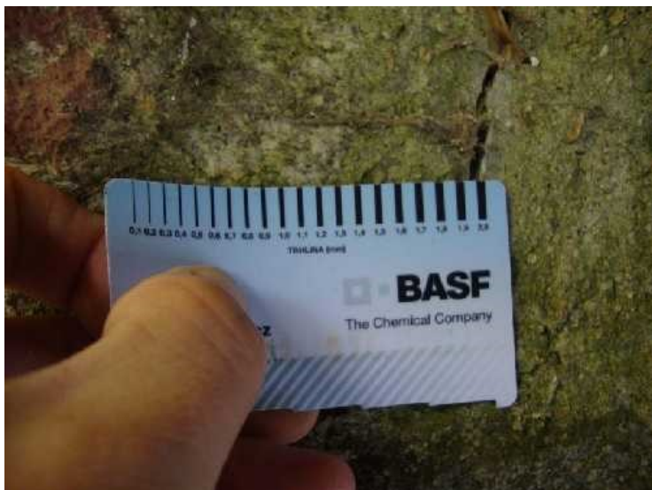
Obr. 13: Detail trhliny šířky 2 mm v levobřežní opěře.
