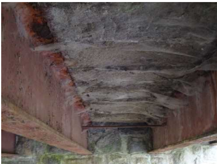
Obr. 16: Koroze nosné konstrukce, stopy po zatékání.
