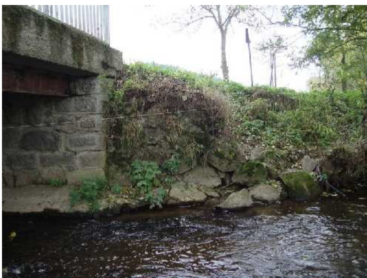
Obr. 8: Degradované povodní křídlo levobřežní opěry.
