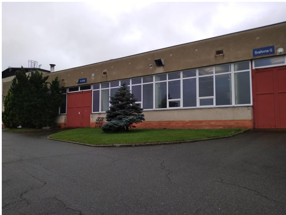
Obrázek 2: Pohled na budovu označenou „A“
