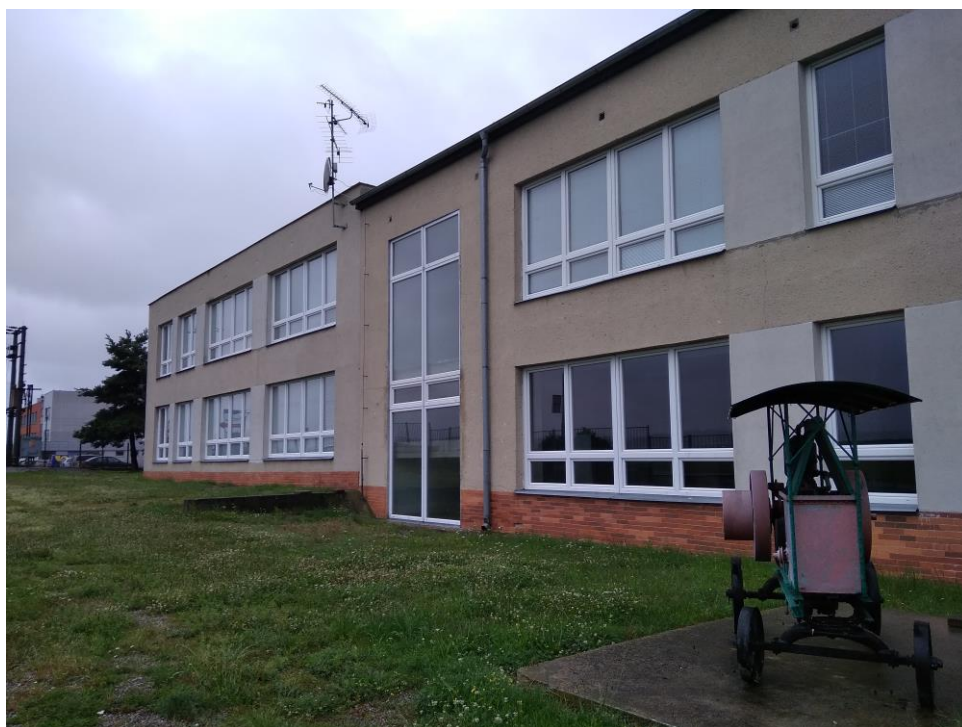
Obrázek 3: Pohled na budovu označenou „B“
