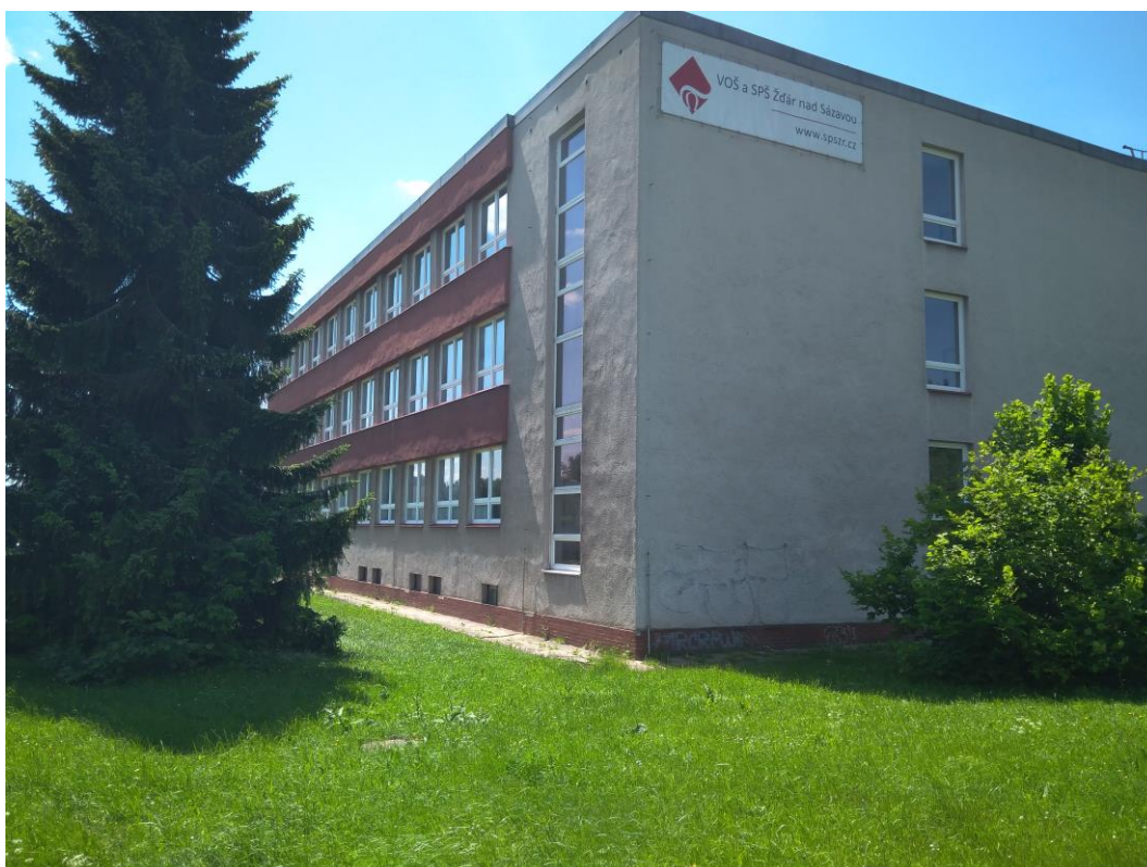
Obrázek 2: Pohled na budovu
