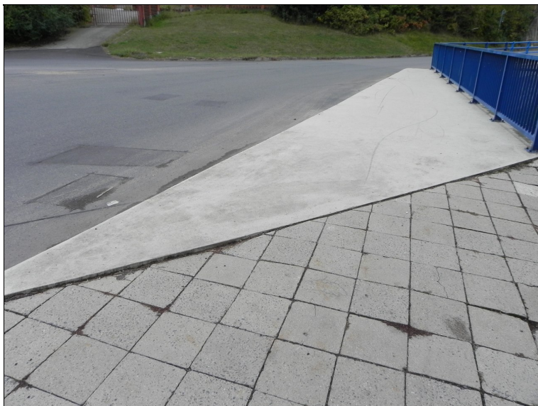
Nápojení chodníku – výškový rozdíl. Levá strana za OP2.
