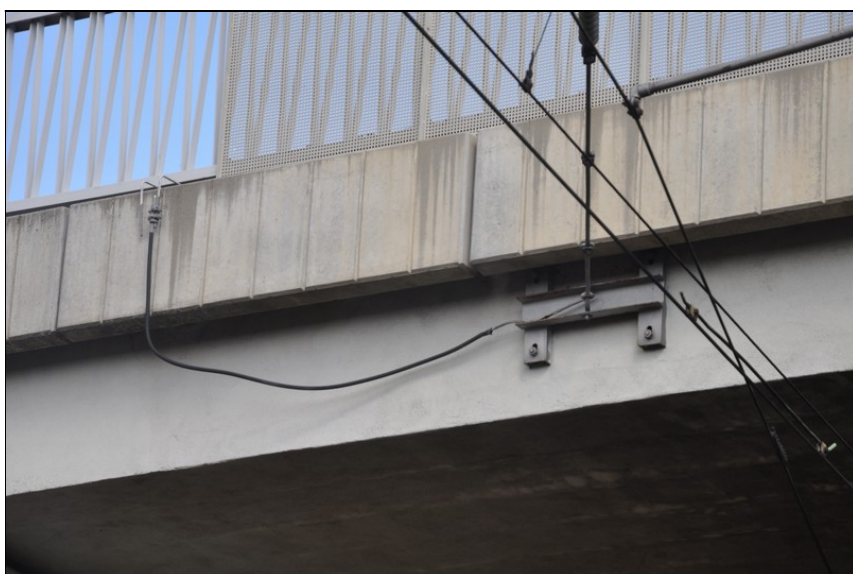
Uzemnění zábradlí a uchycení trakčního vedení.
