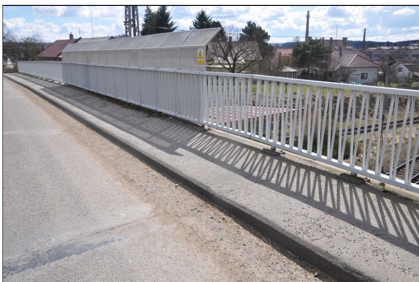
Chodník, zábradlí a protidotyková zábrana vpravo.
