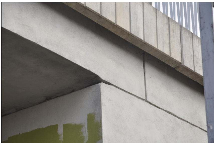
Uložení nosné konstrukce na podpěře 2 vpravo - u hlavní trati.
