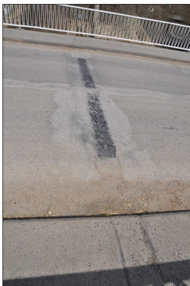
Závěr ve vozovce nad podpěrou 2.
