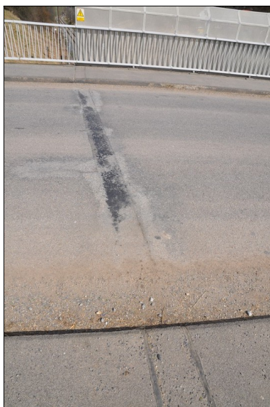
Závěr ve vozovce nad opěrou 1.
