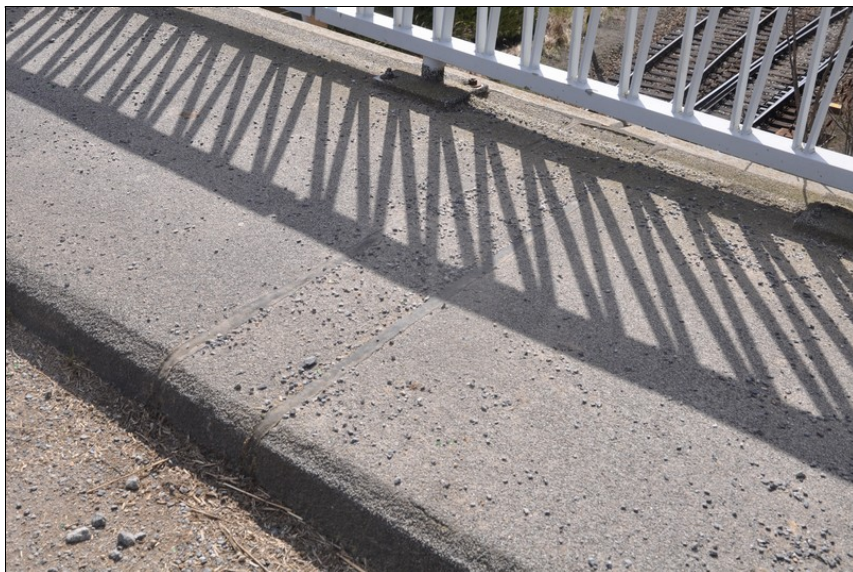
Závěr ve vozovce nad opěrou 1.
