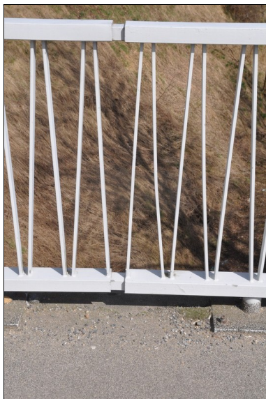
Dilatace zábradlí.
