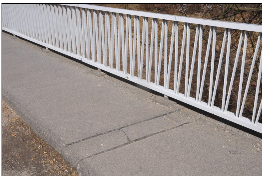
Závěr v chodníku nad opěrou 3 vlevo.
