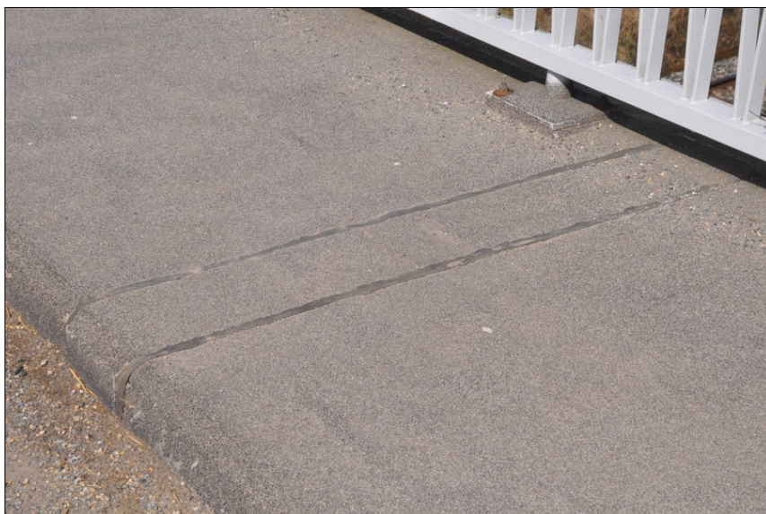
Závěr v chodníku nad podpěrou 2 vlevo.
