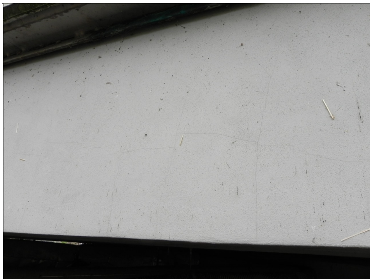
Detail NK – trhliny v omítce
