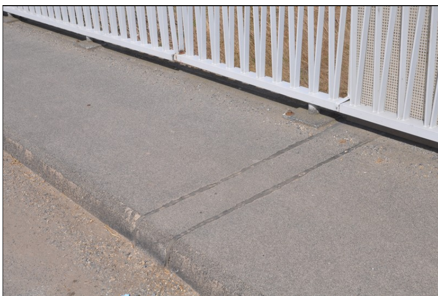
Závěr v chodníku nad opěrou 1 vlevo.
