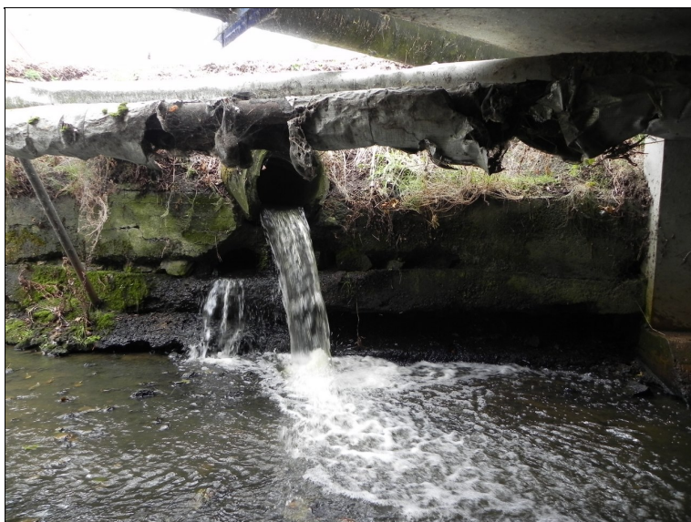
Nábřežní zeď u OP1, PS – celková degradace betonu, kaverny, vytékající voda pod kanalizací a z kanalizace.
