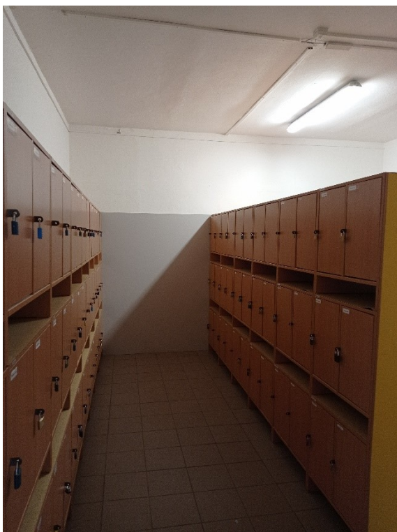
Obr. č. 21 Šatna pro ubytované (dvoupodlažní budova)
