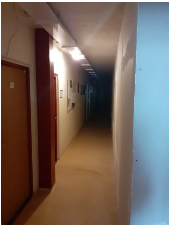
Obr. č. 11 Podélná chodba – vstupy do ubytovacích buněk (na levé straně dočasná příčka postavená pro realizaci východní části devítipodlažní budovy domova mládeže)
