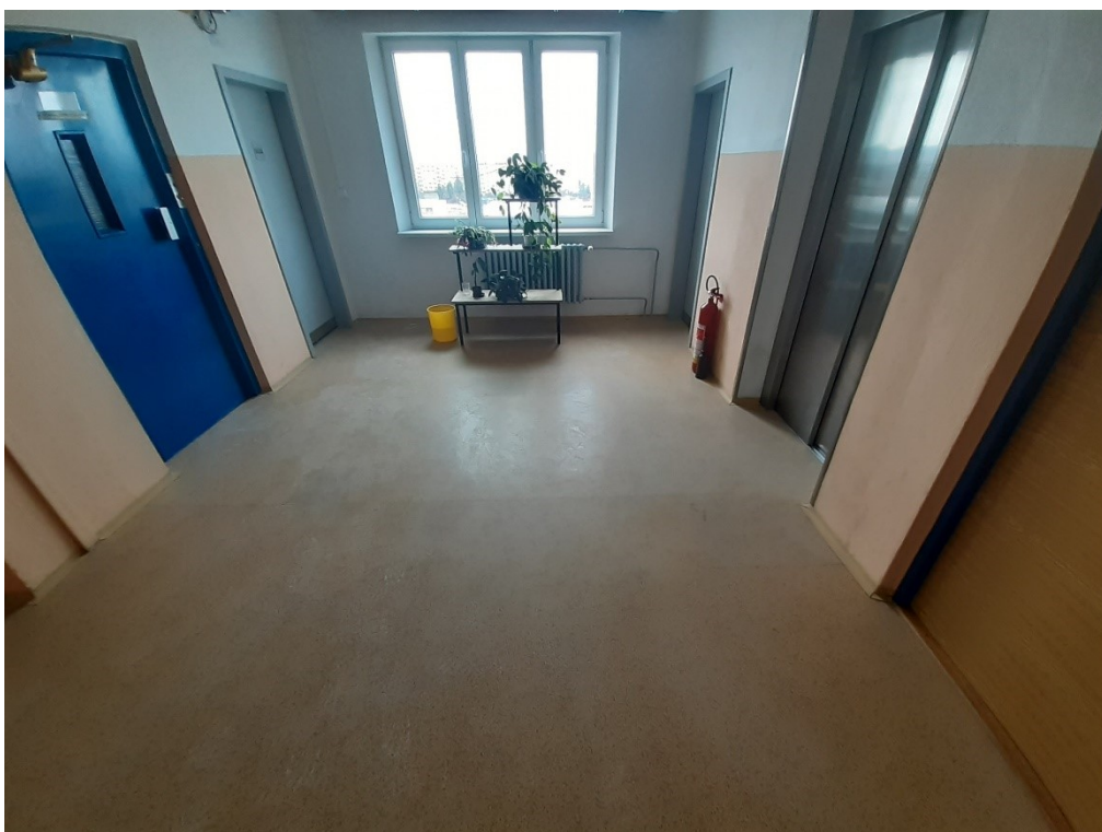
Obr. č. 13 Prostor schodiště (devítipodlažní budova) – modré dveře jsou dveře výtahu, který je předmětem projekčních prací.
