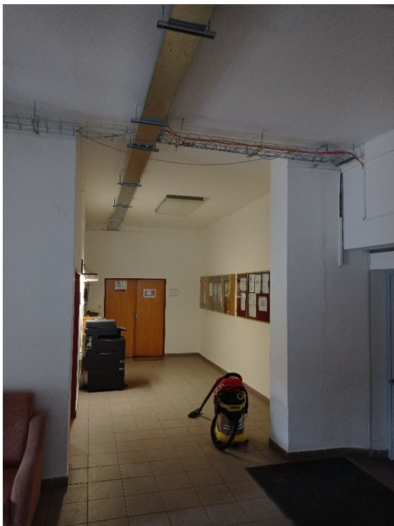
Obr. č. 20 Komunikační prostory (dvoupodlažní budova)
