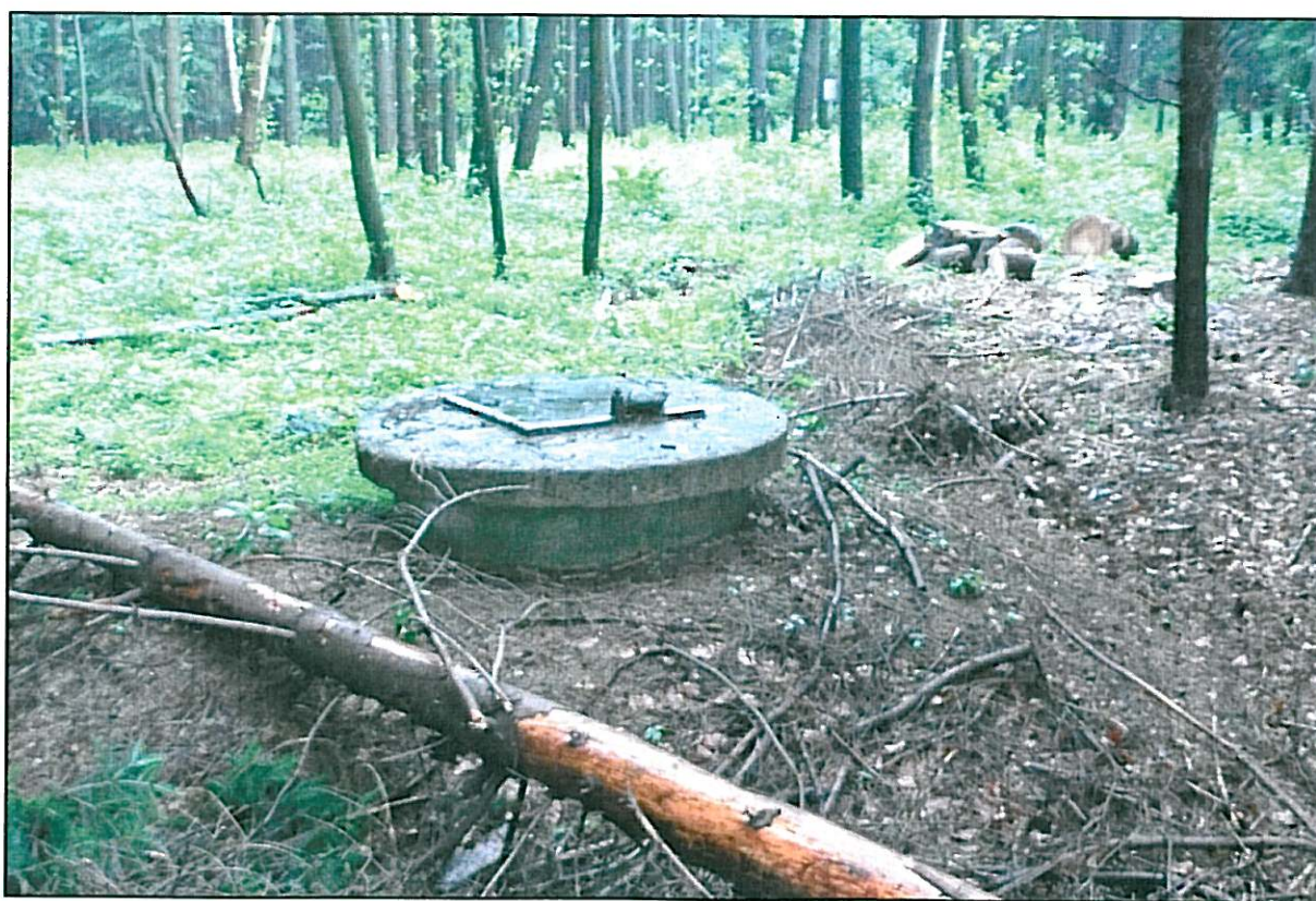
Foto č.16: Detailní pohled na kopanou studnu S1 , pitné vody o hloubce 3,18m. Studna je vzdálena jen 20m od silnice II/353
