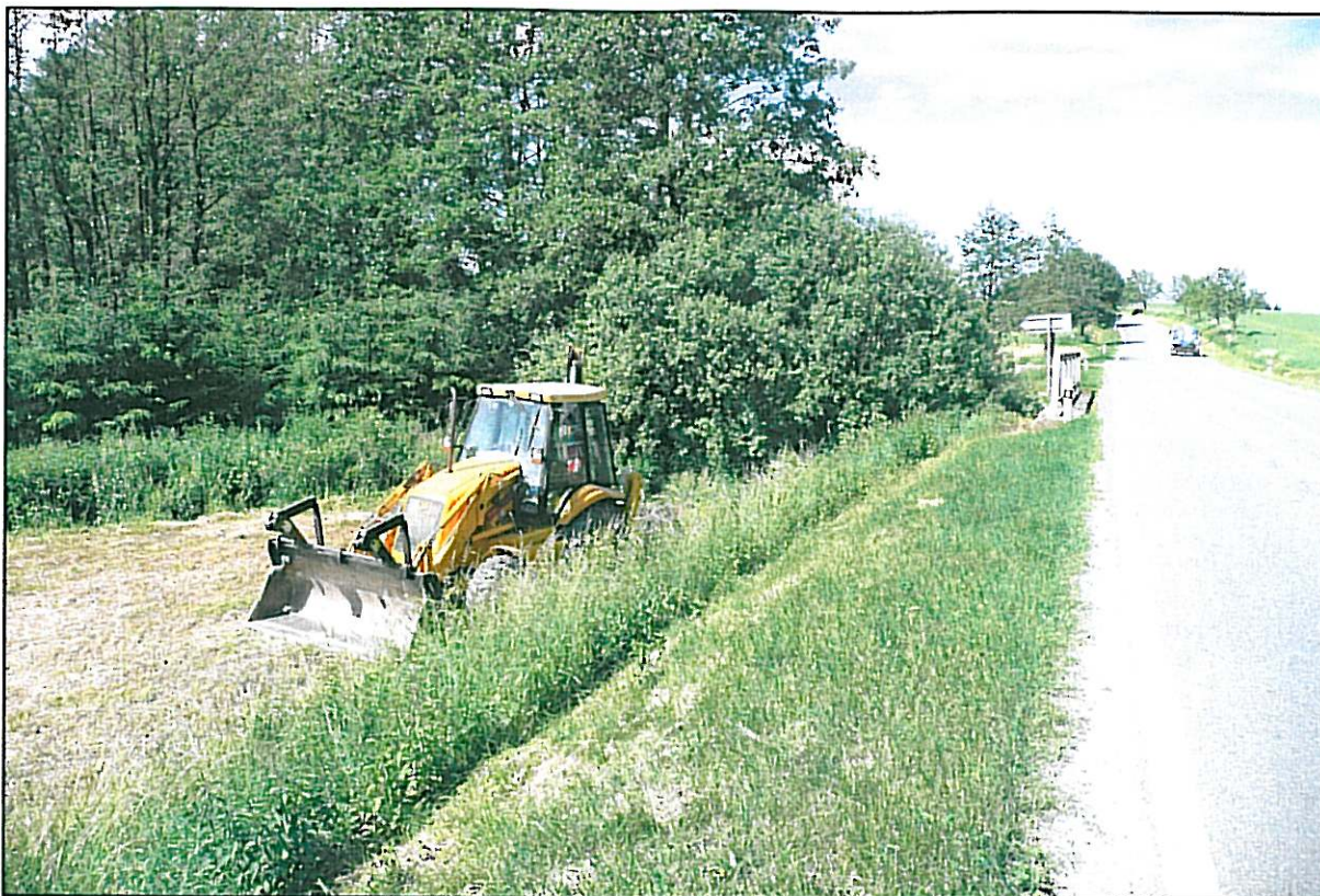
Foto č.7: Pohled na silnici II/353 v místě stávajícího mostku přes Zhořský potok s kolovým bagrem při hloubení průzkumné sondy K1 .
