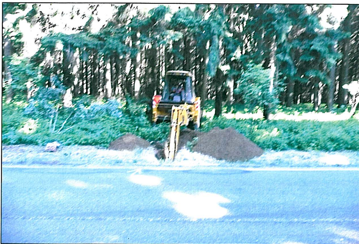
Foto č.10: Detailní pohled na hloubení průzkumné sondy K2 v místech třebíčského durbachitového masívu. Vytěžený materiál je tvořen písčitohlinitými eluviálními zvětralinami skalního podloží durbachitů třídy R6-R5.
