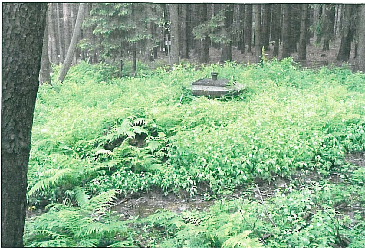
Foto č.19: Pohled na I.PHO a kopanou studnu S8 na pitnou vodu (hloubka 4,70) v prameništi Ochotského potoka. Studna je v lese nad silnicí, mimo dosah znečištění.
