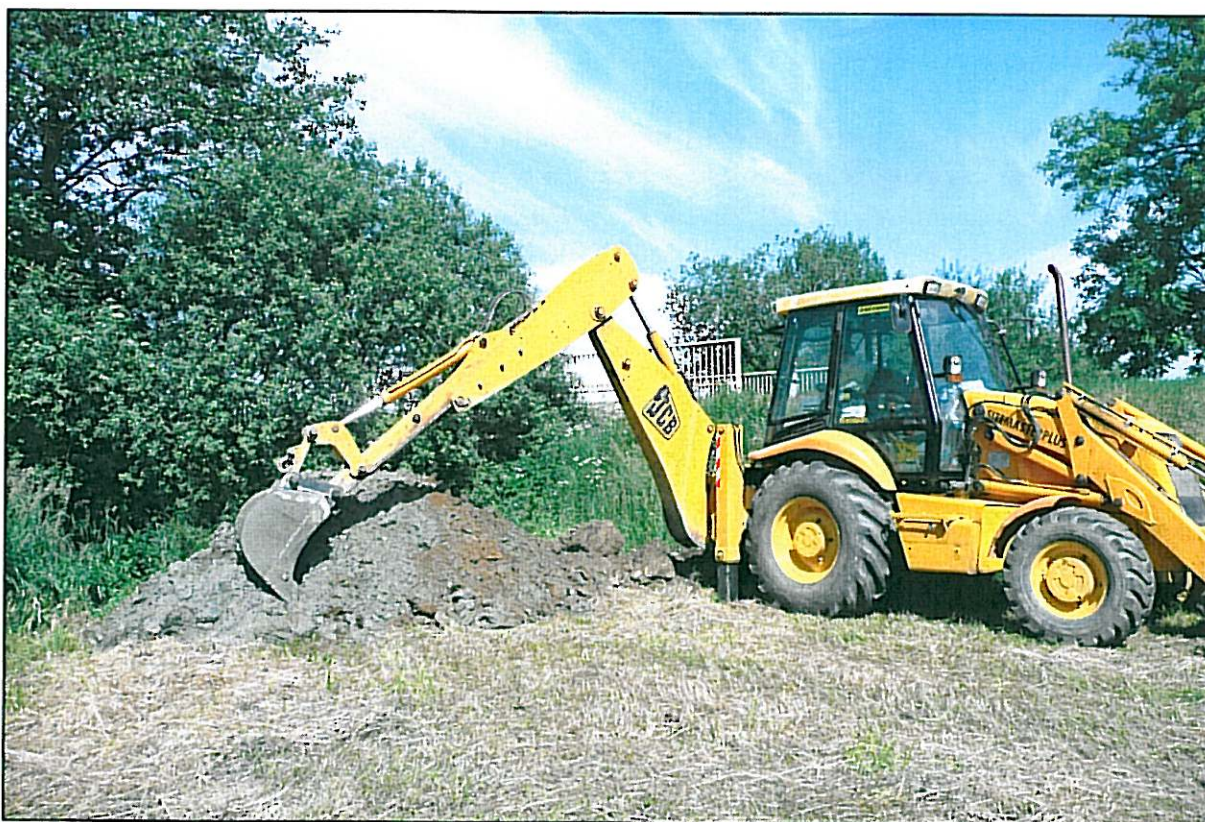
Foto č.8: Detailní pohled na hloubení průzkumné sondy K1 pro projektované nové založení silničního mostu přes Zhořský potok. Vytěžený materiál je tvořen deluviofluviálními sedimenty.
