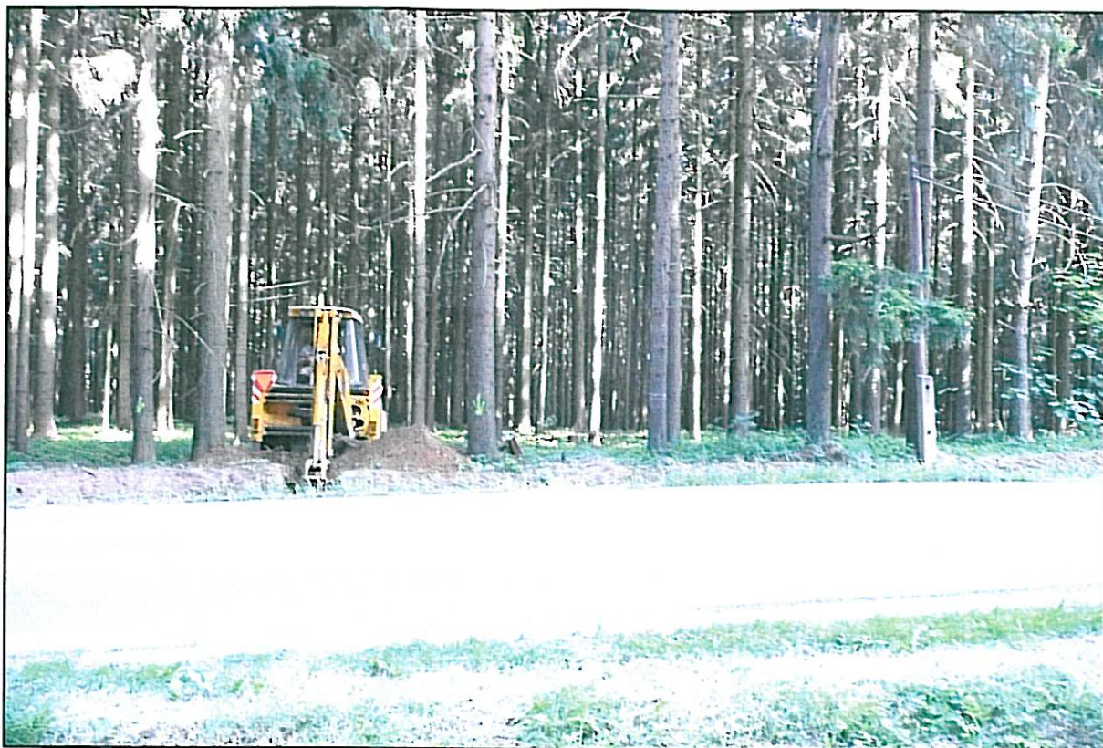
Foto č.11: Pohled na hloubení průzkumné sondy K3 v místě projektovaného 4m hlubokého zářezu silnice II/353 v lesním úseku mezi Zhoří a Stájí.
