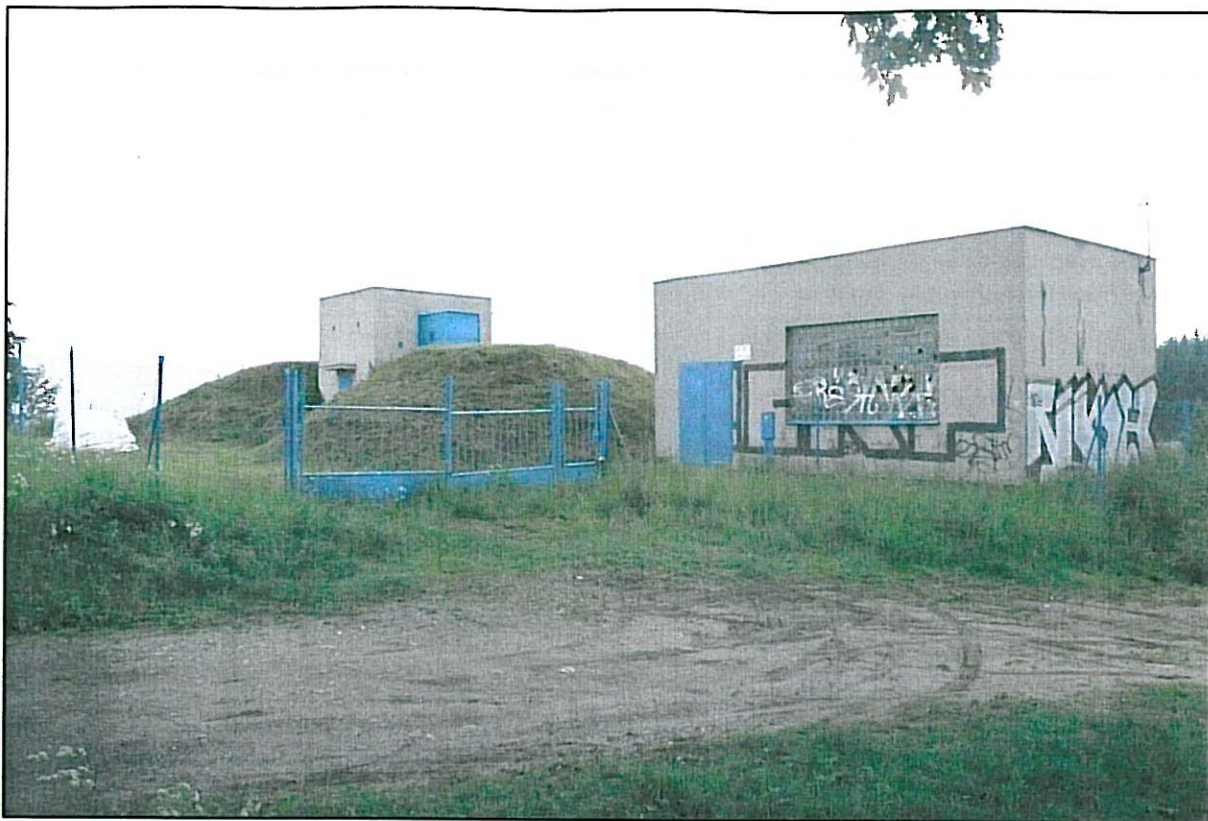
Foto č.21: Pohled na vodojem s úpravnou podzemní pitné vody na návrší nad Lipinskou křižovatkou. Z vodojemu je veden gravitační vodovod do obce Jamné.
