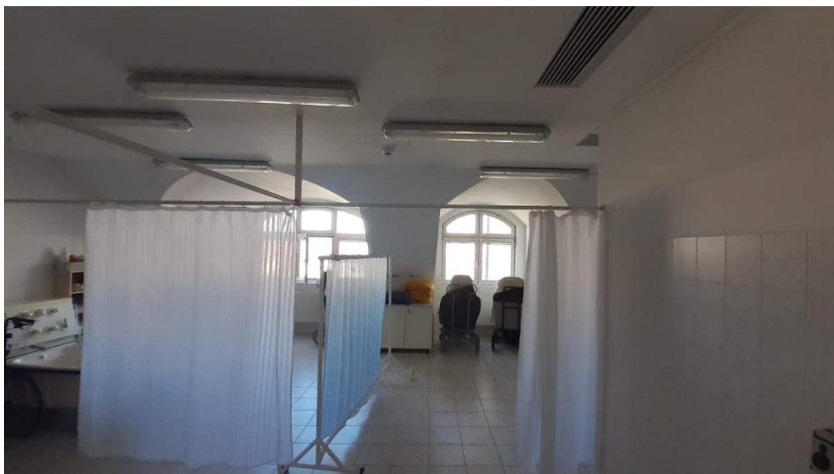
Obr. 13 Provozní místnost v části „C“
