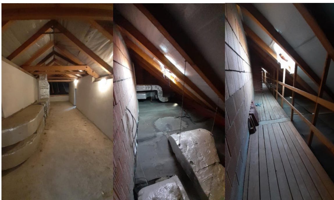
Obr. č. 11 Půdní prostor budovy „B“
