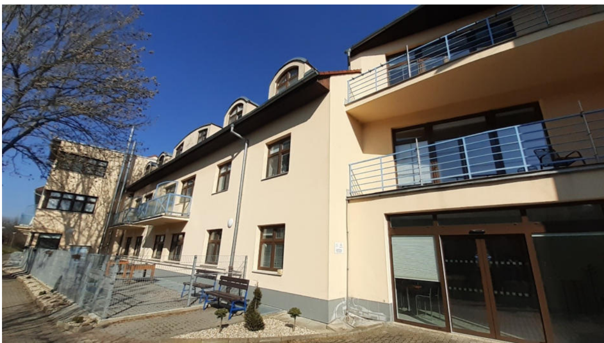
Obr. 14 Pohled na západní fasádu části „B“
