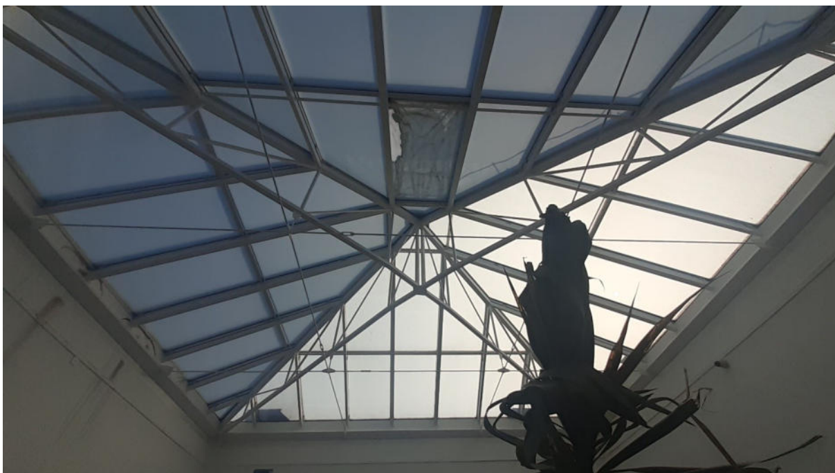
Obr. č. 8 Pohled na střešní plášť části „A“
