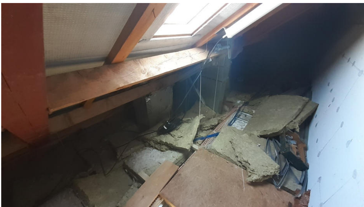
Obr. č. 9 Pohled na střešní plášť části „A“
