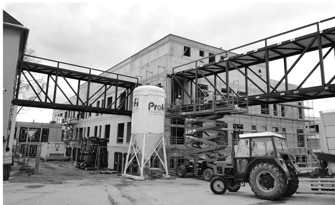
Obr.: Výstavba nového pavilonu DGPN – montáž ocelových konstrukcí spojovacích krčků.
