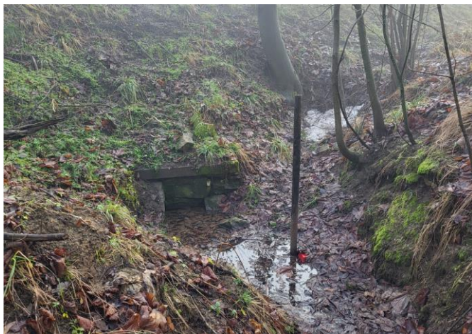
Propustek 110P – stávající vtokové čelo a terén na výtokové straně
