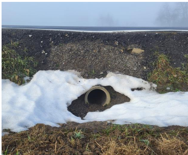
Propustek 111P – stávající vtokové a kolmé výtokové čelo
