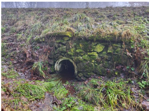
Propustek 109P – stávající vtokové čelo a terén na výtokové straně
