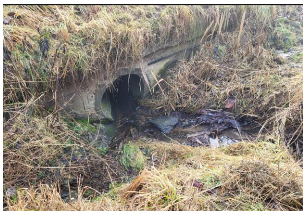
Propustek 112P – stávající vtokové a výtokové čelo
