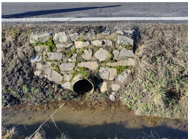
Propustek xxxP – stávající vtokové čelo
