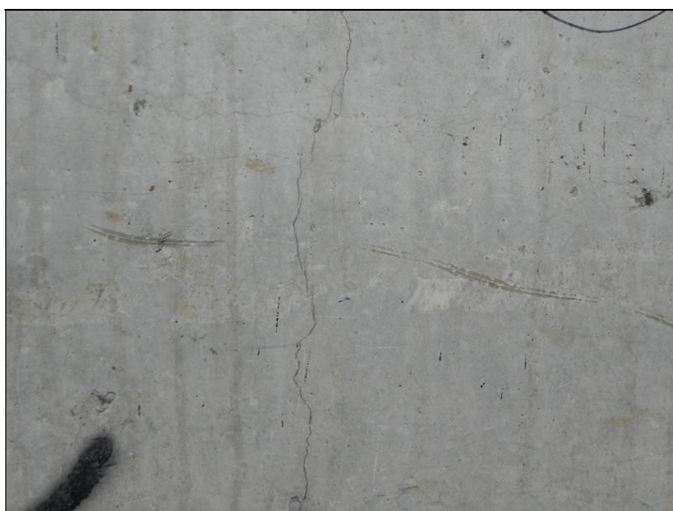
OP2 - svislá trhlina
