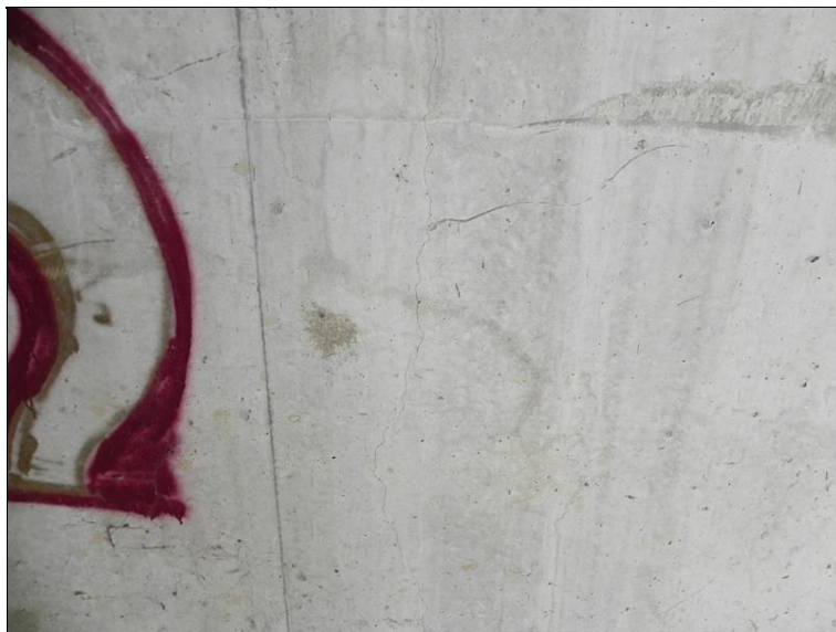
OP1 - svislá trhlina
