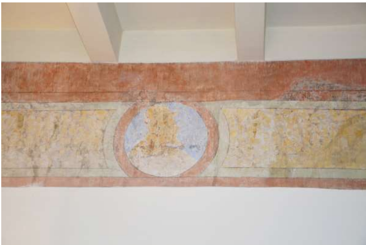
34. Místnost s názvem Knihovna 2.08. Restaurovaná dekorativní malba pod stropem doplněná rekonstrukcí pomocí šrafování plochy.
