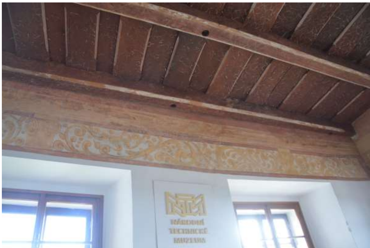
51. Rekonstruovaná dekorativní malba se záklopovým stropem ve Velkém sále 2.10.
