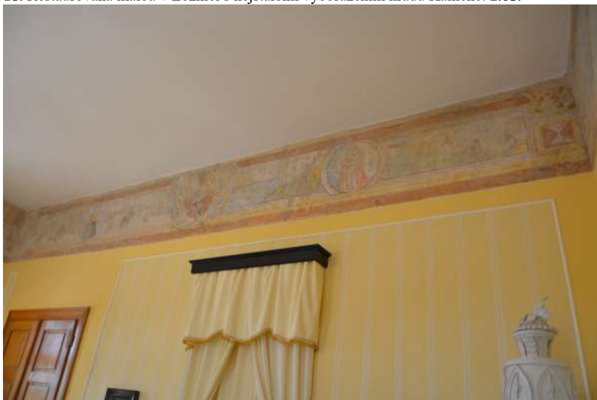
19. Malby pod stropem v Ložnici 2.05.
