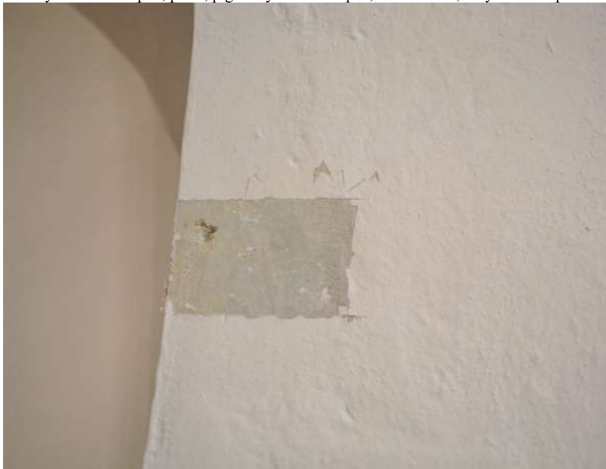
1. Povrchová sonda A1. Barevné vápenné nátěry v okrové a šedé barvě. Rytířský sál 2.16.
