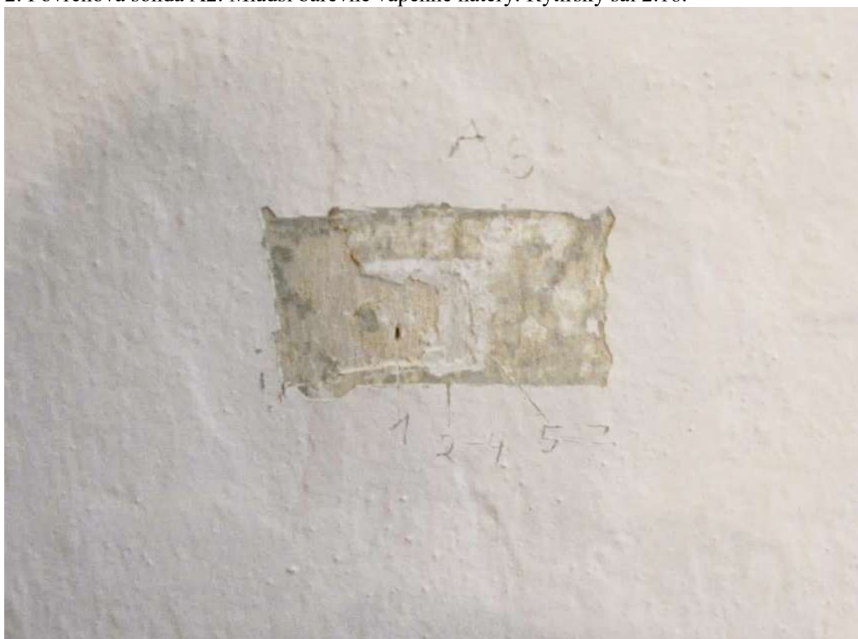
3. Povrchová sonda A3. V sondě torzo dekorativní výmalby. Rytířský sál 2.16.
