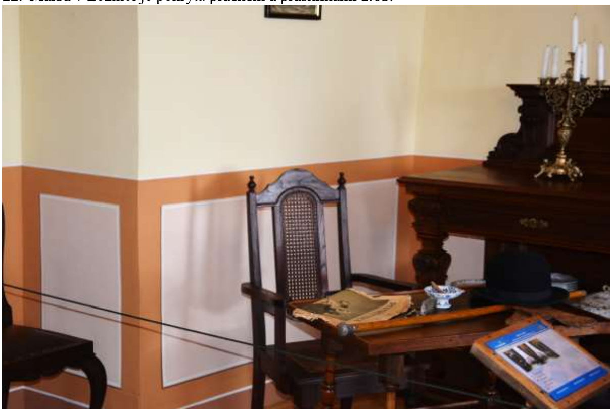
23. Rekonstrukce malovaného iluzivního obložení v Jídelně 2.06.
