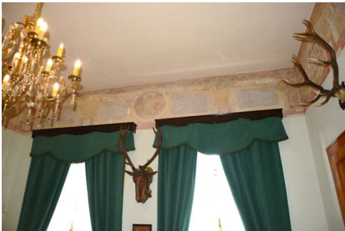
12. Malby v pásu pod stropem Loveckého salóňu 2.04.
