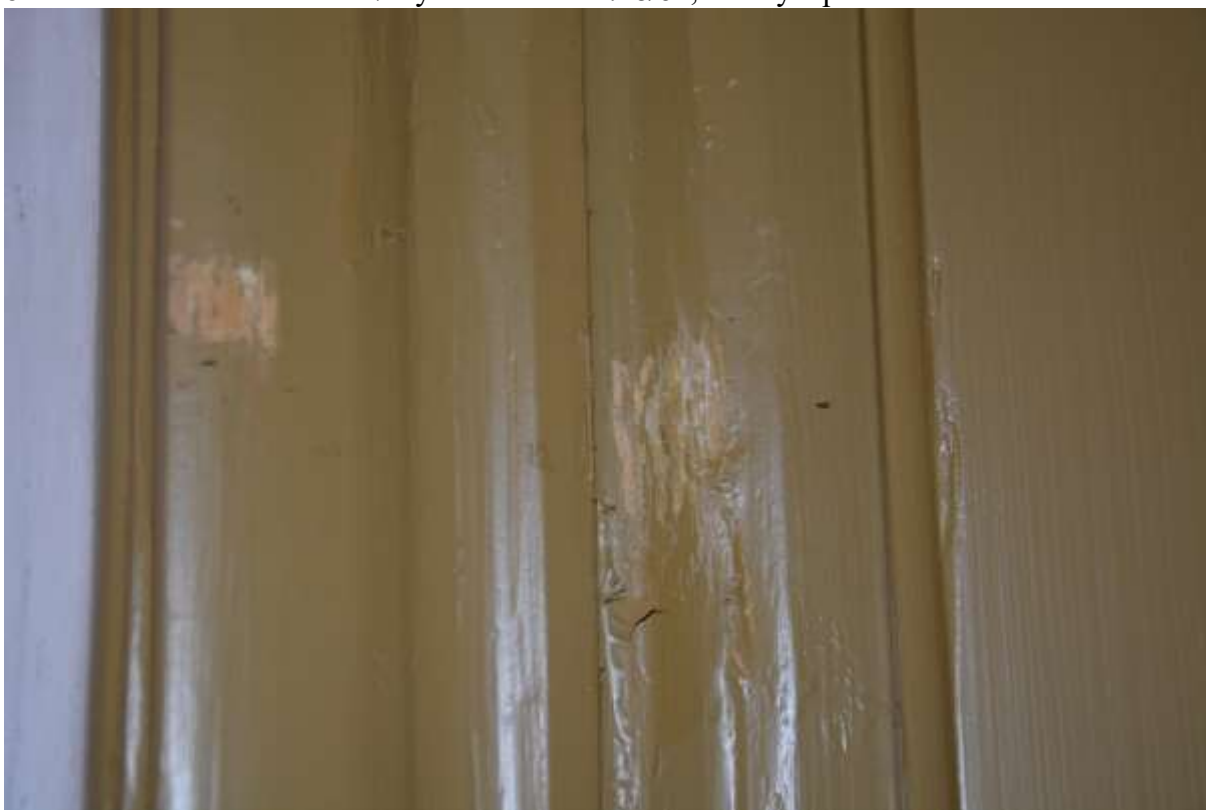
7. Sonda na zárubni na chodbě. Nalezená lomená bílá barva. Místnost 2.03 a 2.02
