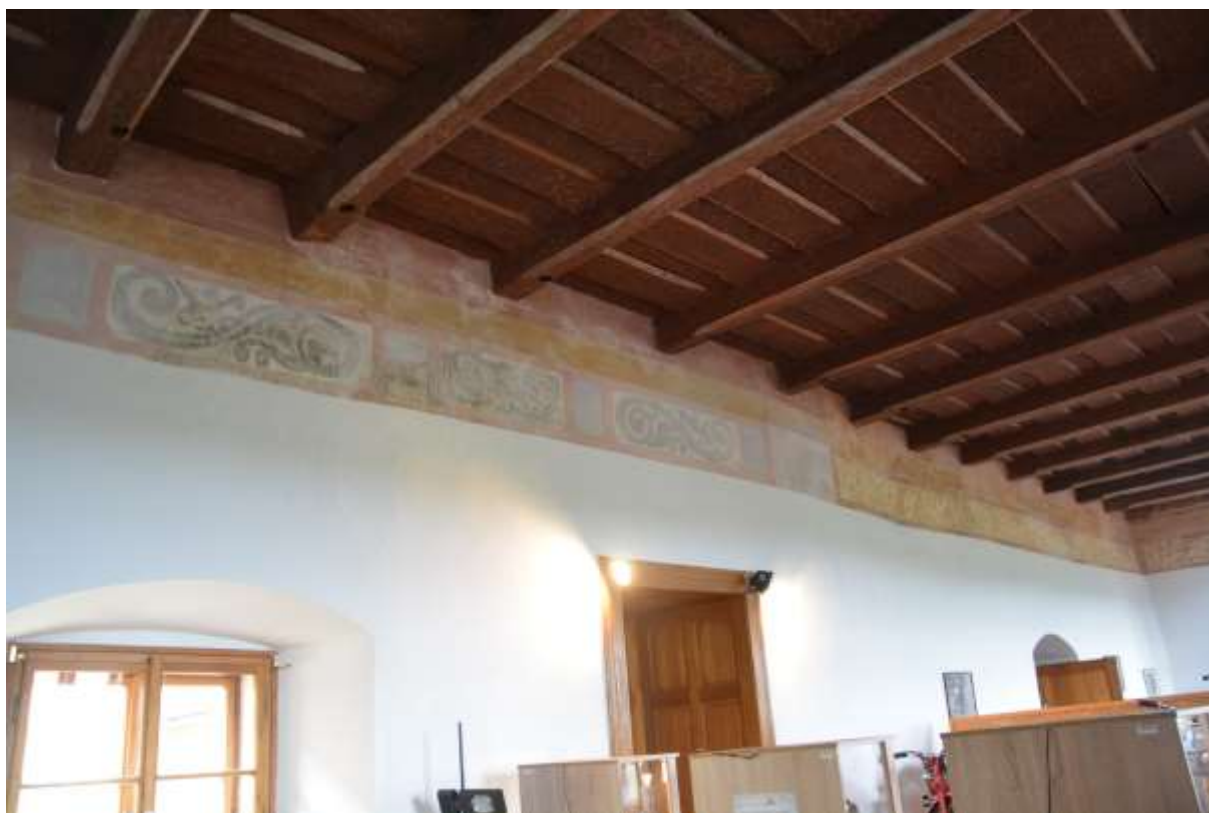
43. Restaurované malby s doplněným záklopovým stropem 2.10.
