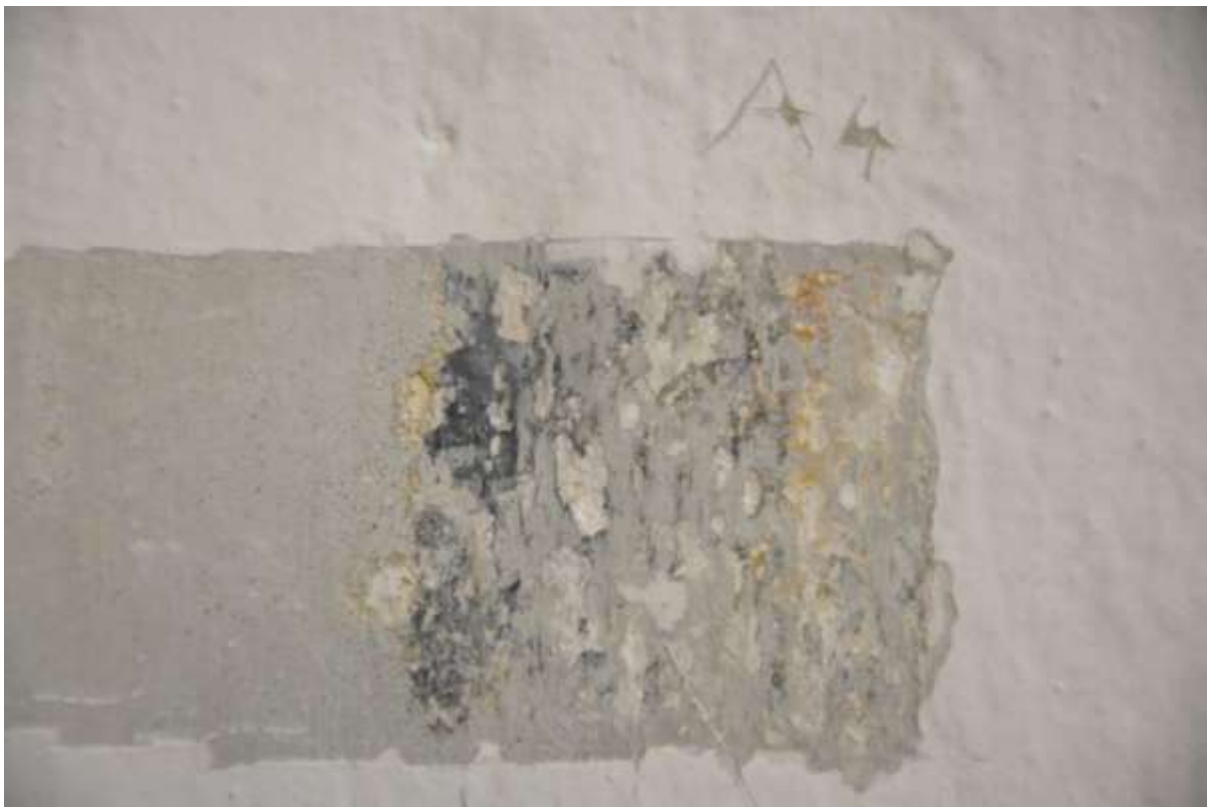
4. Povrchová sonda A4. V nejstarší vrstvě byla objevena dekorativní výmalba. Rytířský sál 2.16.
