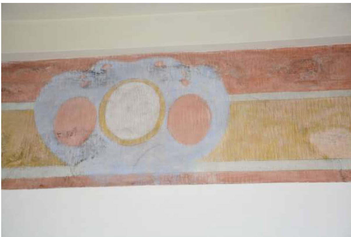
37. Místnost 2.08. Restaurovaná dekorativní malba pod stropem doplněná rekonstrukcí pomocí šrafování plochy.
