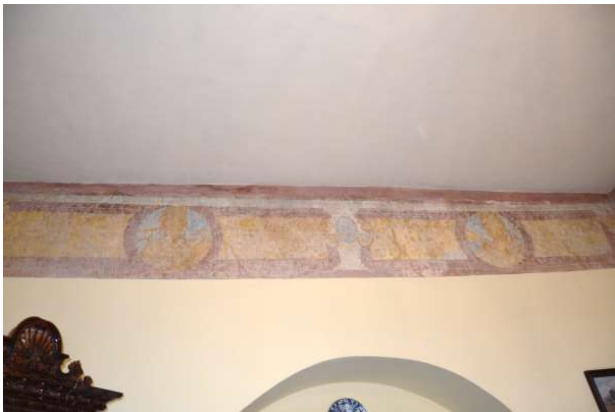
28. Restaurovaná dekorativní malba v Jídelně 2.06 pod stropem doplněná rekonstruovanou plochou.
