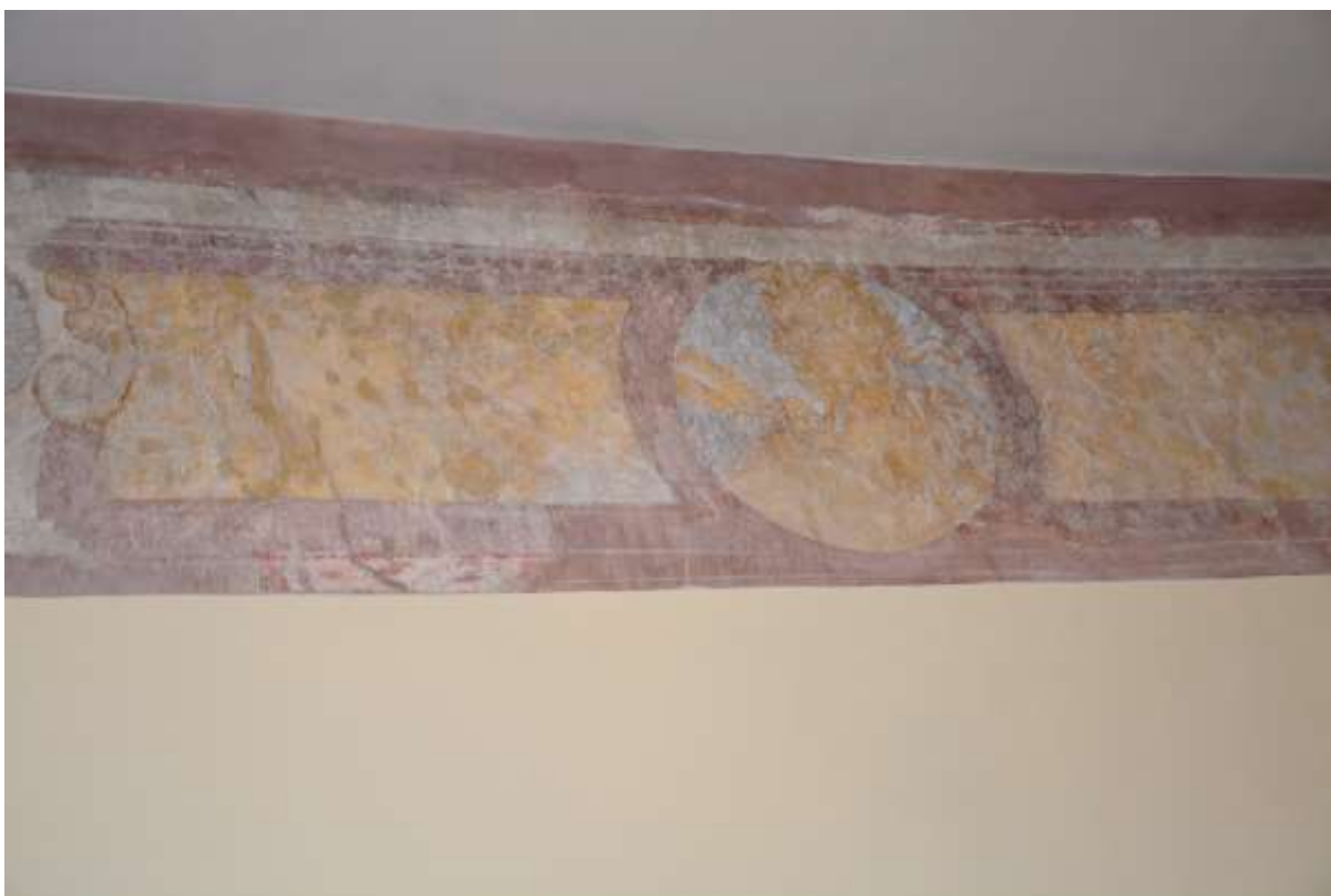
25. Restaurovaná dekorativní malba v Jídelně 2.06 pod stropem a doplněná neutrální retuší.
