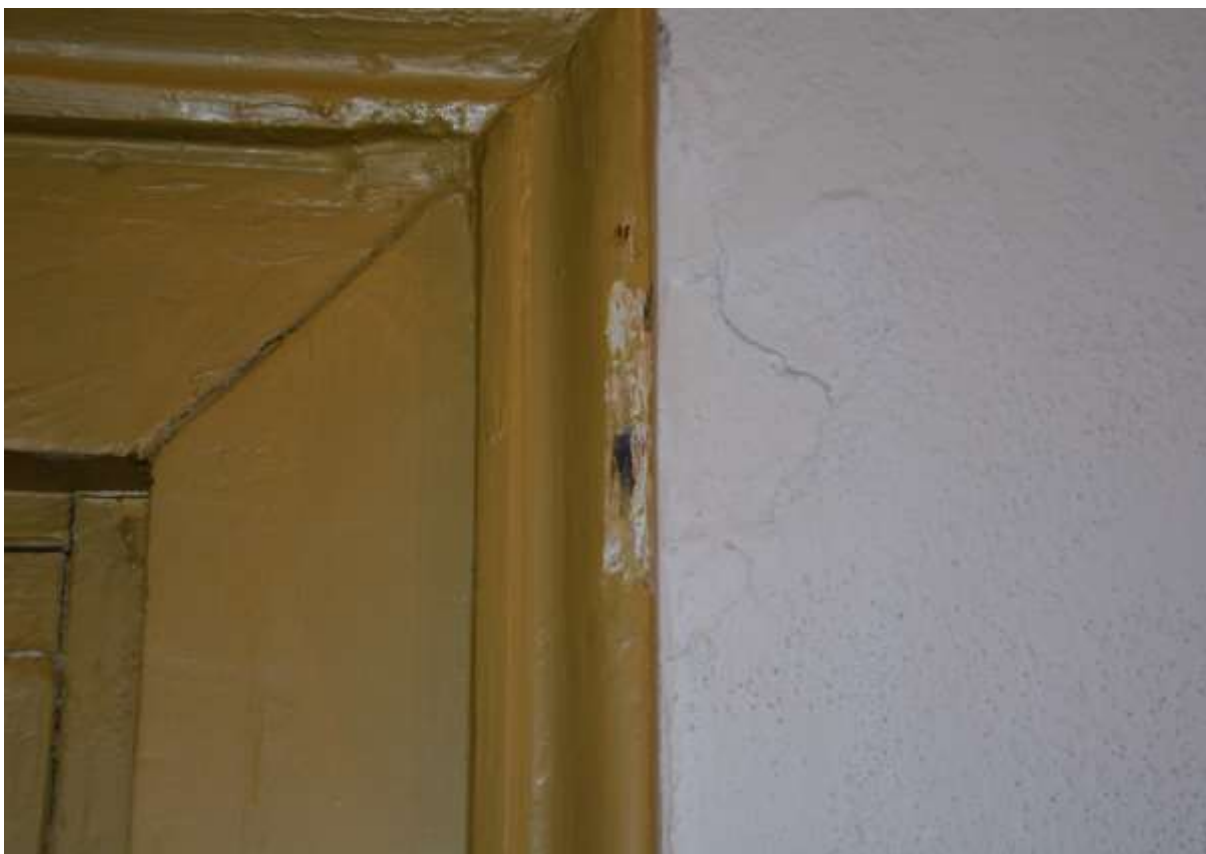
8. Menší jednokřídlé dveře na chodbě - na lomené bílé sonda odhalila zbytky tmavě hnědé barvy. Jídlna 2.06/2.02 chodba.
