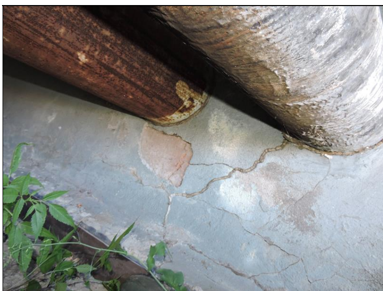
Pohled na opěru č. 2 - pole č. 2 - příčná trhлина, opadaný kus zdiva
