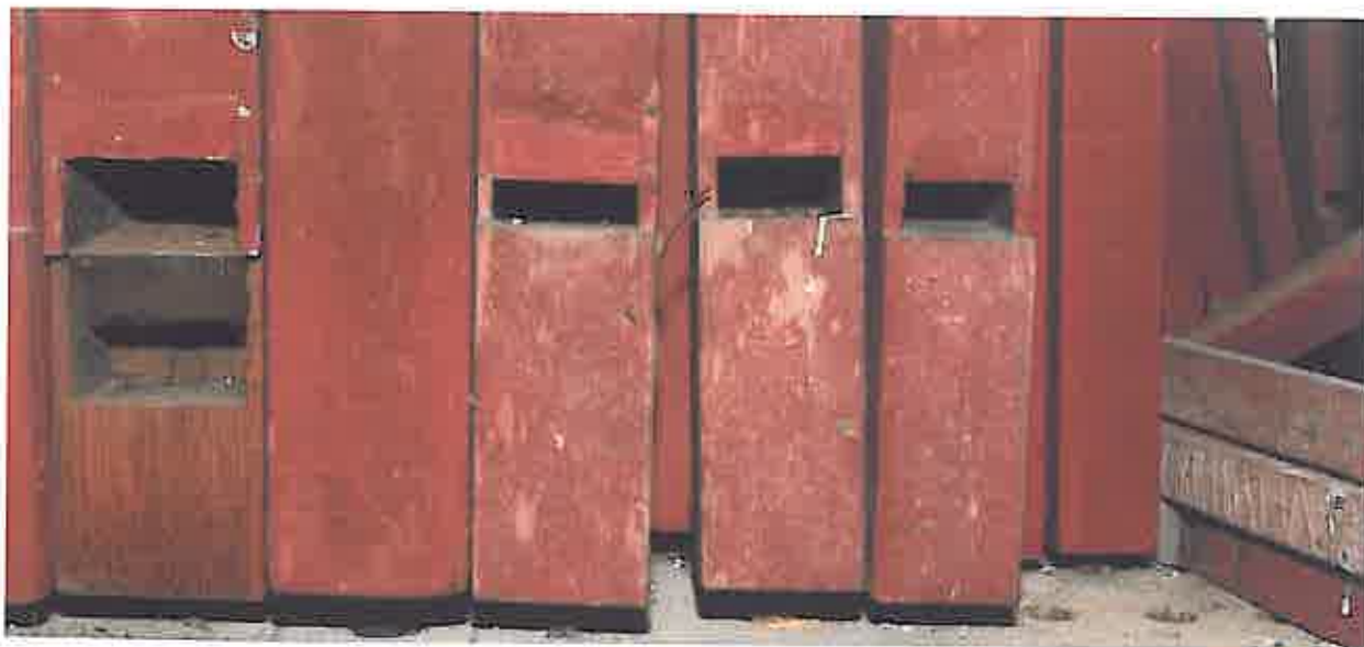
Labium první píšťaly zleva bez předkrývky nepůvodně zvýšeno, u třetí snižováno
