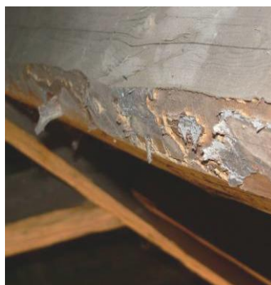
Obr. Příklady neodkornění prvků konstrukce
