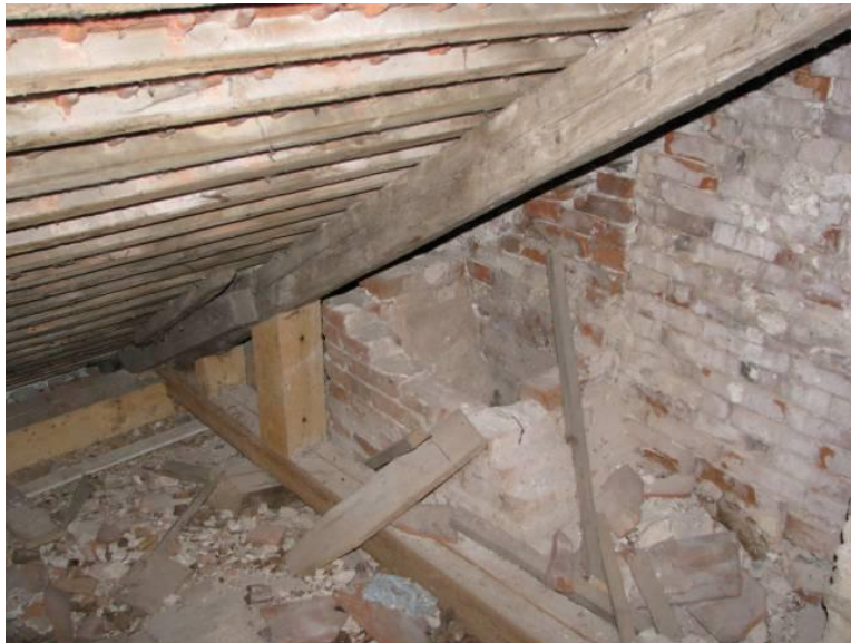
Obr. Torzo ubouraného komína na půdě oratoře.
