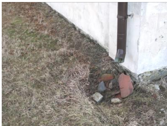
Obr. Současné nevhodné vyústění svodů
