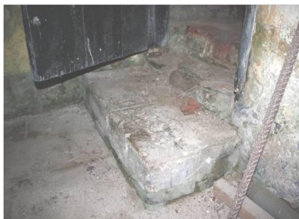
Obr. Pískovcový stupeň v sakristii.
