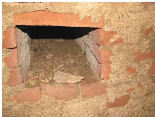
Obr. Funkční větrací průduch hrobky
