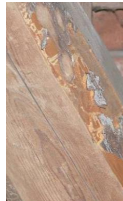
Obr. Příklady neodkornění prvků konstrukce
