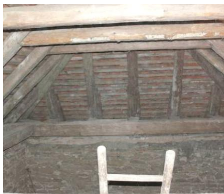
Obr. Průhled dolní částí konstrukce nad presbytářem a neodkorněný hambalek
