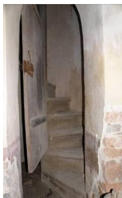
Obr. Vřetenové schodiště na kůr
