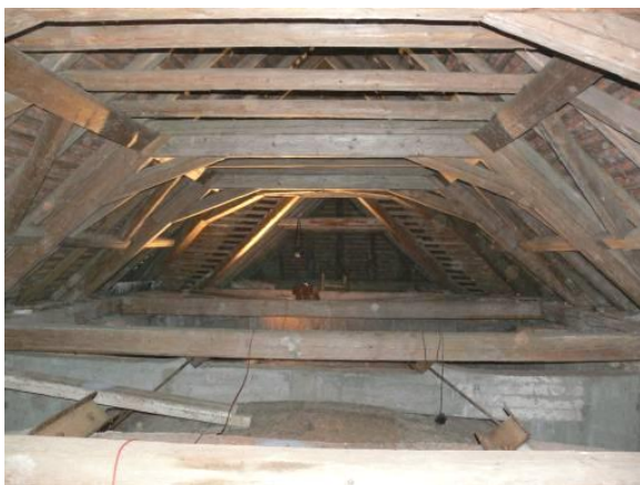
Obr. Průhled dolní částí konstrukce krovu nad lodí
