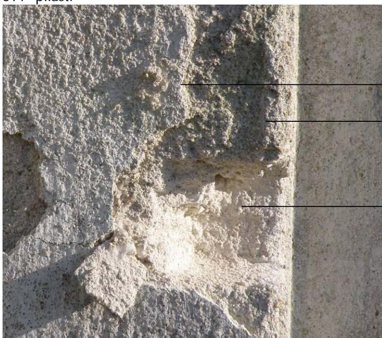
Vnější omítkový plášť tvoří především současná vrstva točeného
