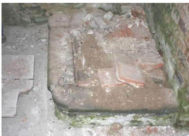
Obr. Žulové stupně u bočních oltářů
