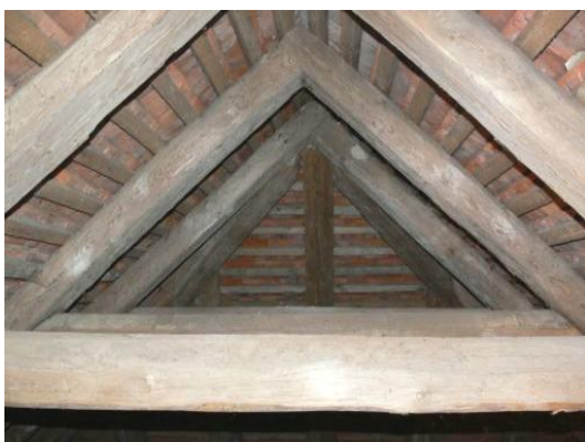
Obr. Průhled dolní částí konstrukce nad presbytářem a neodkorněný hambalek
