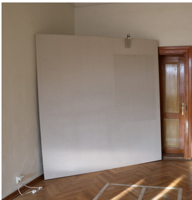
Místnost 204 – dřevotřískový panel potažený textilií.
