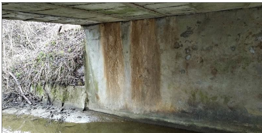
inkrustace a rezavé výluhy.
