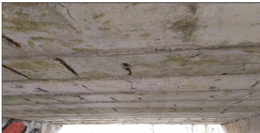
inkrustace a rezavé výluhy.
