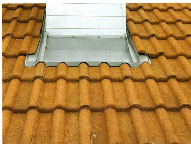
foto/19/ Pohled na oplechování potrubí VZT
