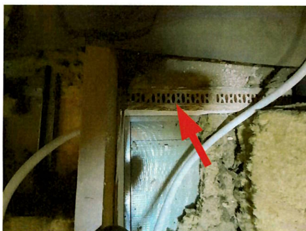
foto/32/ Pohled na prostupující stěnu podhledem
