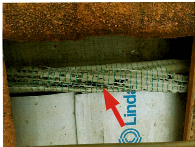
foto/18/ Pohled na napojení fólie na plechovou střechu
