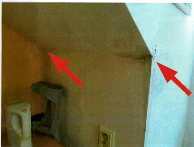
foto/1/ Pohled na stopy zatékajících srážek v místě napojení vikýře a šikmé střechy
