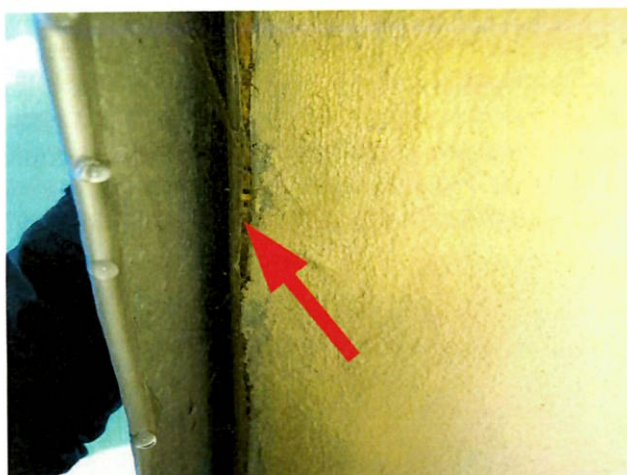
foto/27/ Pohled na přívodní větrací otvor u vikýřů
