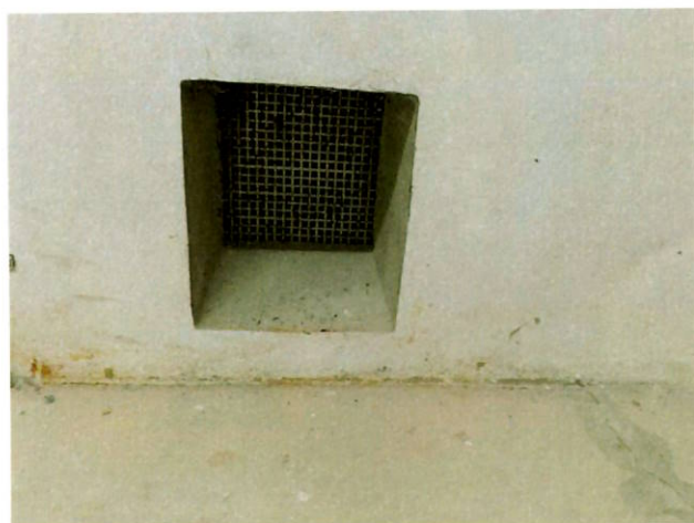
foto/26/ Vyústění odvětrání výtahové šachty do podstřešního prostoru
