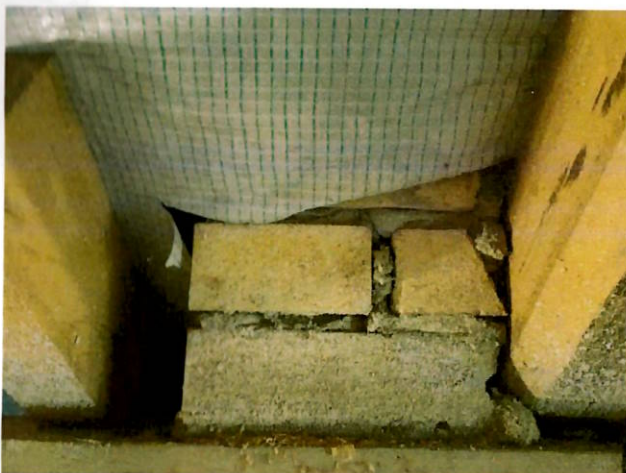
foto/15/ Pohled na provedení prostupů fólií
