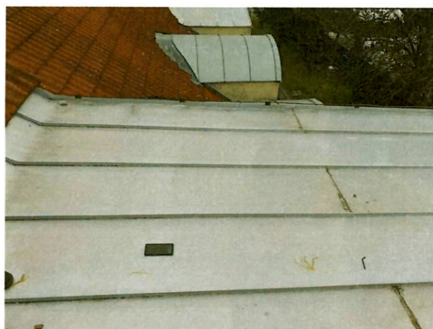
foto/4/ Pohled na plochou střechu s plechovou krytinou z falcovaného plechu
