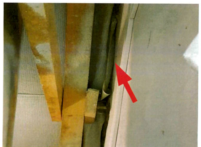
foto/16/ Pohled na ukončení fólie u stěny
