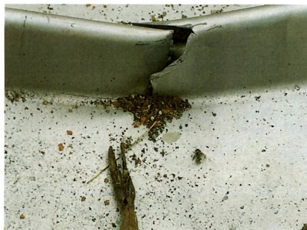
foto/8/ Detail provedeního ohybu stojaté drážky
