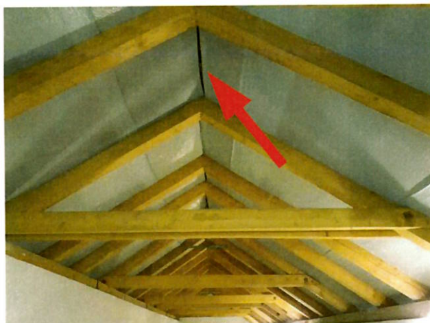
foto/25/ Pohled do hřebene krovu z podstřešního prostoru na ukončení DHV
