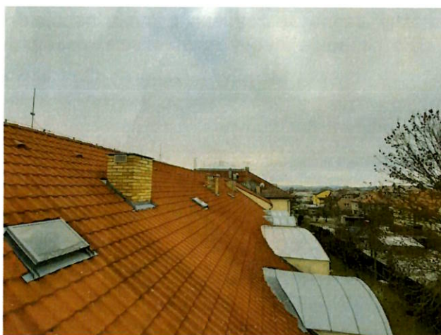
foto/3/ Pohled na předmětnou střechu se skládanou krytinou a vikýři
