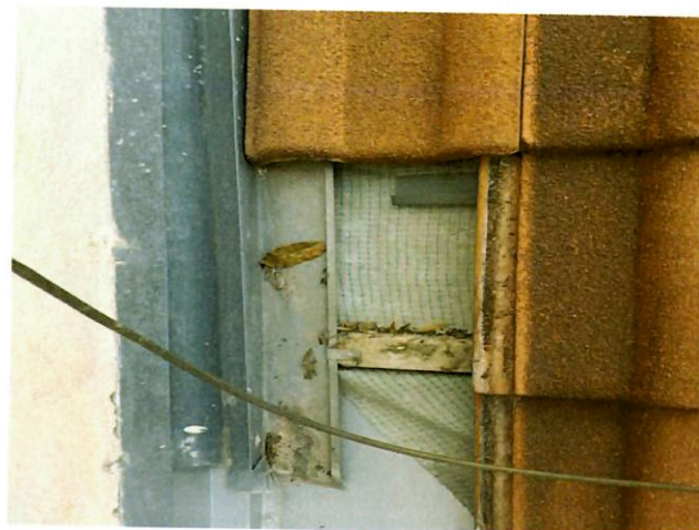
foto/22/ Pohled na oplechování mezistřešní stěny
