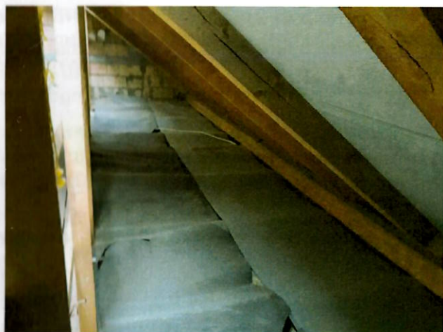
foto/29/ Pohled na konstrukci podhledu z podstřešního prostoru
