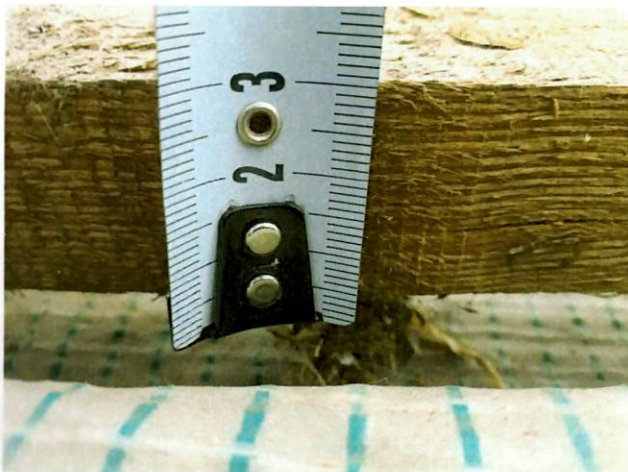
foto/13/ Tloušťka latí 30 mm
