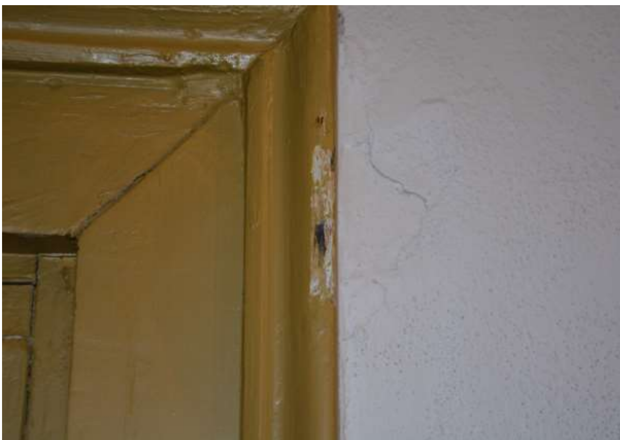
8. Menší jednokřídlé dveře na chodbě - na lomené bílé sonda odhalila zbytky tmavě hnědé barvy. Jídelna 2.06/2.02 chodba.
