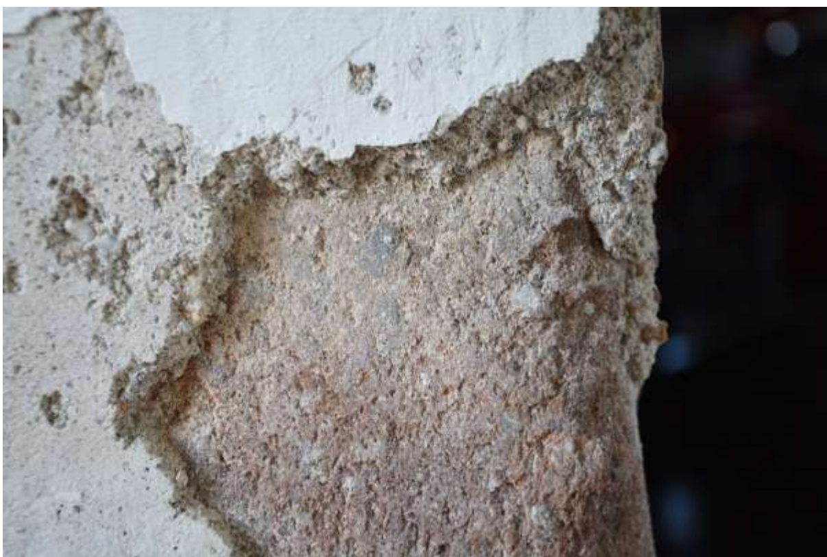
56. Sonda ve starém paláci 2.14 odhalila gotickou omítkou zčervenalou požárem. Důkaz, že hrad v neznámé době vyhořel.
