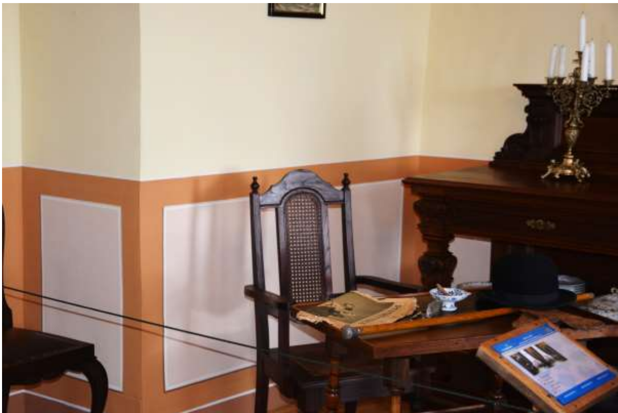
23. Rekonstrukce malovaného iluzivního obložení v Jídelně 2.06.
