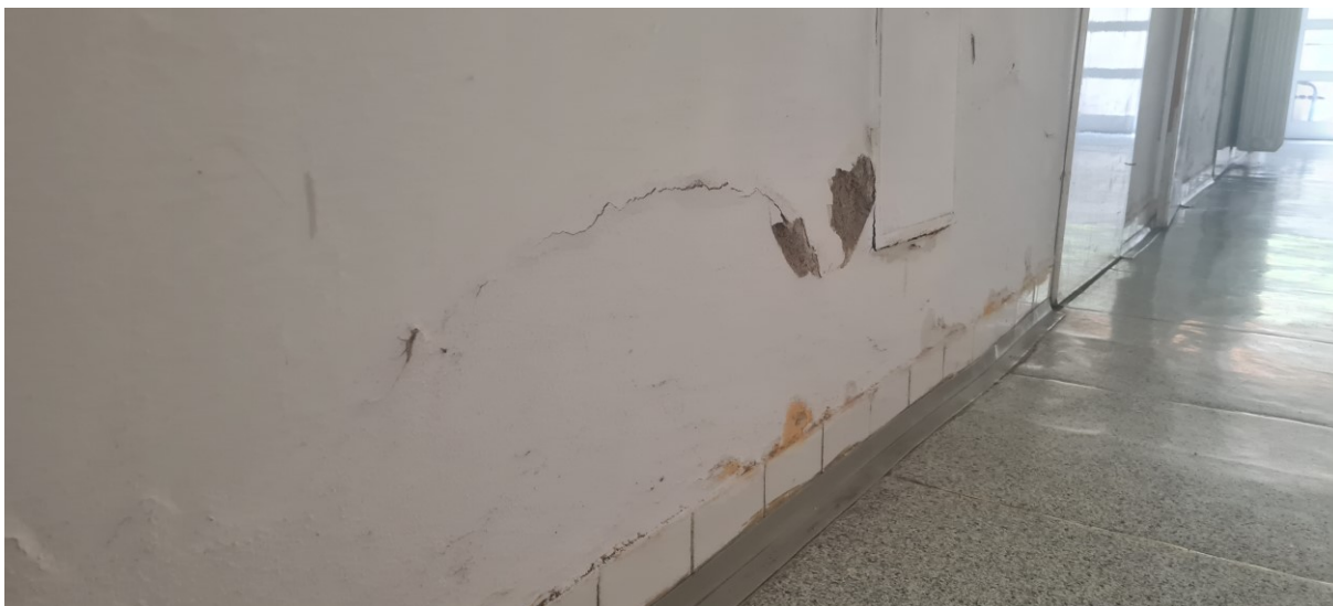
Obr. č. 12 Chodba
