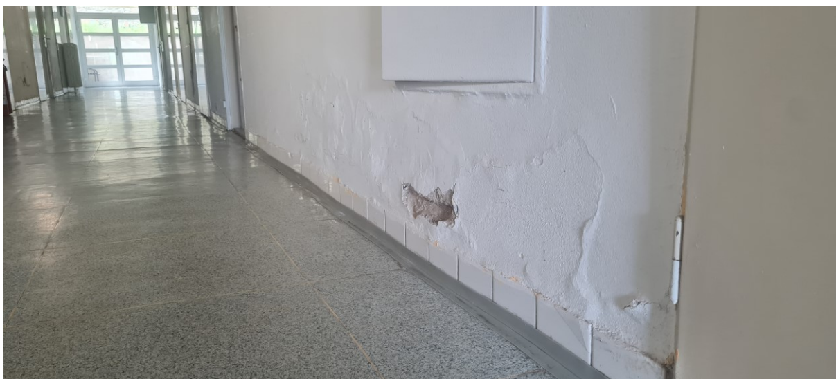
Obr. č. 12 Chodba
