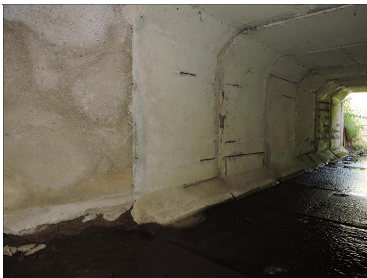
Pohled na opěru č. 1 - rozšíření
