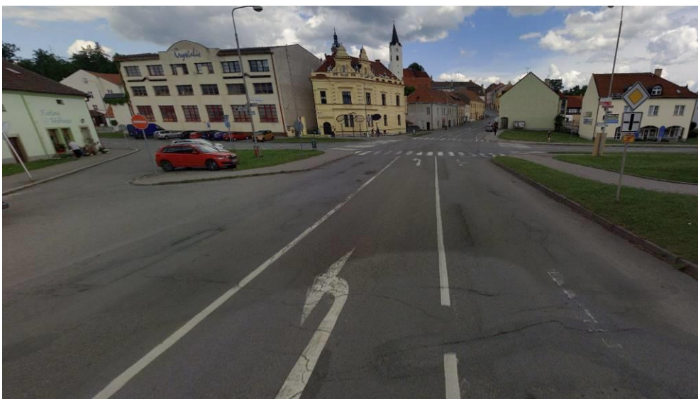
Obr. 8 Pohled na stávající křiž. II/128 x III/1293 ul. Ul. Hronova
