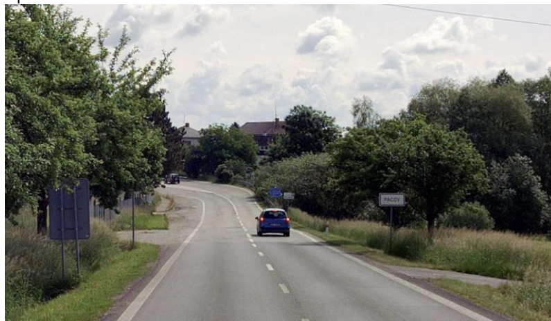
Obr.1 Pohled na začátek stavby silnice II/129
