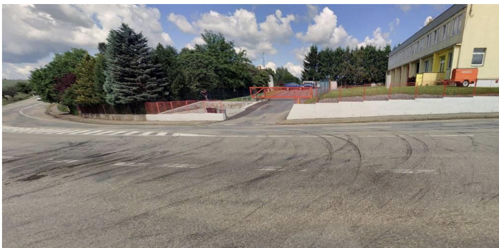
Obr. 4 Pohled na rozhledové poměry na silnici II/128 do směru silnice II/129
