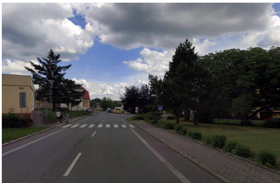
Obr. 15 Pohled na přechod pro chodce na sil. č. II/129 – konec stavby
