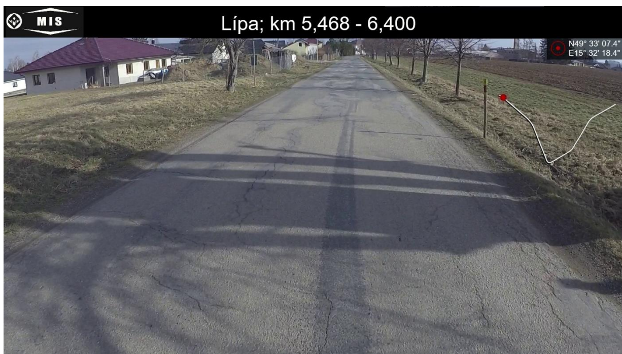
15 Trhlina podélná rozvětvená
