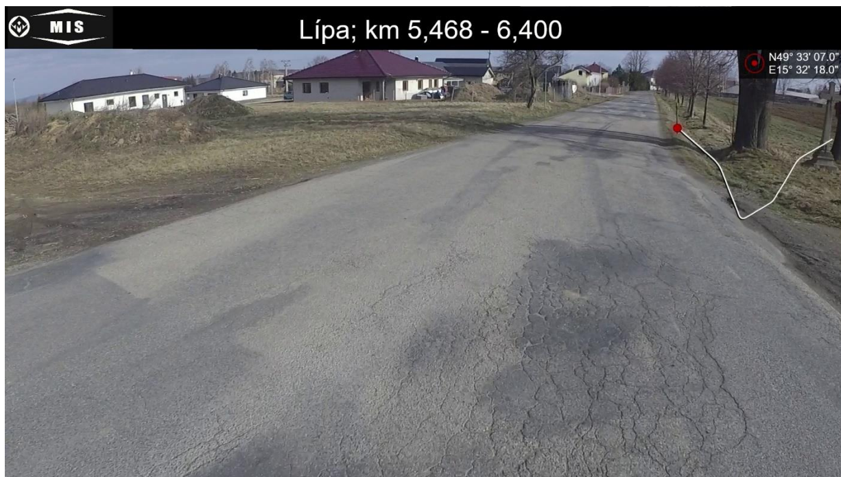
17 Síťové trhliny
