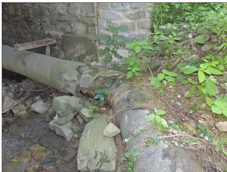
Vodovod pro město Třebíč - kameny z opevnění křídla č. 2 pravá ohrožují jeho funkci
