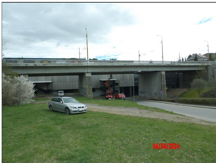
Pohled na most zprava
