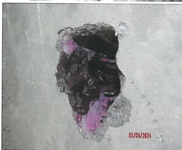
Obr. 3. 28: Detail po zkoušce karbonatace roztokem fenolftaleinu – karbonatace betonu 0 mm.
