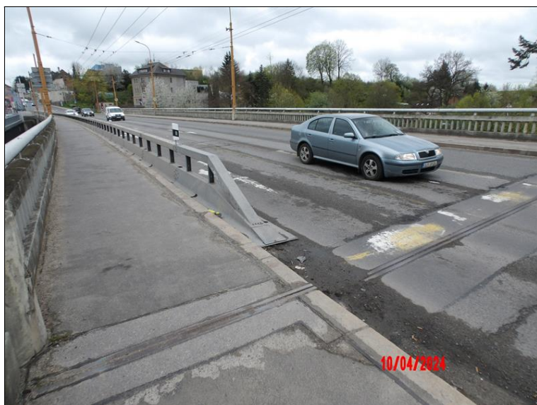
Most po směru staničení
