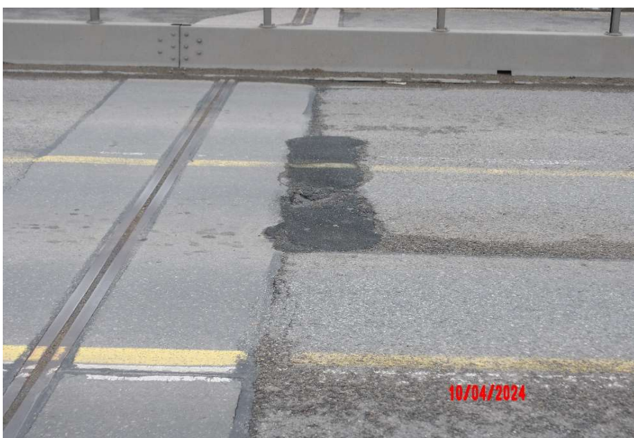
MZ3 - detail vysprávek
