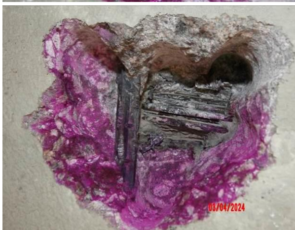
Obr. 3. 37: Detail po zkoušce karbonatace roztokem fenolftaleinu – karbonatace betonu 0 mm.
