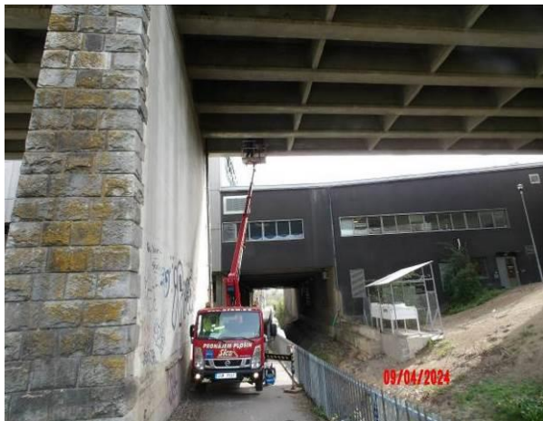
Obr. 3. 1: Veškeré práce na nosné konstrukci byly provedeny z montážní plošiny, pole 3.
