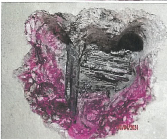
Obr. 3. 34: Detail po zkoušce karbonatace roztokem fenolftaleinu – karbonatace betonu 0 mm.
