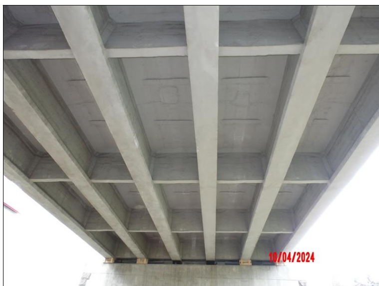
Podhled NK v poli 1 - pohled k P2
