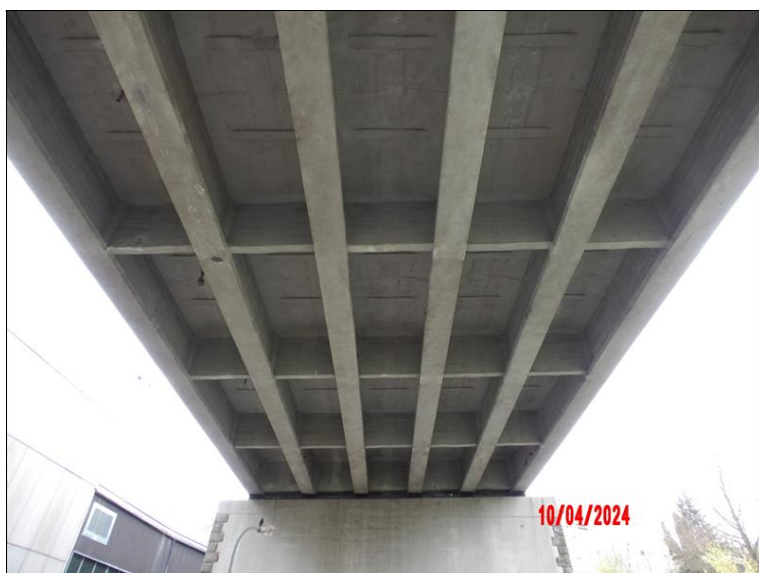
Podhled NK ve 2. poli - pohled k P3
