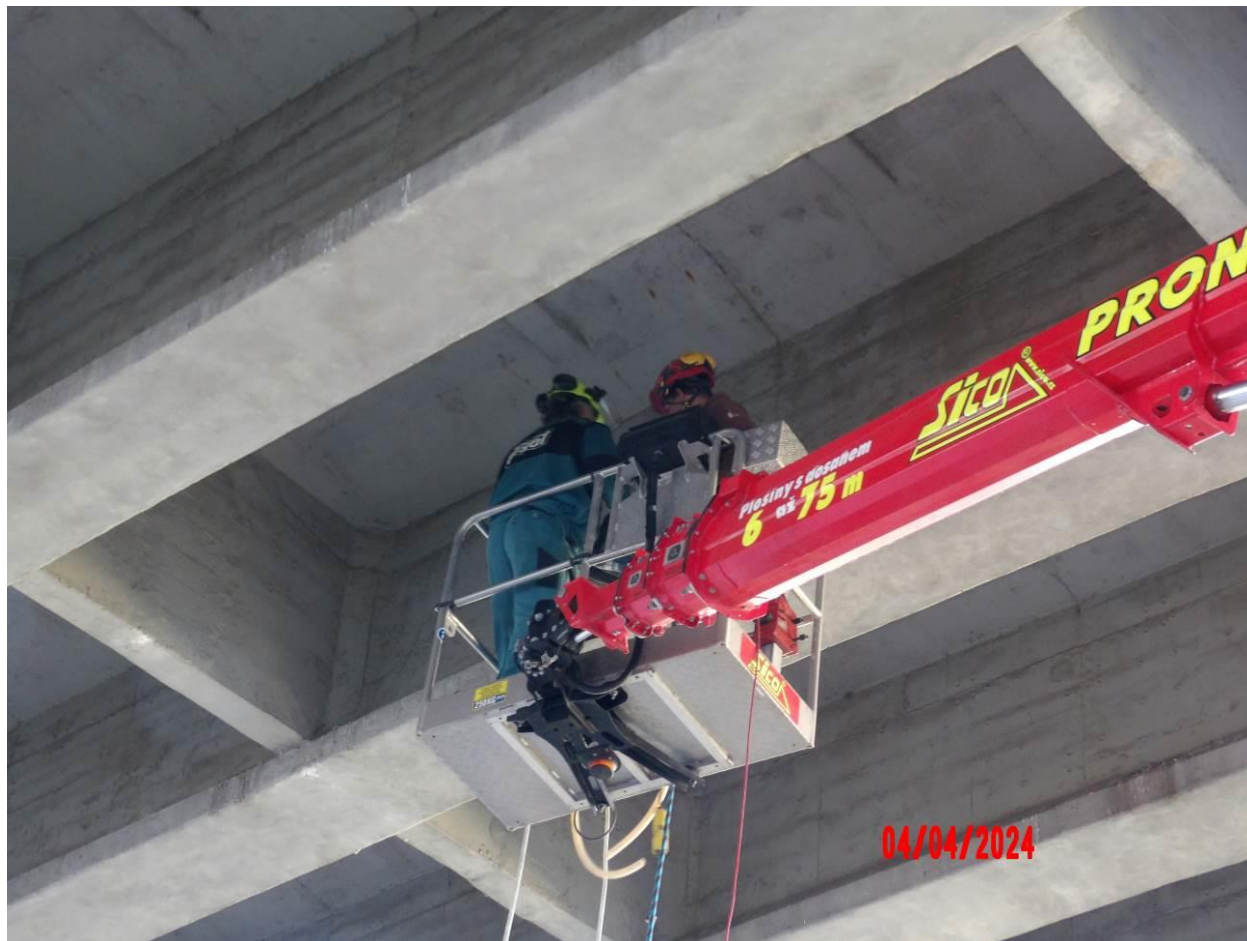
Obr. 3. 10: Odběr jádrového vývrťu z NK
