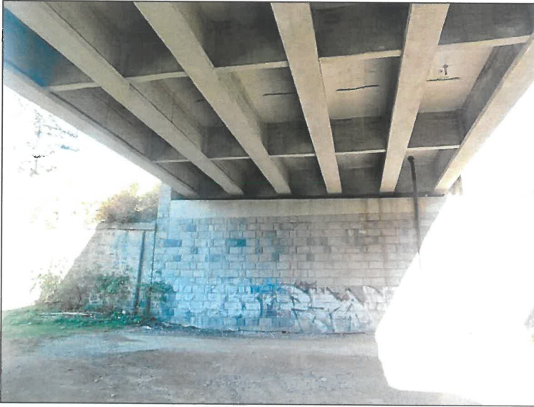
Pohled na opěru OP4.
