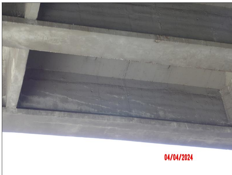
Levý krajní trám v poli 3 mezi 2. a 3. příčným. Trhliny kopírující průběh předpětí.
