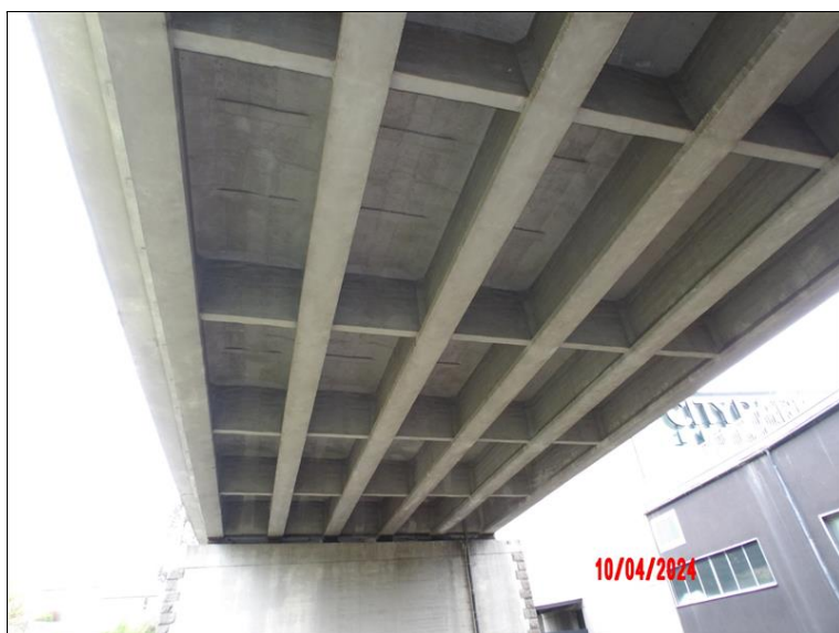
Podhled NK ve 3. poli - pohled k P3
