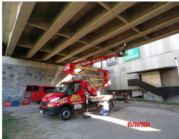
Obr. 3. 2: Veškeré práce na nosné konstrukci byly provedeny z montážní plošiny, pole 2.
