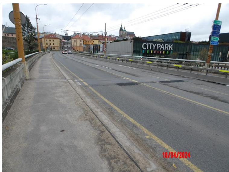
Most proti směru staničení
