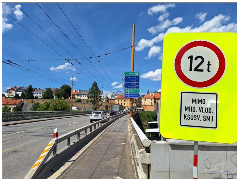
Most proti směru staničení - dopravní značení, které zamezuje vjezd na most vozidlům s hmotností větší než 12 t.
