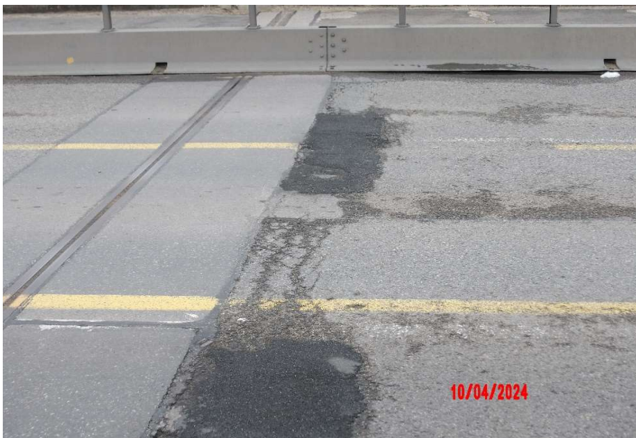
MZ4 - detail vysprávek
