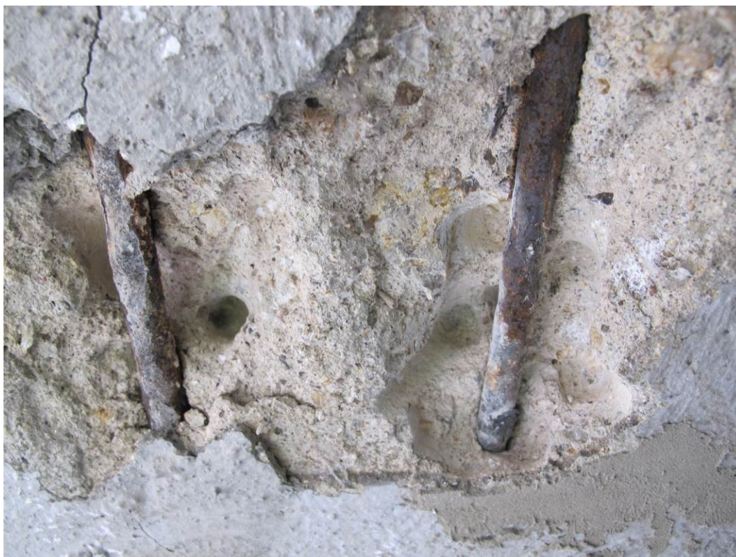
Obr. 4.9: Sekaná sonda K1, odhaleny dva pruty průměru 12 mm, hladká výztuž. Krytí jednoho prutu 6 mm, krytí druhého prutu 17 mm. Pruty napadeny korozí, oslabení cca 10 % průřezové plochy.
