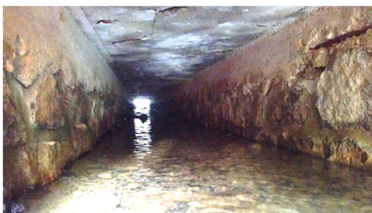
Propustek 350-004P – vnitřní rozpraskaný strop patrné obnažení spár
