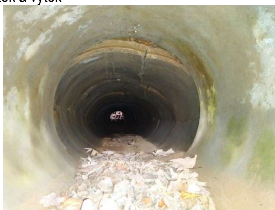
Propustek 350-003P – vnitřní prasklé a zanesené trouby
