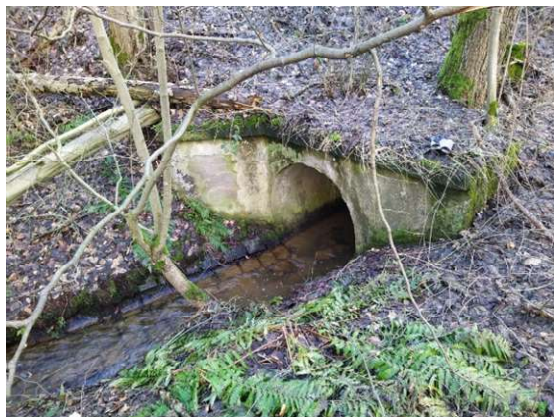
Propustek 350-004P – stávající vtok a výtok
