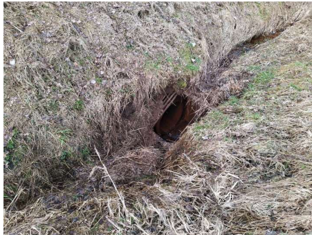
Propustek 350-009P – stávajíc vtok s přítoky a výtok s lapačem splavenin/HV
