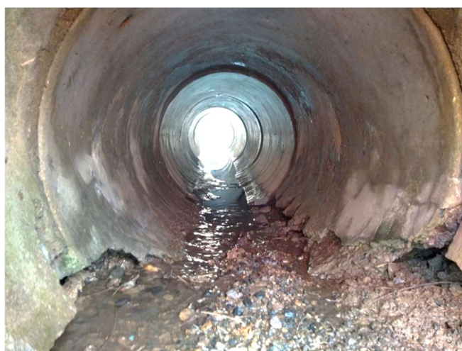
Propustek 350-008P – materiálová degradace trouby
