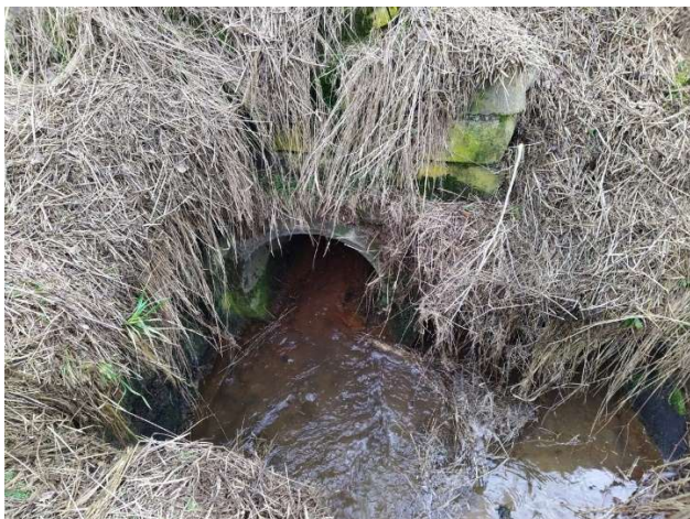
Propustek 350-009P – stávajíc vtok s přítoky a výtok s lapačem splavenin/HV
