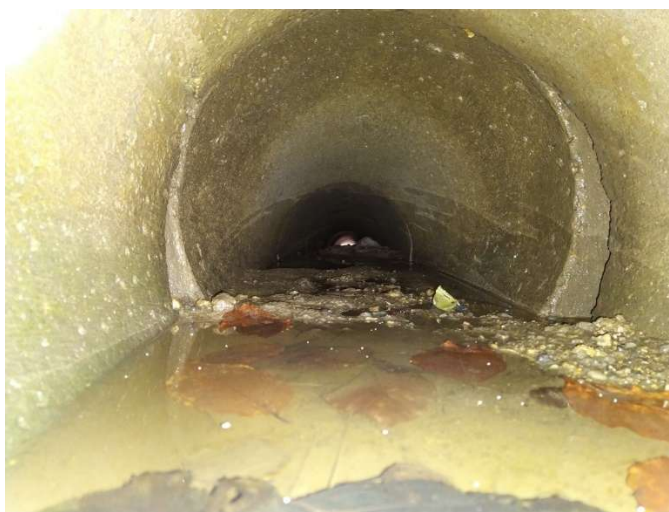
Propustek 350-005P – nerovnoměrné sednutí trub s nánosy
