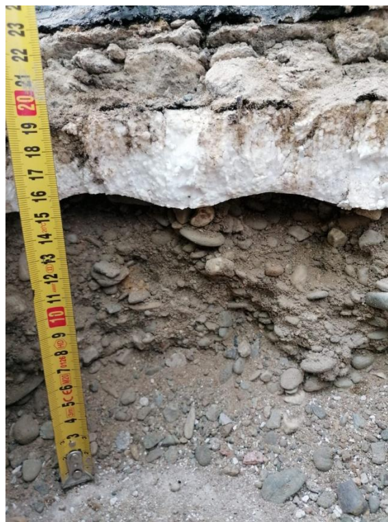
Obrázek 2: Fotografie sondy do střešního pláště objektu kotelny – vrchní část skladby
