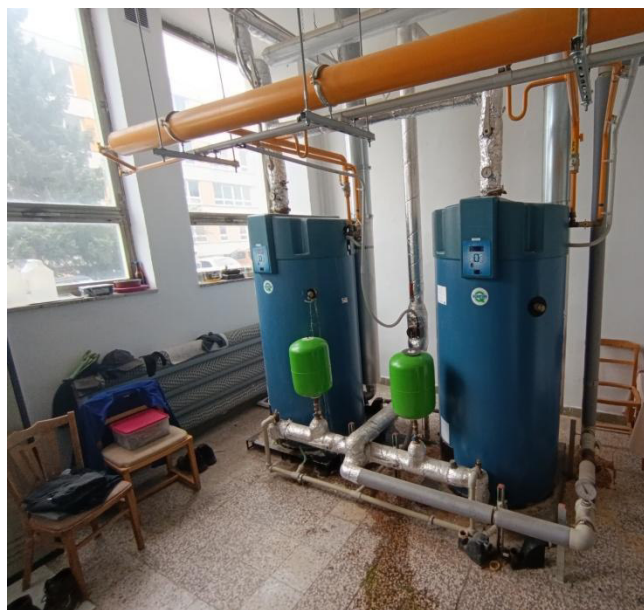
Obrázek 1: Stávající stav osazení a napojení stacionárních kondenzačních zásobníkových ohřivačů vody, schéma připojení
