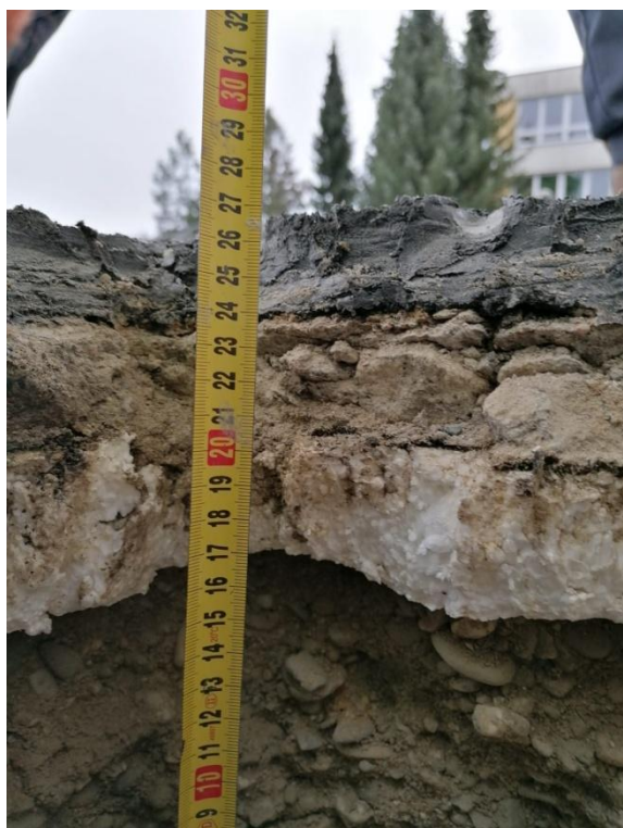
Obrázek 2: Fotografie sondy do střešního pláště objektu kotelny – vrchní část skladby
