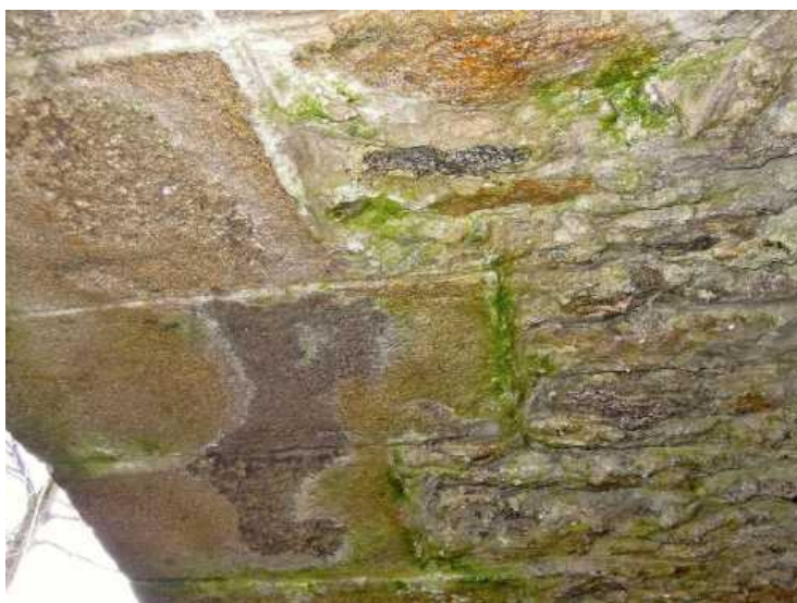
NK, pravá strana, aktivní silné zatékání, mikroorganismy, podélná trhлина podél krajního pasu klenby.
