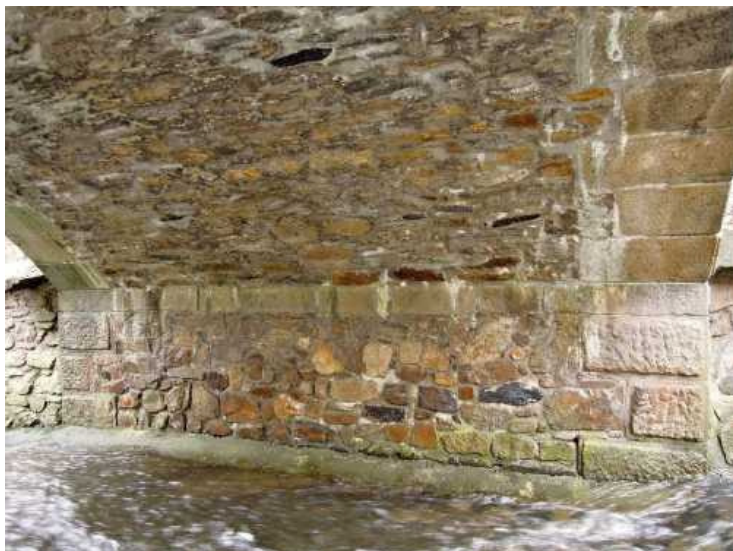
Celkový pohled na opěru 1, plošné průsaky na podhledu klenby, nejintenzivnější podél krajního pasu.
