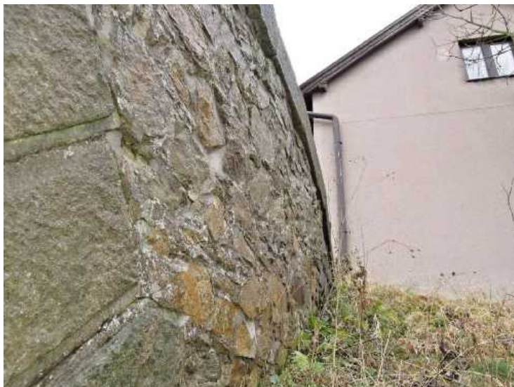
Dtto, pohled zdola na deformované křídlo.
