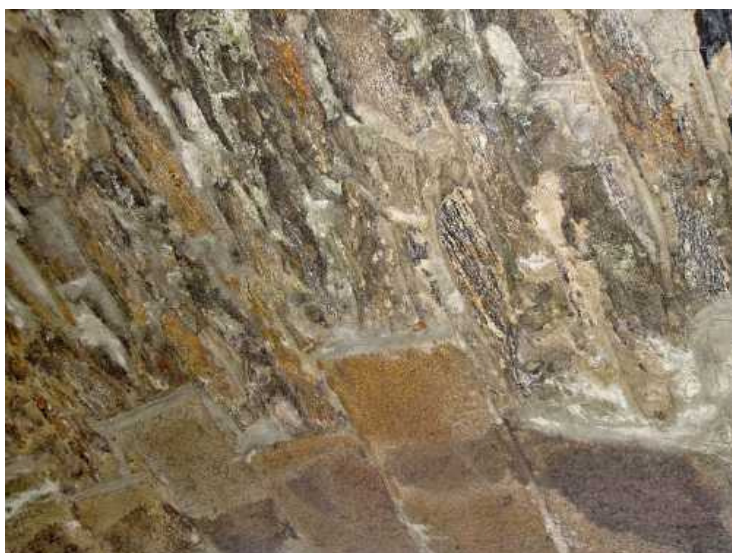
Detail vrcholové části klenby na levé straně, plošné aktivní zatékání - typický stav. Opakovaně opravované spárování.
