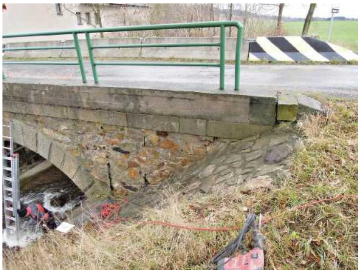
Levé křídlo OP1, doplněné a přespárované zdivo - na konci v horní části znovu popraskané.
