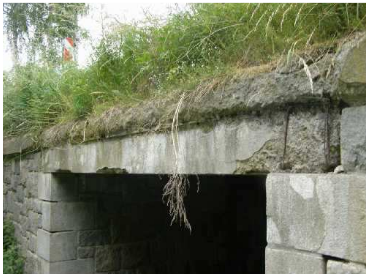
Rozpad betonu římsy.
