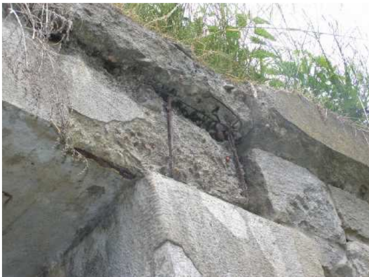
Degradace betonu nosné konstrukce vpravo v místě uložení na OP2.
