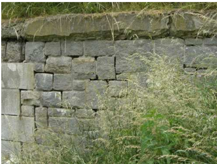
Vypadané spárování křídel.
