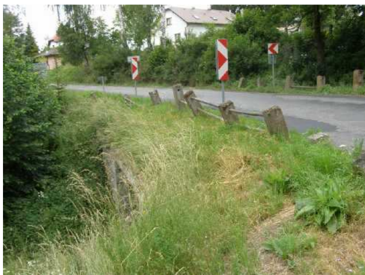
Zemní těleso nad nosnou konstrukcí.
