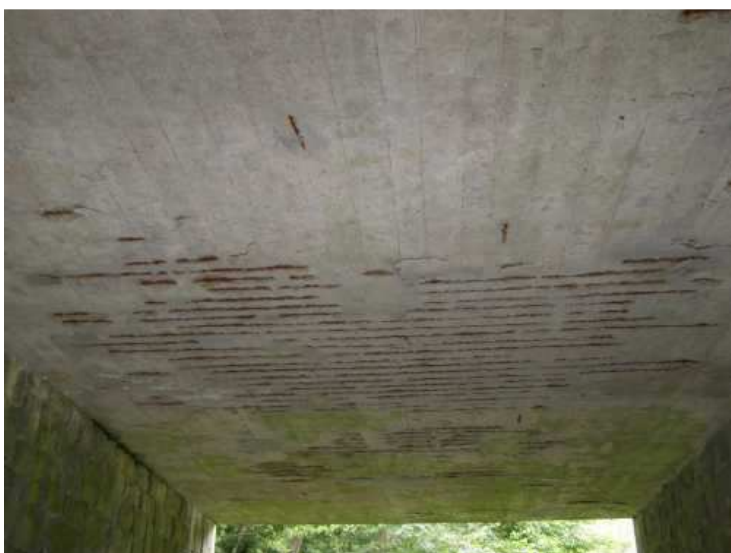
Pohled na dolní líc NK, nedostatečná tl. krycí vrstva, obnažená výztuž koroduje.
