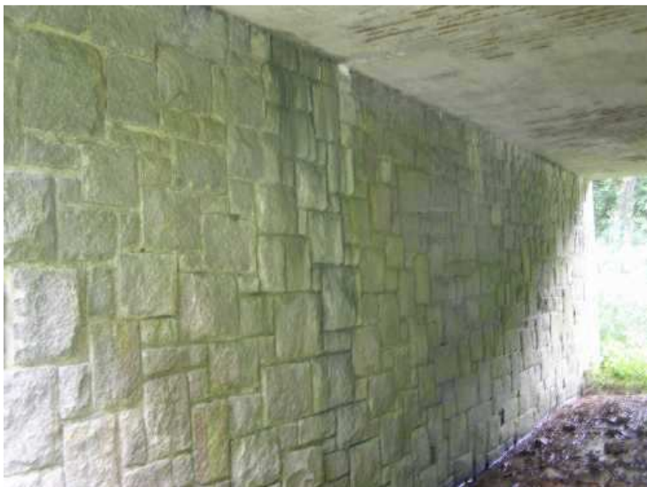
Pohled na opěru OP1, slabý průsak s výluhy ze spáry pod nosnou konstrukcí.
