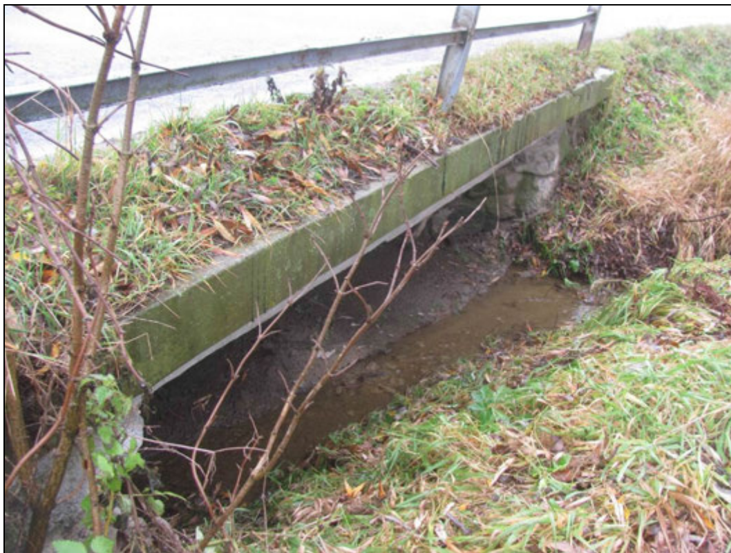
Foto 1: Celkový pohled na mostní konstrukci. Viditelné zanesení koryta.
