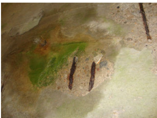
Obr. 15: Detail průsaků okolo ucpané trubičky odvodnění. (mezi trámem 1a 2 )
