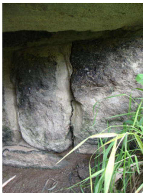
Obr. 30: O1 – u vtoku – trhлина ve spárování zdiva
