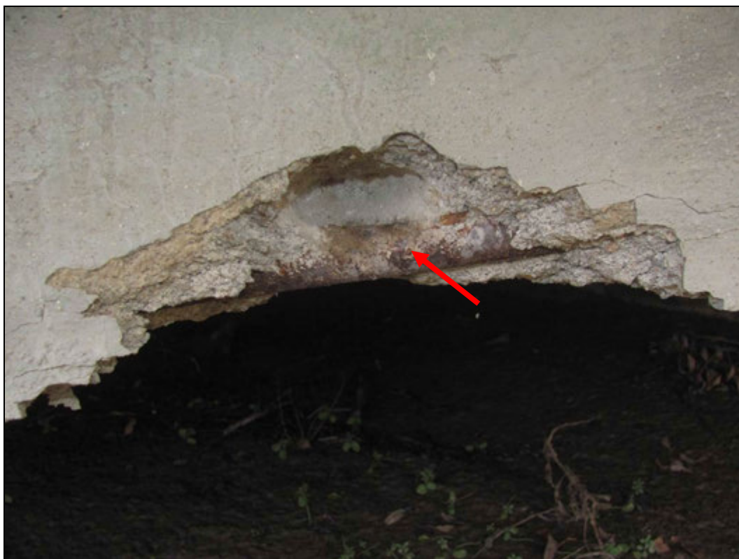
Foto 2: Provedení sondy k ověření vyztužení a stavu výztuže, spodní líc trámu. Lokální povrchová koroze.
