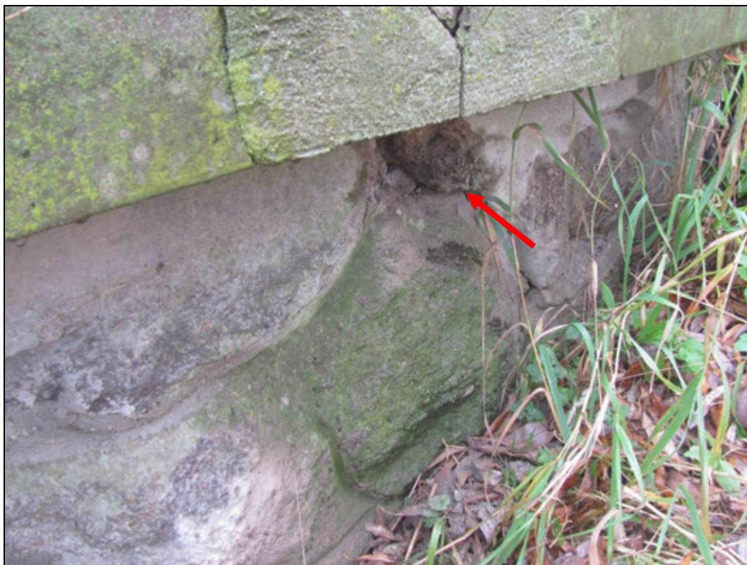
Foto 3: Provedení sondy k ověření hloubky degradace spárování.
