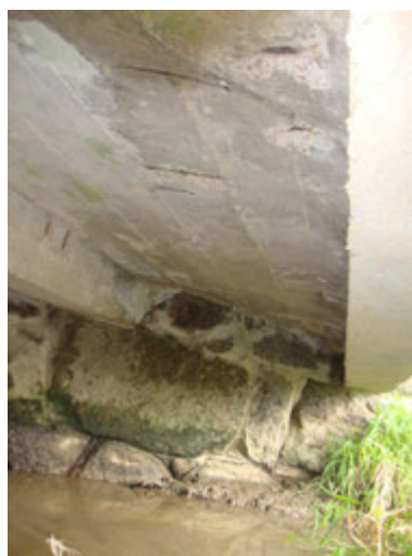
Obr. 24: Levá římsa - trhliny
