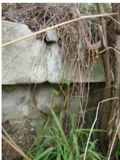
Obr. 23: O2 - levá římsa - trhliny
