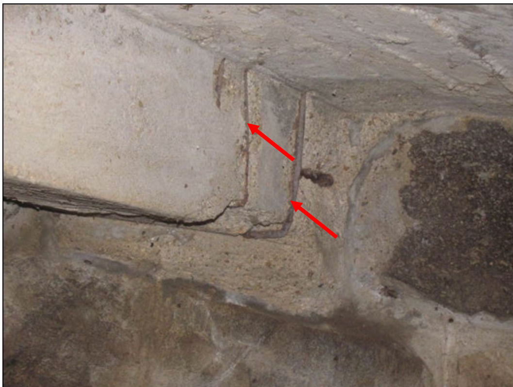
Foto 4: Detail koroze smykové výztuže u uložení trámů. Povrchová až silná koroze.
