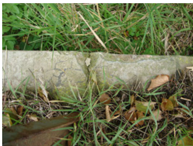
Obr. 18: Levá římsa - trhliny
