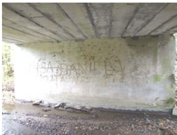
Obr. 14: Pravostranná opěra, stopy po zatékání.
