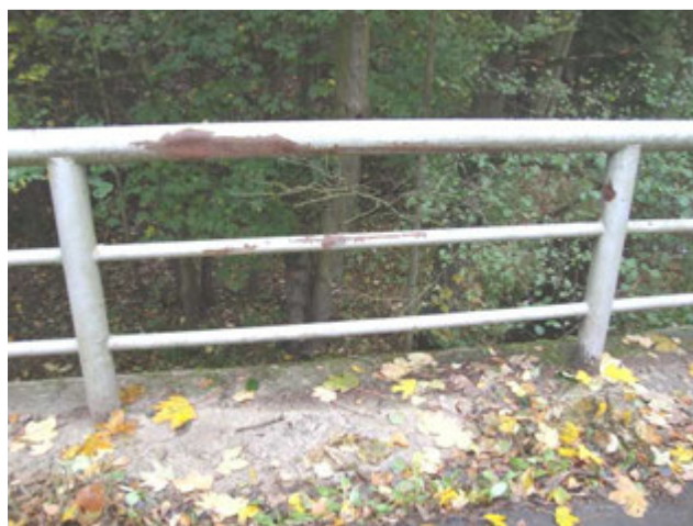
Obr. 2: Vegetace ve spáře mezi římsou a vozovkou.
