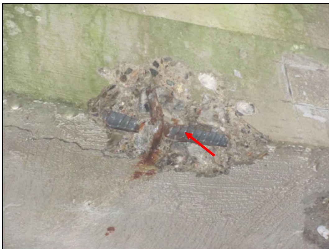
Foto 2: Pohled na provedenou sondu k výztuži nosníku, povrchová koroze třmínů.
