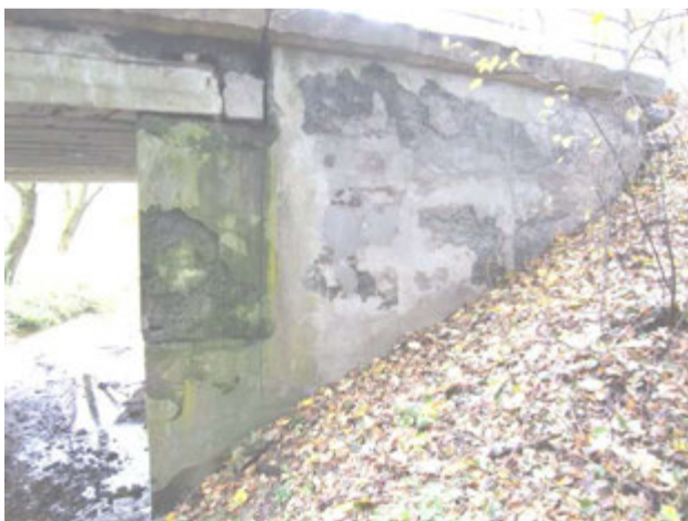
Obr. 9: Křídlo pravé opěry na protivodní straně.
