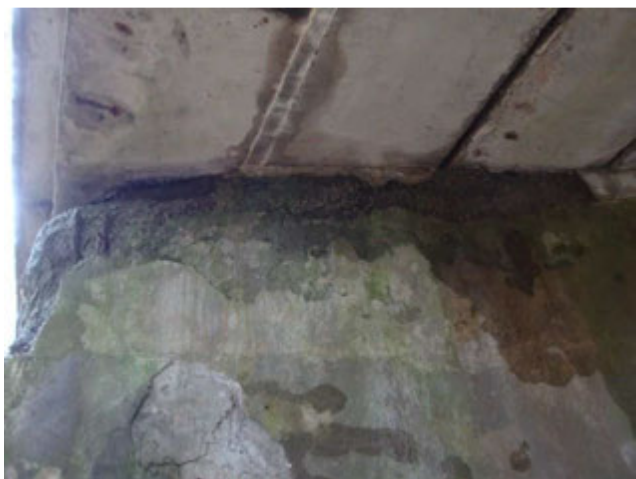
Obr. 15: Detail levostranné opěry, silné zatékání, koroze výztuže úložného prahu.
