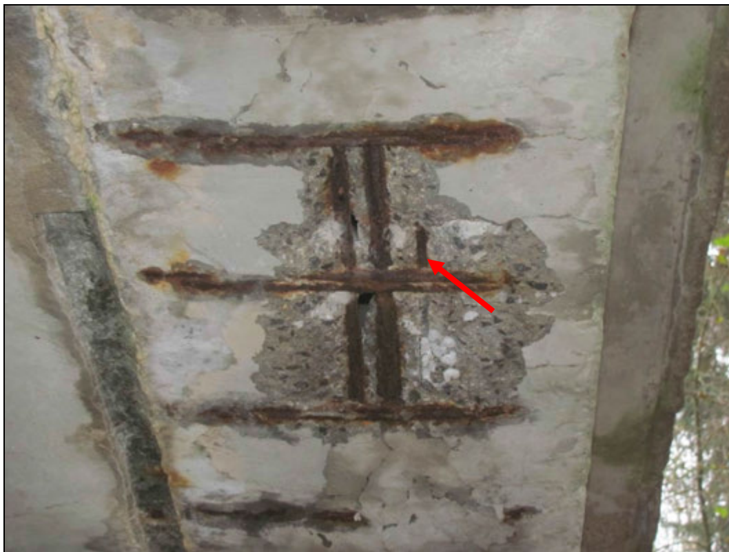
Foto 3: Pohled na spodní líc nosníku. Silná koroze bet. výztuže a třmínků.
