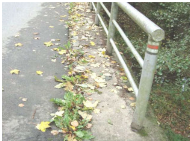
Obr. 2: Vegetace ve spáře mezi římsou a vozovkou.
