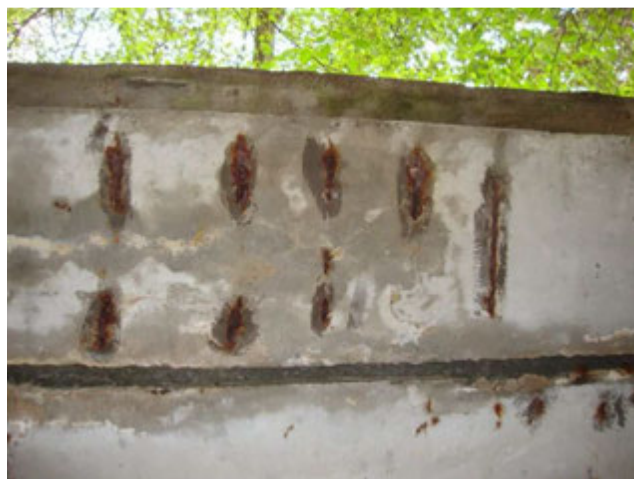
Obr. 16: Koroze třmíneků krajního nosníku, stopy po silném zatékání.
