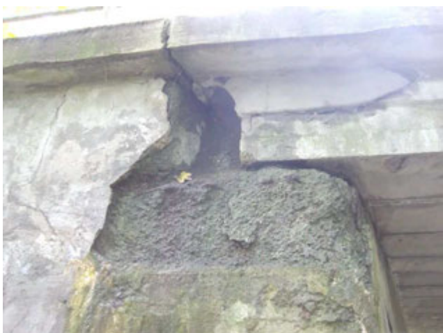
Obr. 13: Detail úložného prahu, silné zatékání.
