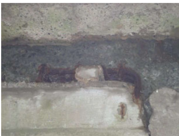
Obr. 11: Detail křídla, koroze výztuže.
