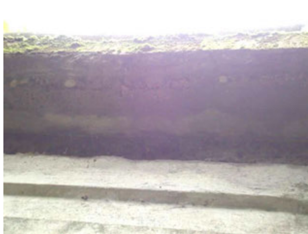
Obr. 18: Detail vlhké římsy.
