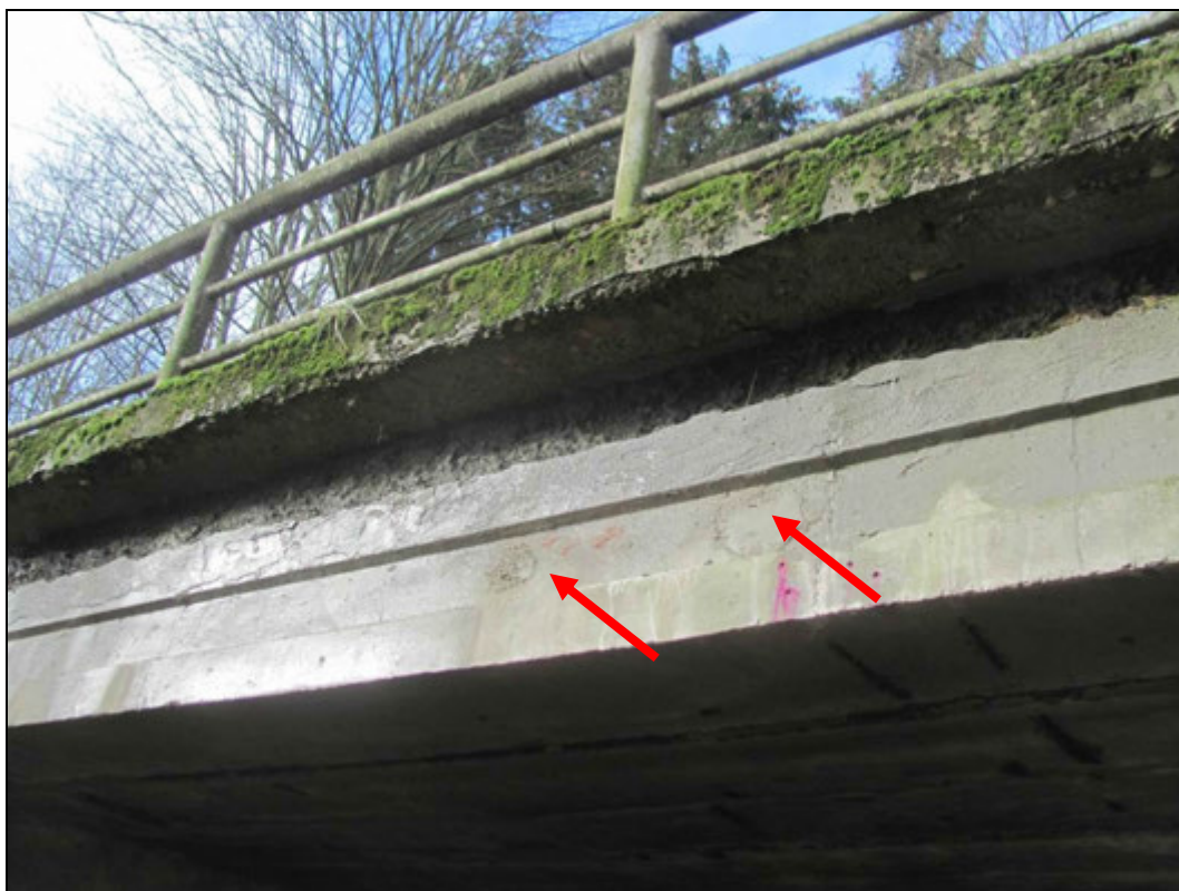
Foto 4: Detail zapravení otvorů pro provedených jádrových vrtech.
